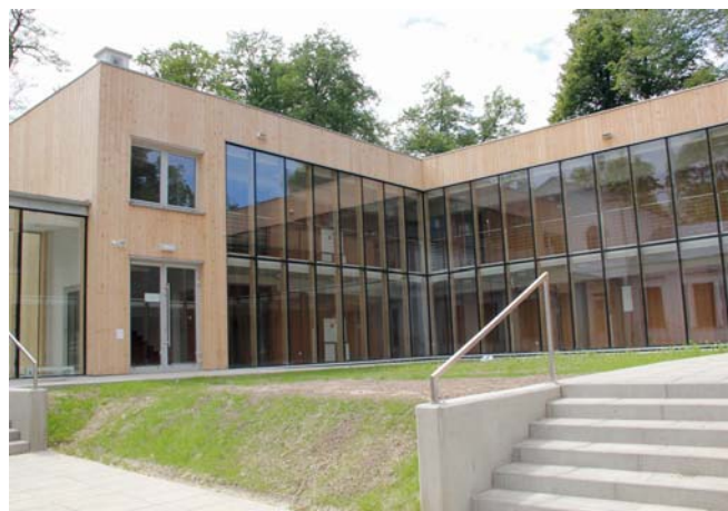
Nowo wybudowany Internat w Kęble
