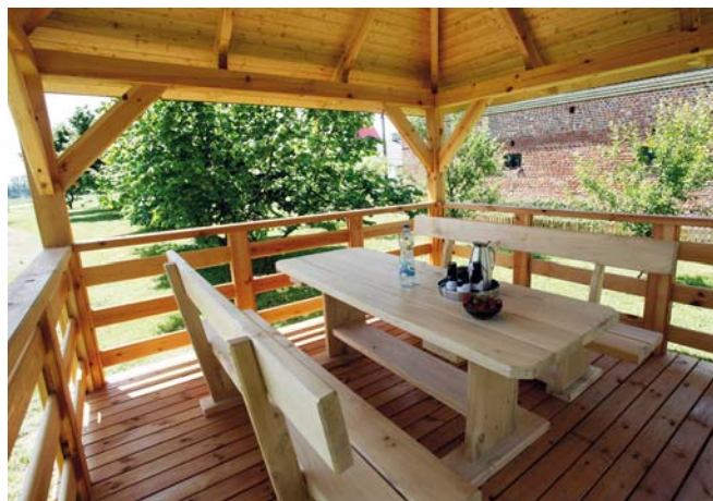
Altana „Owocowy Przystanek” wybudowana w ramach projektu
