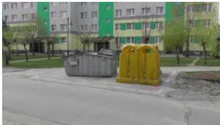
Wykonane utwardzenie miejsca pod pojemniki na śmieci przy bloku nr 8 na ul. Leśnej
