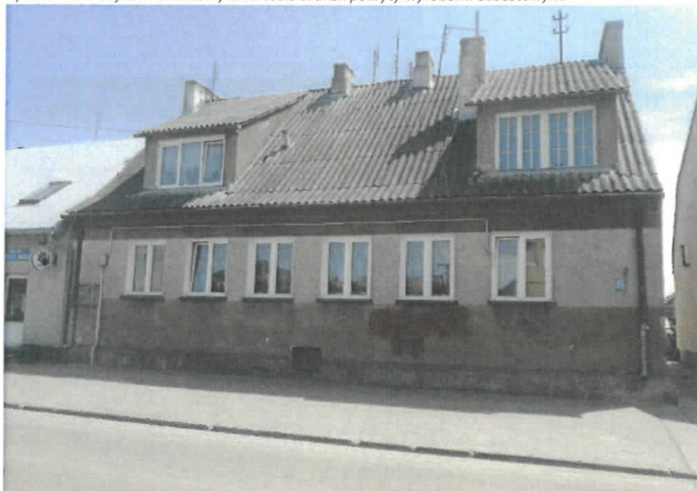
Rysunek 29 Budynek komunalny w mieście Brańsk pokryty wyrobami azbestowymi
