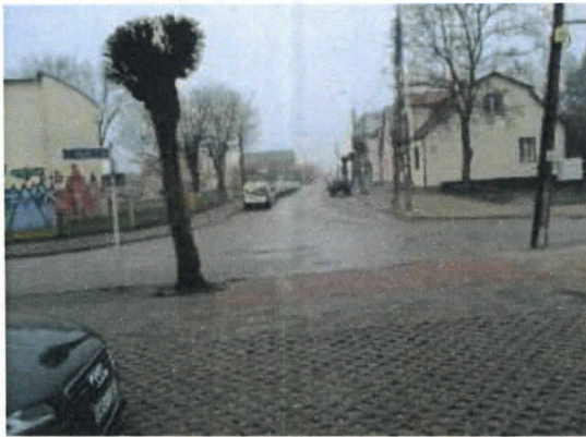
Wykonana/przełożona nawierzchnia z płyt ażurowych
