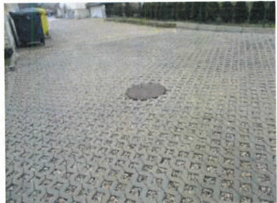
Wykonana/przełożona nawierzchnia z płyt ażurowych
