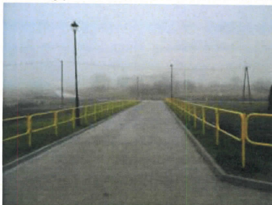
Ciąg pieszo-jezdny z kostki betonowej, korytko ściekowe, elementy wykonanego oświetlenia
