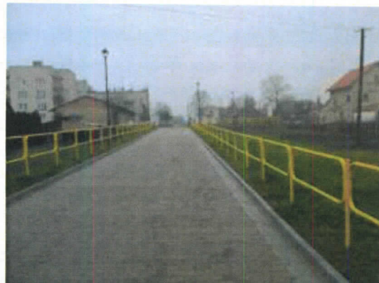
Ciąg pieszo-jezdny z kostki betonowej, korytko ściekowe, elementy wykonanego oświetlenia
