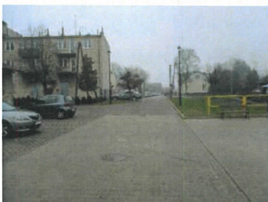
Ciąg pieszo-jezdny z kostki betonowej, miejsca parkingowe z płyt ażurowych
