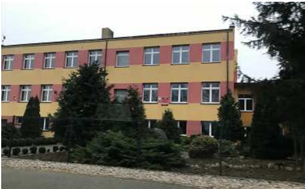
Fot. 6. Szkoła w Korytach
