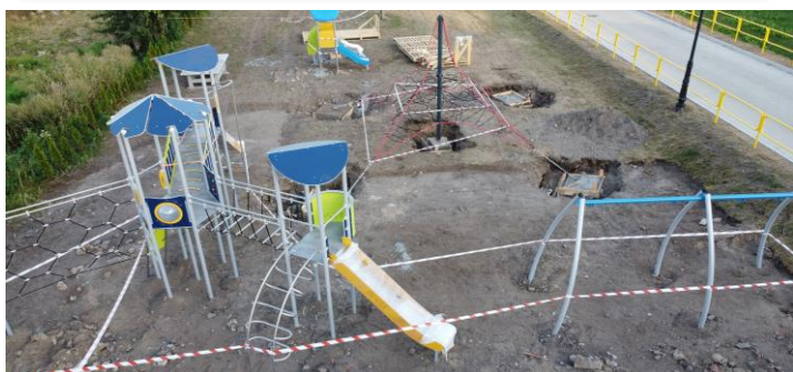
Zdjęcie w trakcie budowy.
