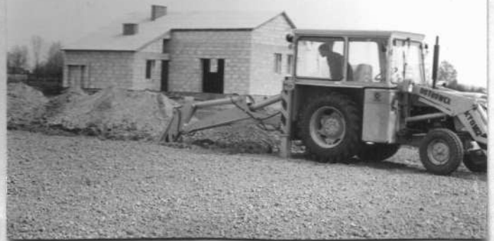
Operator koparki Zygmunt Beda w akcji. W głębi budynek hydroforni.
