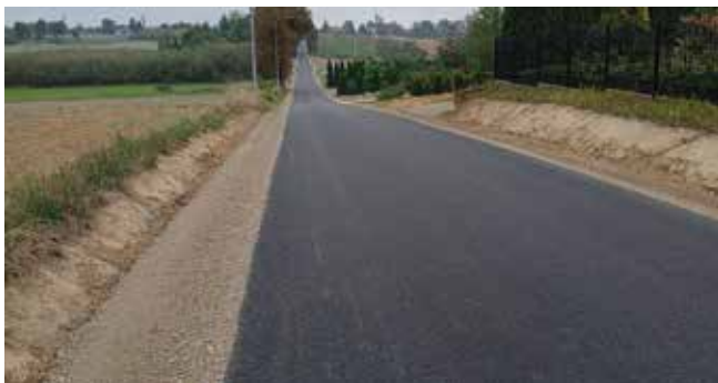
Nowa nawierzchnia asfaltowa na ulicy Kasztanowej
