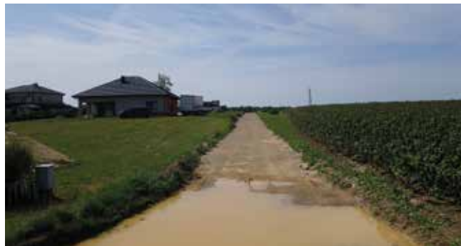
Budowa drogi gminnej w Gutanowie
