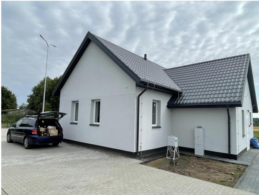
Stacja uzdatniania wody w Woli Zadybskiej
