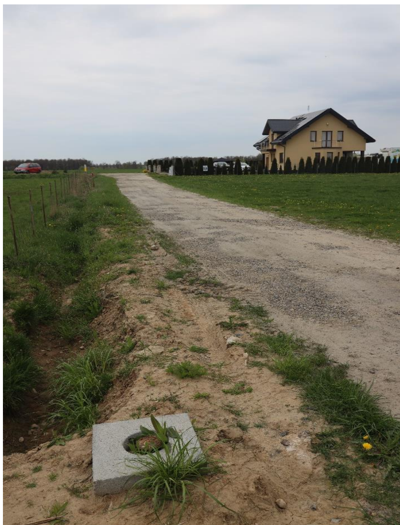
sieć wodociągowa – ul. ks. T. Augustynowicza
