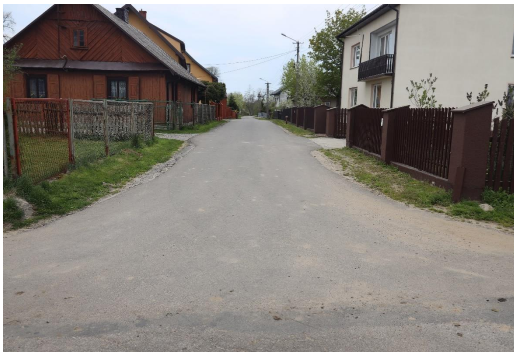
Droga gminna w miejscowości Bramka
