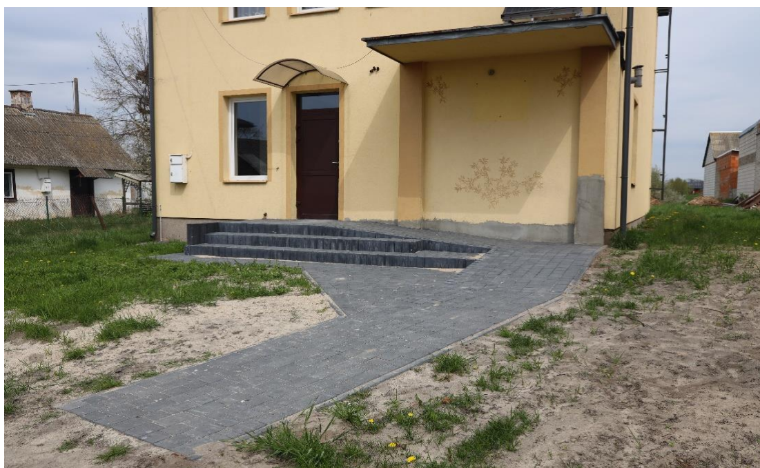
Gozd – remont schodów wejścia głównego do świetlicy
