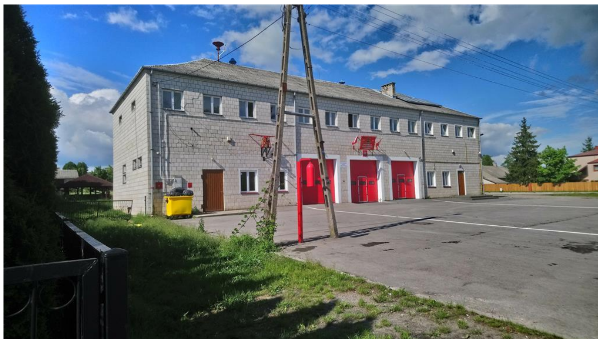
Stan przed remontem
