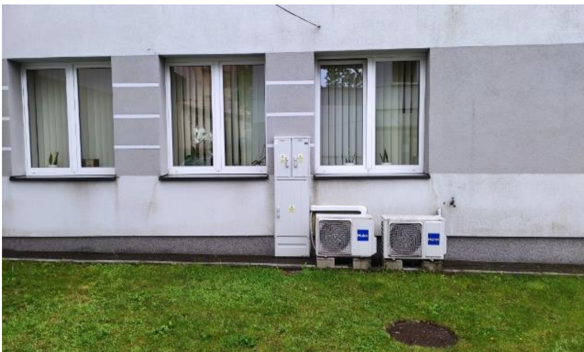
Modernizacja rozdzielnic elektrycznych
