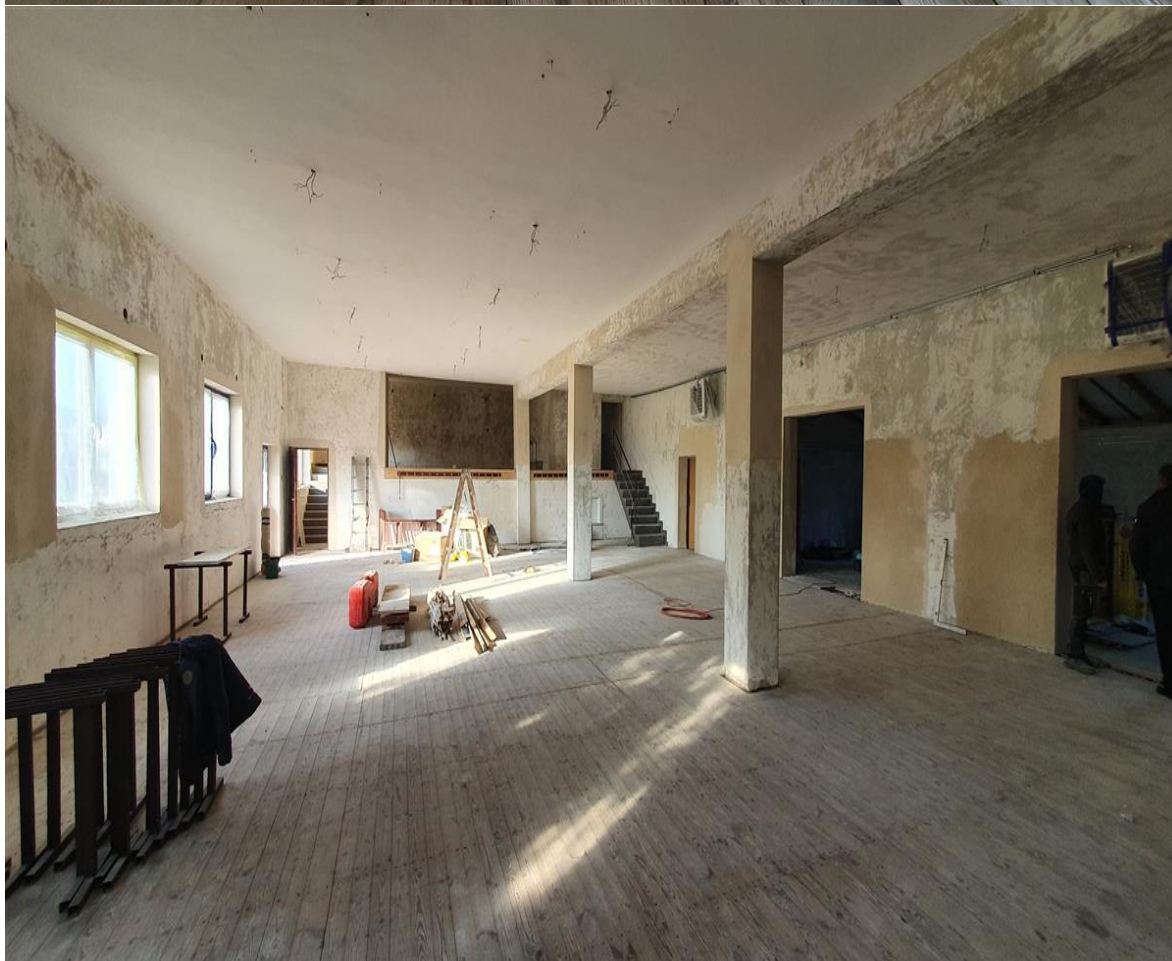
Stan przed modernizacją
