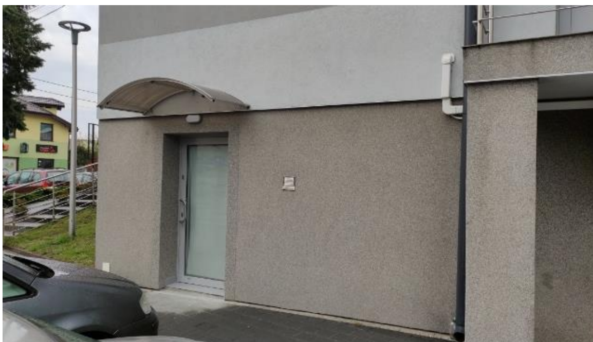
Wejście do remontowanych pomieszczeń piwnicznych budynku Urzędu Gminy
