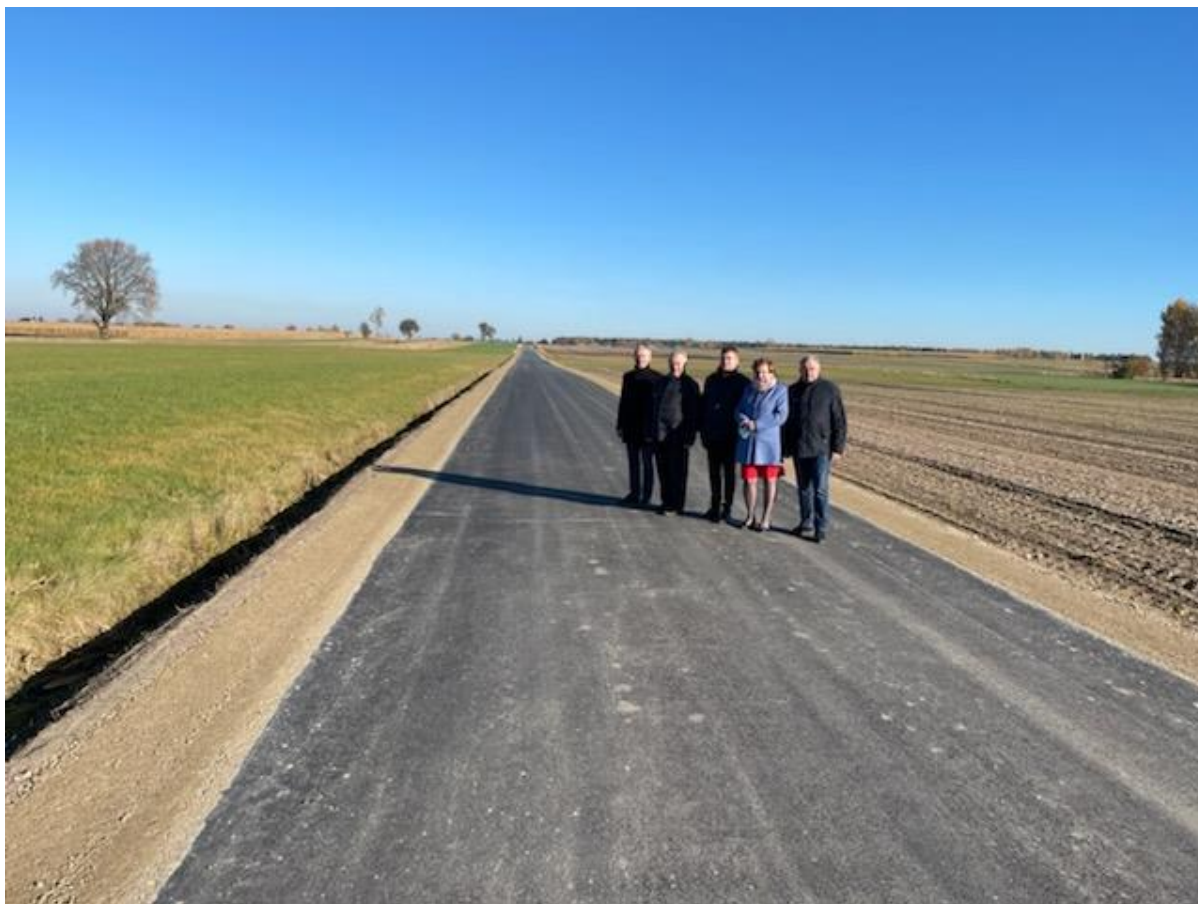
Przebudowa drogi w Czernicu
