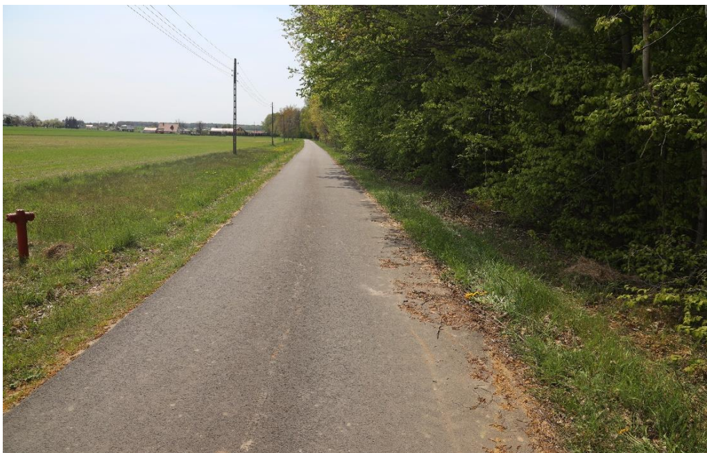
Droga gminna w miejscowości Wola Zadybska
