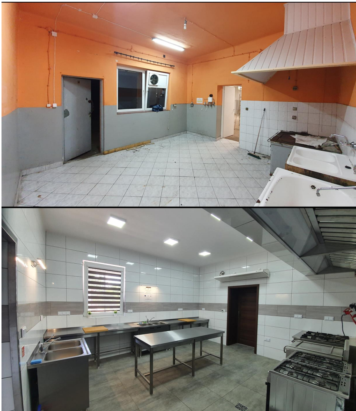
Stan przed i po modernizacji
