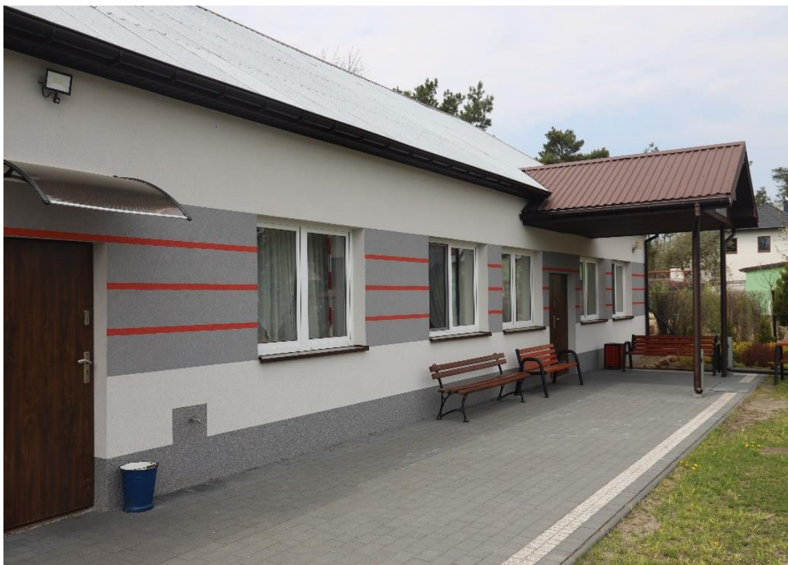
Nowe Zadybie – ocieplenie i elewacja świetlicy- strażnicy
