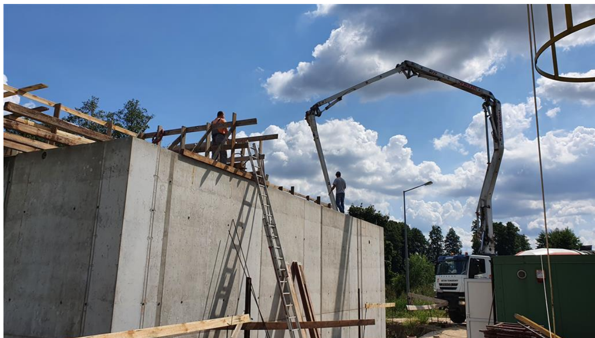
Rozbudowa oczyszczalni ścieków
