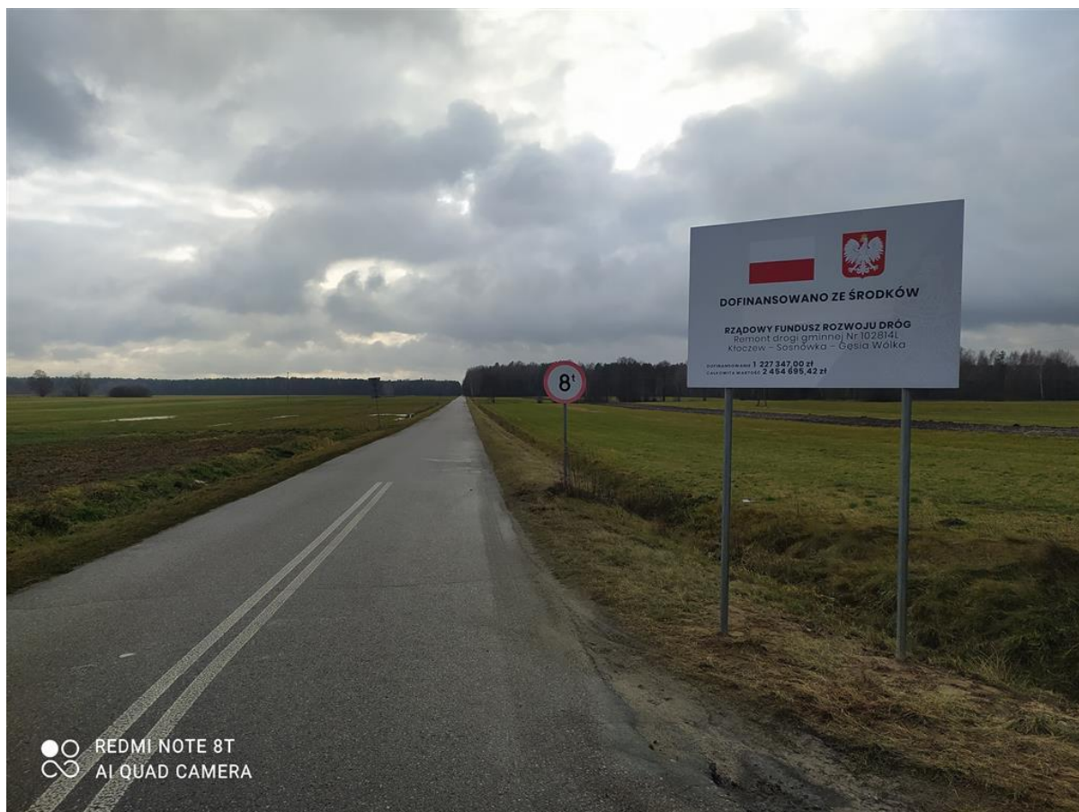
Przebudowa drogi gminnej Kłoczew – Sosnówka – Gęsia Wólka.
