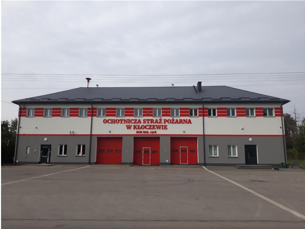
Stan po remoncie
