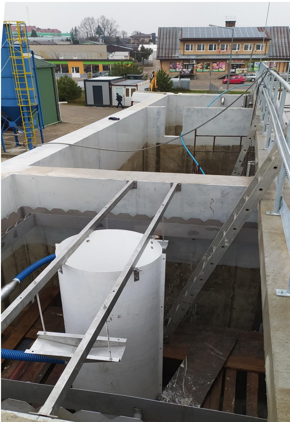
Rozbudowa oczyszczalni ścieków
