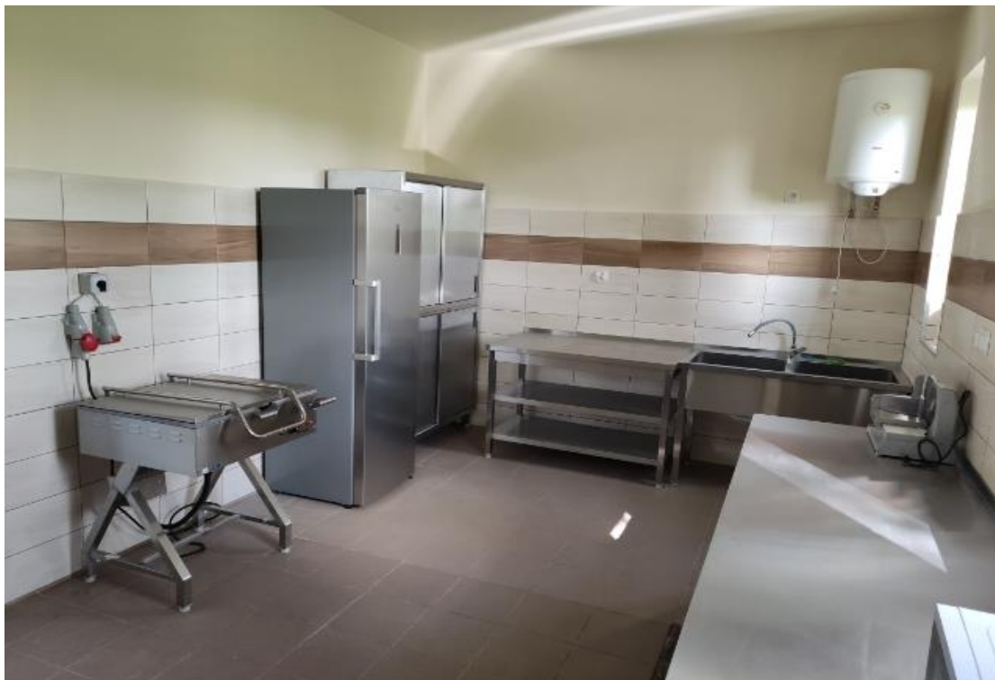
Kawęczyn – remont pomieszczenia kuchennego świetlicy
