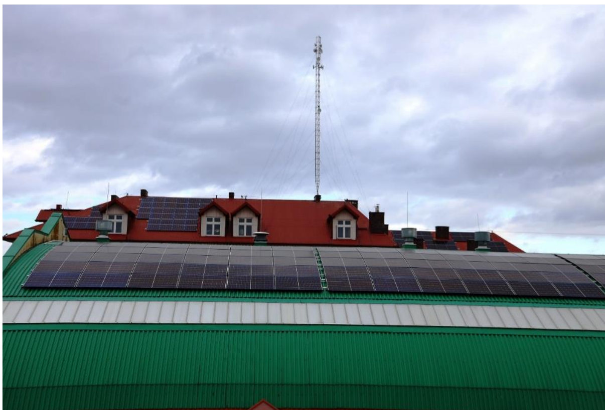
Instalacje FV na budynku użyteczności publicznej – SP Kłoczew
