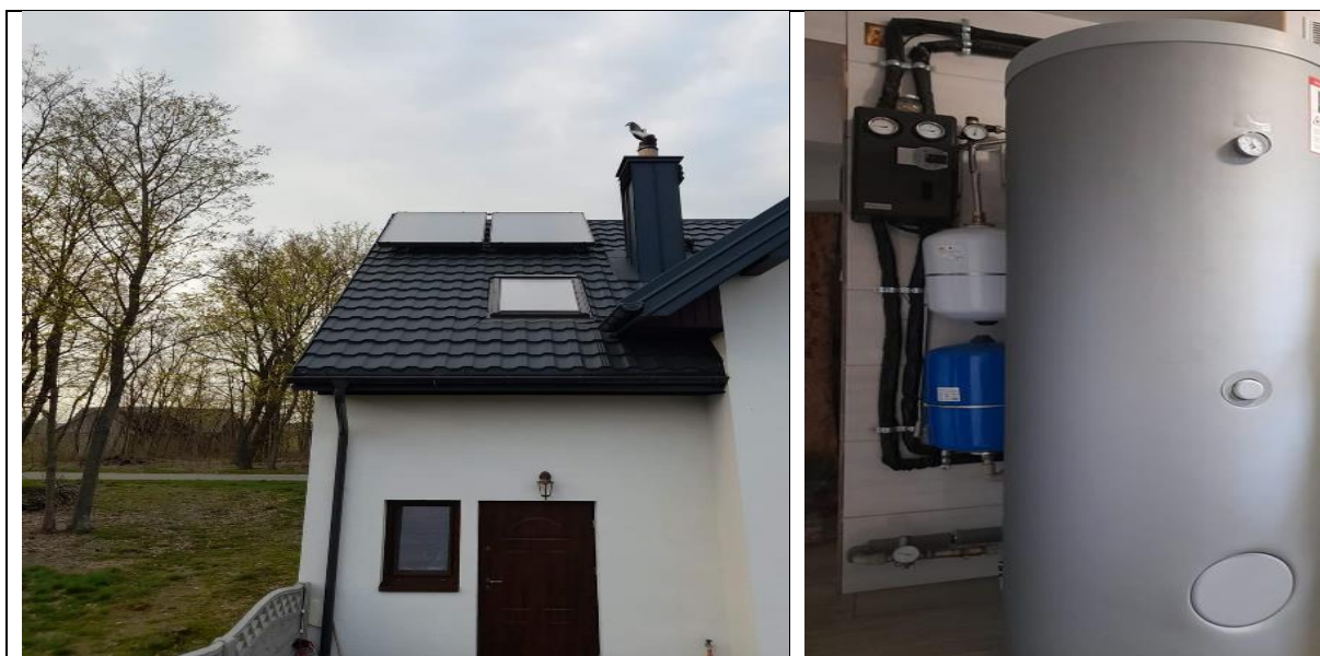
Dostawa i montaż instalacji solarnych
