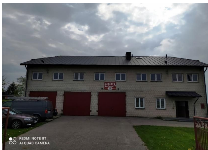
Budynek OSP Wola Zadybska – stan istniejący
