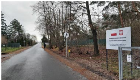
Przebudowana ulica Bławatna
