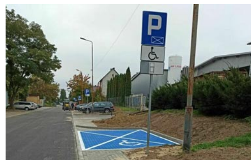
Zmodernizowana ulica Porucznika Zręba
