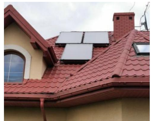
Kolektory słoneczne na budynku jednorodzinny
