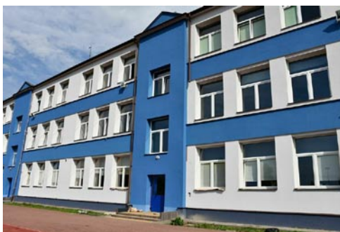
Odnowiona elewacja Szkoły Podstawowej nr 5
