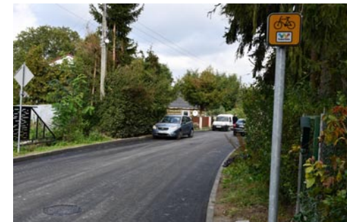
Przebudowana ulica Kickiego
