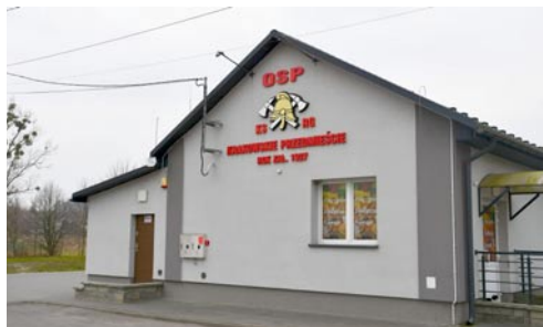
Przebudowana remiza OSP Krakowskie Przedmieście
