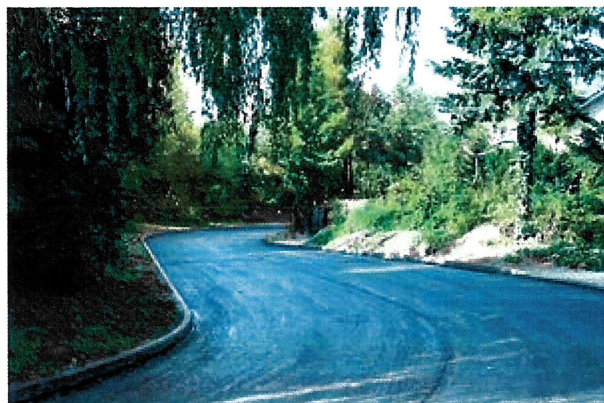
Zdjęcie 2: Przebudowa i rozbudowa ul. Kickiego
