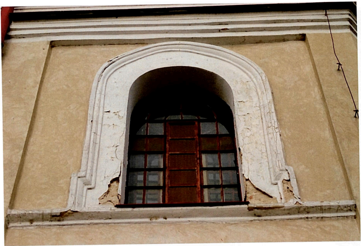
Fot. 29 Kościół p.w. Św. Józefa w Markuszowie. Widoczny stan profili ciągnionych, gzymsów i obramienia okiennego. Widoczny stan zachowania okien.
