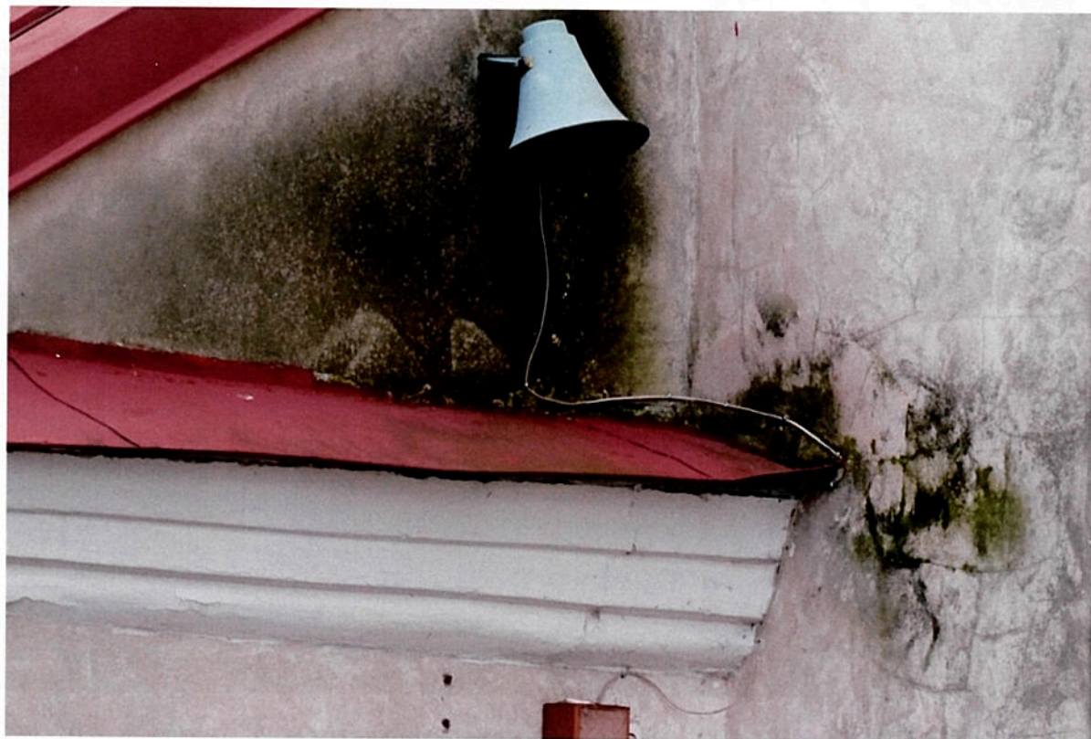
Fot. 25 Kościół p. w. Św. Józefa w Markuszowie; fragment zakrystii przylegającej do prezbiterium od strony północnej. Widoczne zagłobienie muru.
