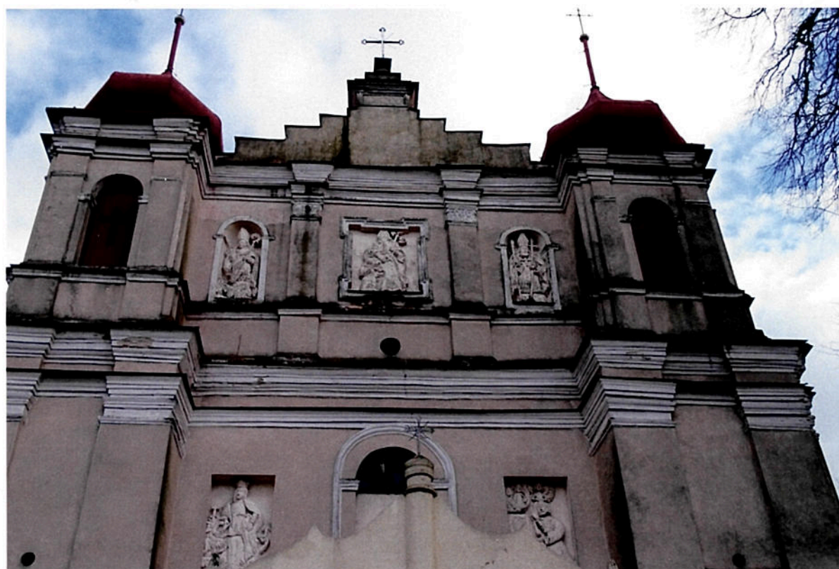
Fot. 1, 2 Kościół p.w. Św. Józefa w Markuszowie. Widok na elewację frontową kościoła.
