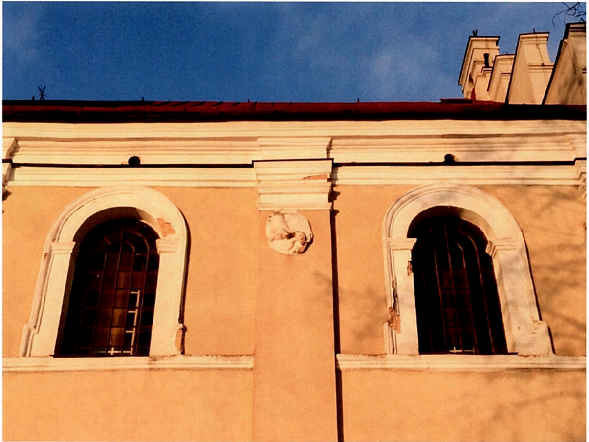
Fot. 33 Kościół p.w. Św. Józefa w Markuszowie. Widoczny stan profili ciągnionych, gzymsów i obramienia okiennego.
