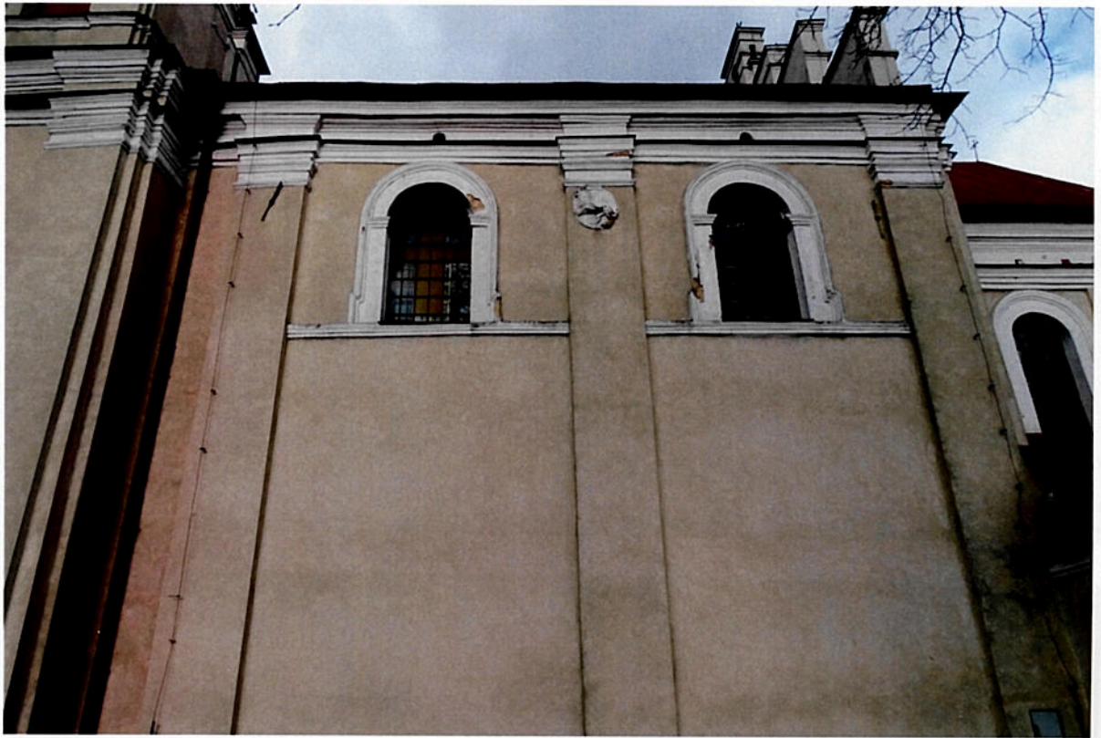
Fot. 21-24 Kościół p. w. Św. Józefa w Markuszowie. Widok na elewację północną. Widoczne płaskorzeźby, obramienia okienne i gzymsy w analogicznym stanie, jak na elewacji frontowej.
