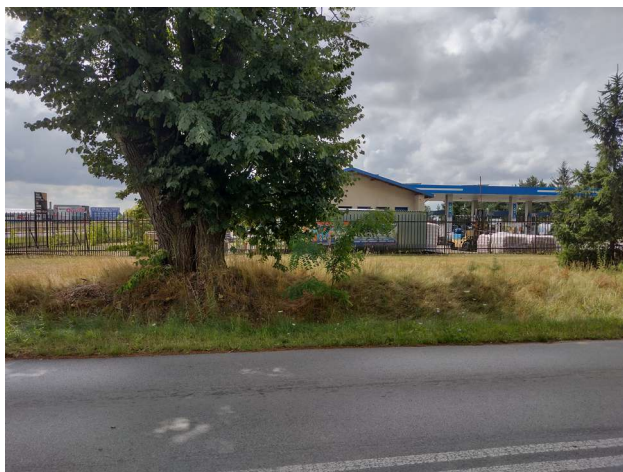
Fot.5. Stacja benzynowa w ciągu drogi wojewódzkiej
