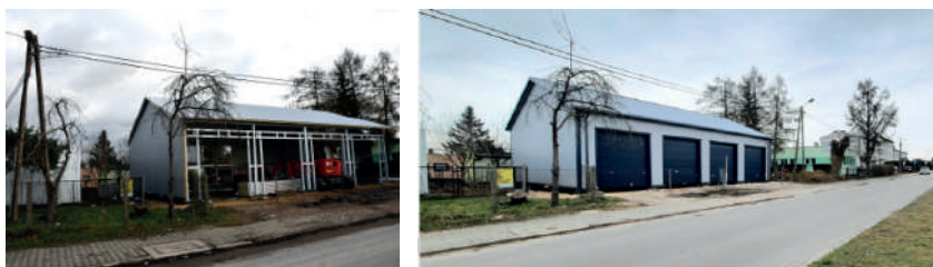
Wybudowana wiata garażowa w miejscowości Niedźwiada- Kolonia
