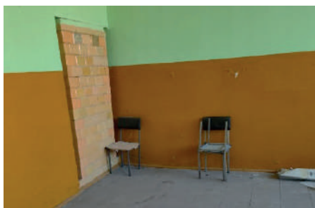
Świetlica wiejska w Zabelu przed remontem
