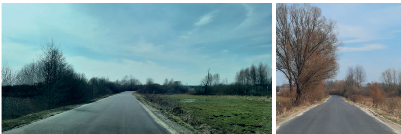
Wyremontowany odcinek drogi pomiędzy m. Zabiele a m. Brzeźnica Bychawska.
