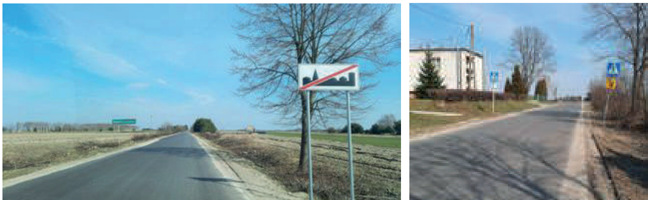
Wyremontowany odcinek drogi w Brzeźnicy Książęcej.
