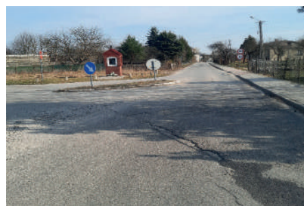
Zdjęcie drogi przed remontem w miejscowości Tarło.
