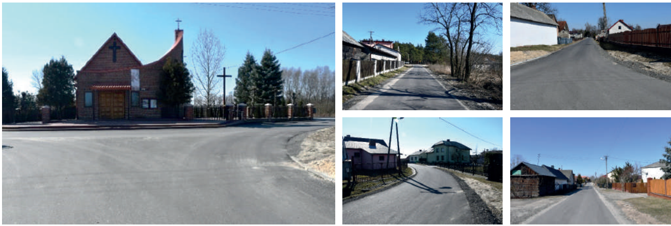
Wyremontowane drogi w Górcze Lubartowskiej po wykonaniu budowy sieci kanalizacyjnej
