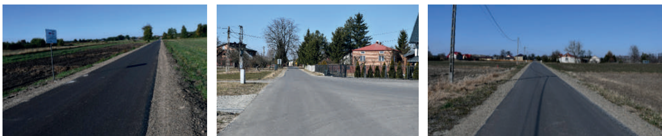
Wyremontowane drogi w Brzeźnicy Leśnej
