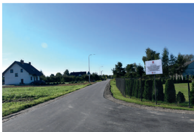
Droga po remoncie w Niedźwiadzie
