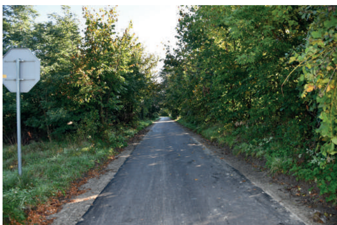
Wyremontowany odcinek drogi w Zabielu Kolonii
