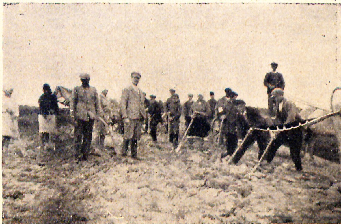
Roboty szarwarkowe przy budowie drogi w gminie Tarło.
