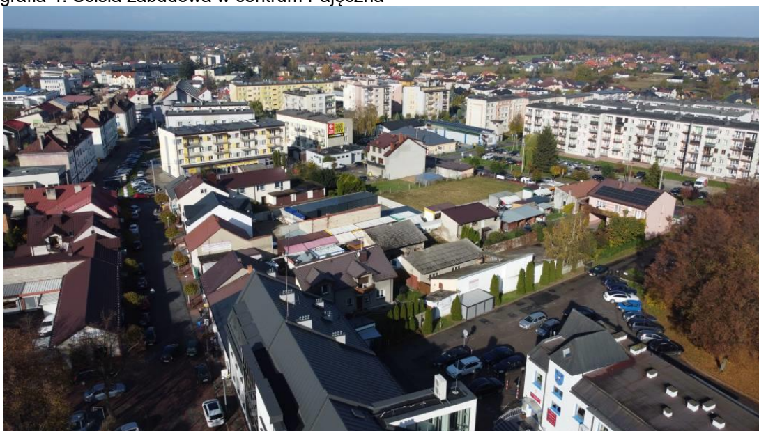
Fotografia 4. Ścisła zabudowa w centrum Pajęczna
