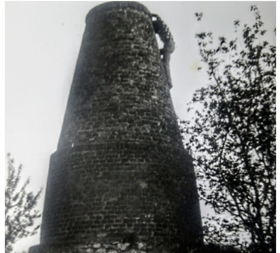
Wapiennik, charakterystyczny piec do obróbki termicznej wapienia, na terenie ziemi pajęczańskiej.
