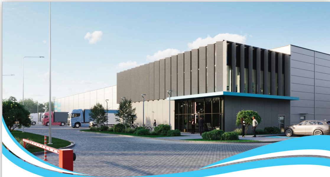
Hala produkcyjno-magazynowa lokalizacja: Chetm, woj. lubelskie powierzchnia: 5630 m 2
