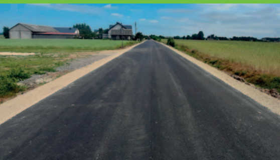
Remont drogi powiatowej nr 2500L w msc. Parafianka na odcinku od km 5+697 do km 7+575
