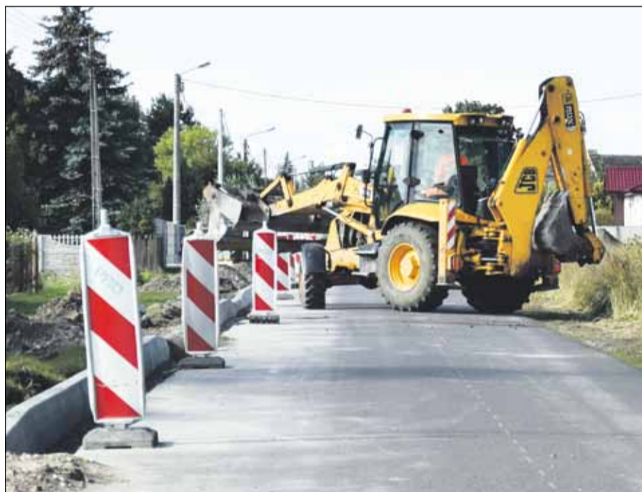
Prace na Osiedlu Robotniczym w Radłowie
