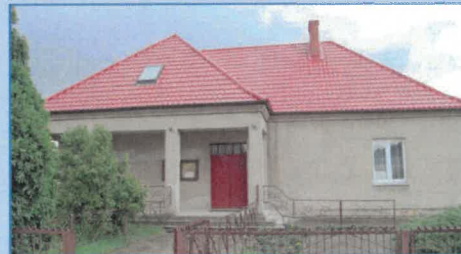
Nowy dach na świetlicy wiejskiej w Jaskółkach
