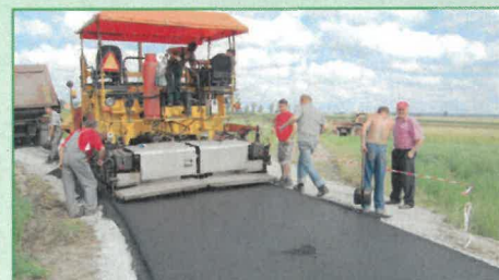
Przebudowa drogi w Korytnicy
