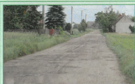
Droga w Skrzebowej przed rozbudową...
