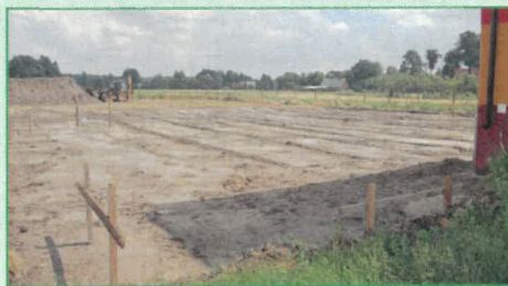
Budowa nowej sali sportowej w Korytach
