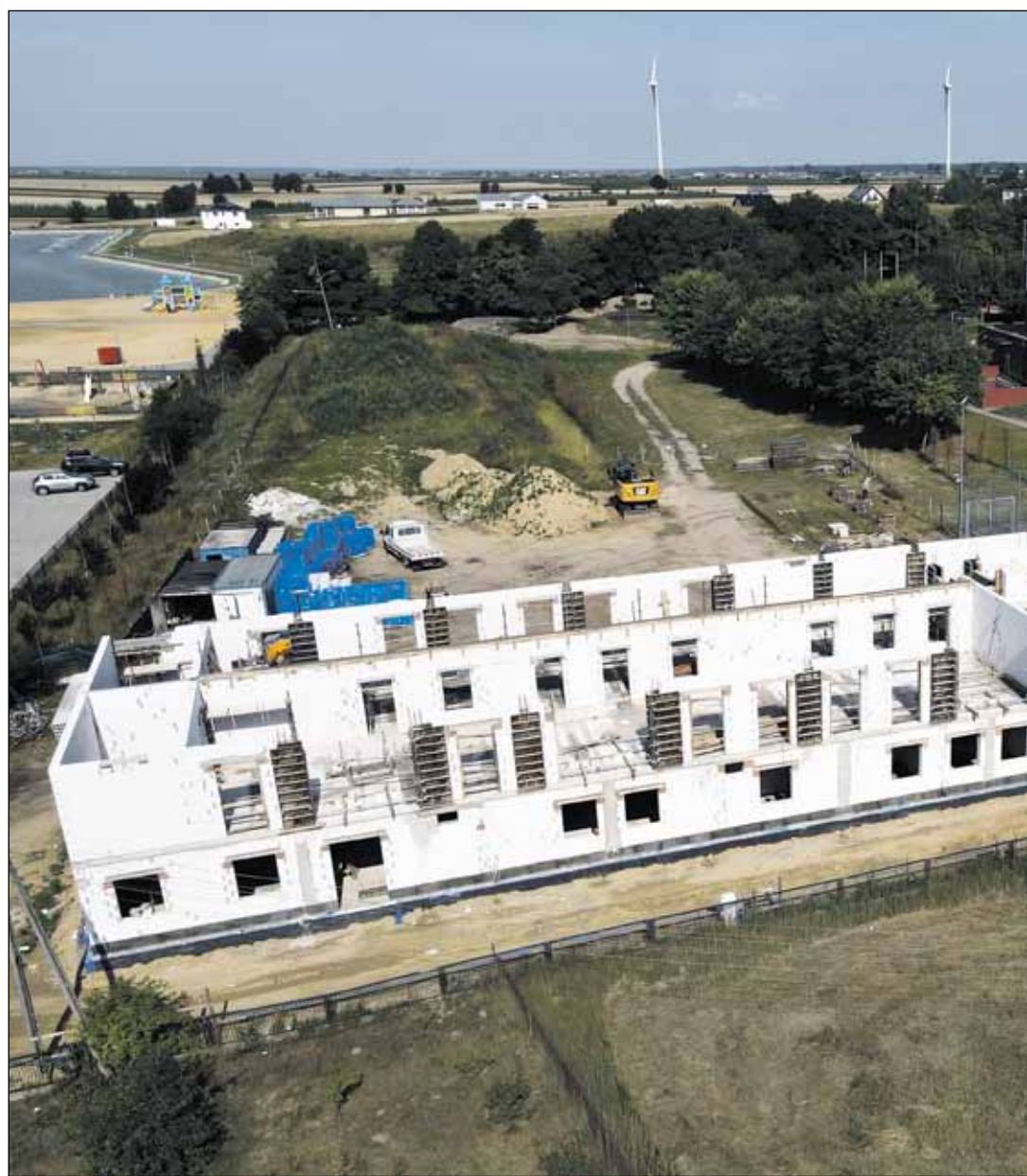
Budowa żłobka przy szkole w Raszkowie
