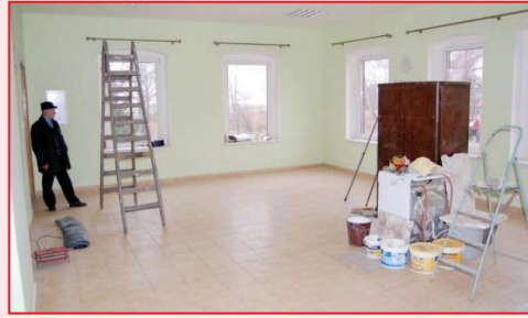
Remont sali wiejskiej w Jelitowie
