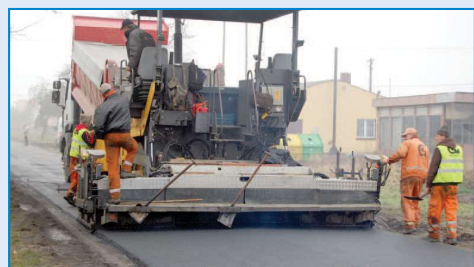
Remont drogi w Szczurawicach
