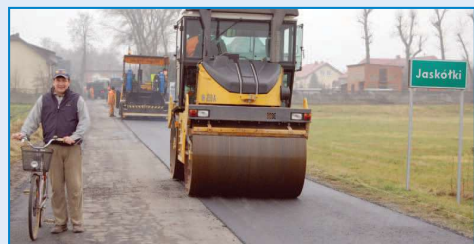
Remont drogi w Jaskółkach
