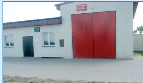
Nowopolożony chodnik przed świetlicą wiejską w Głogowej
