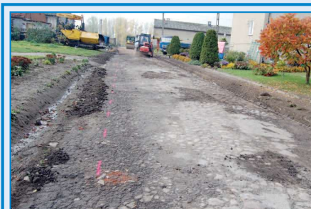
Droga w Bugaju przed przebudową
