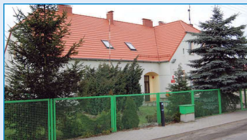
Nowy dach na Szkole Podstawowej w Bieganiu
