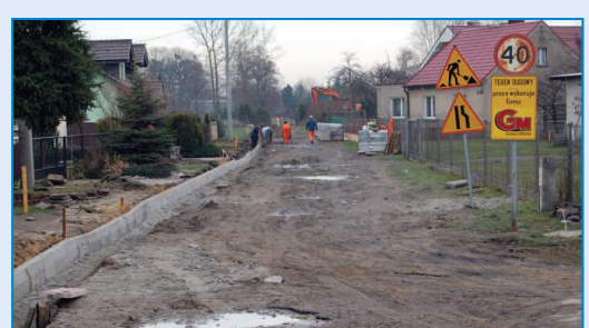
Przebudowa ulicy Łukowej w Raszkowie
