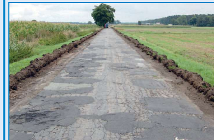
Droga w Jelitowie w trakcie przebudowy
