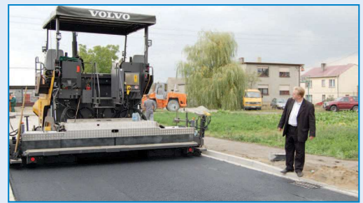
Nakładanie warstwy asfaltu na ul. Piaskowej w Raszkowie
