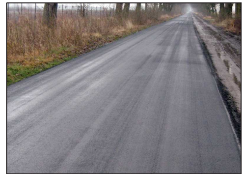
Droga po remoncie
