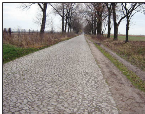
Droga przed remontem
