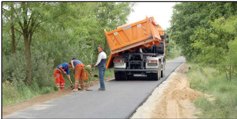
Budowa drogi w Korytach
