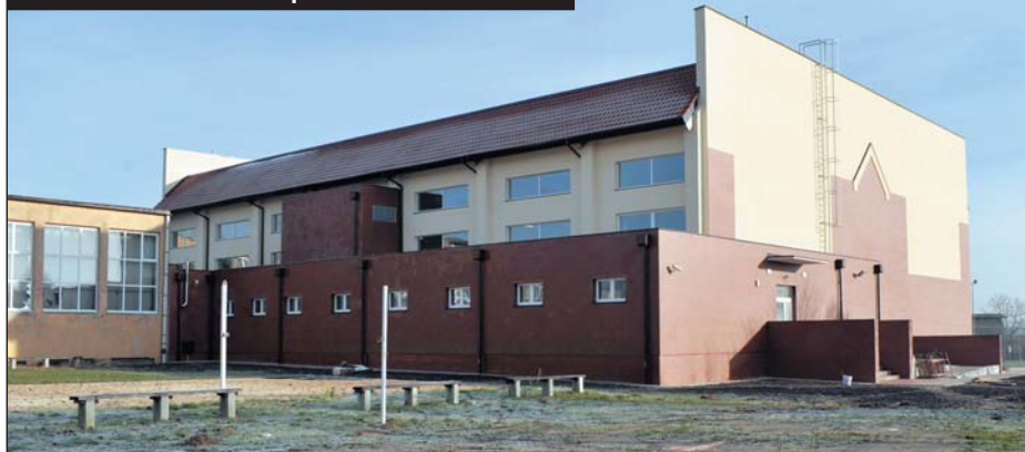
Hala widowiskowo - sportowa w Raszkowie
