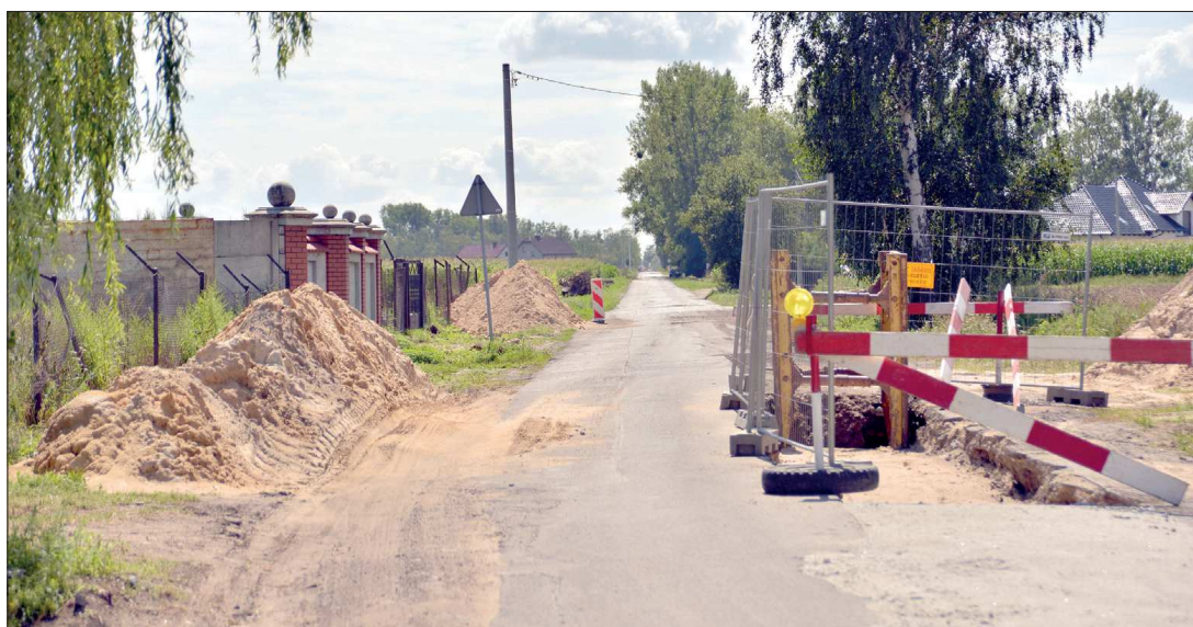
Remont drogi w Radłowie
