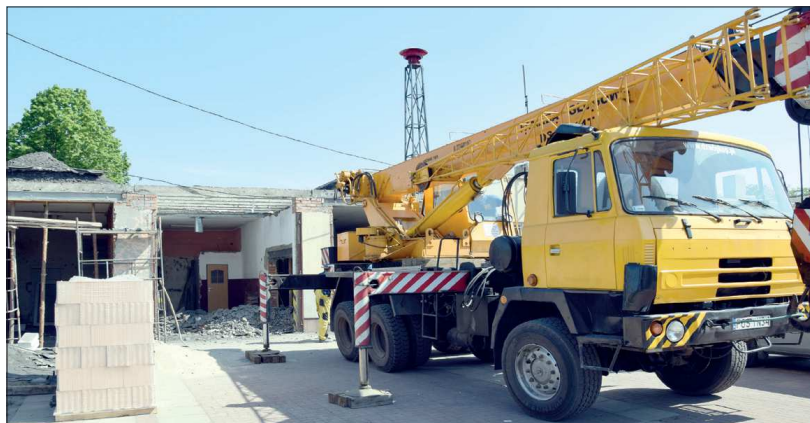
Remont remizy w Raszkowie
