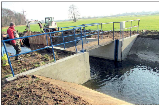
Jaz po remoncie
