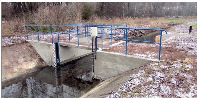
Jaz po remoncie
