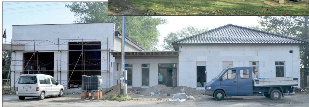
Sala w Jankowie Zalesnym w trakcie budowy
