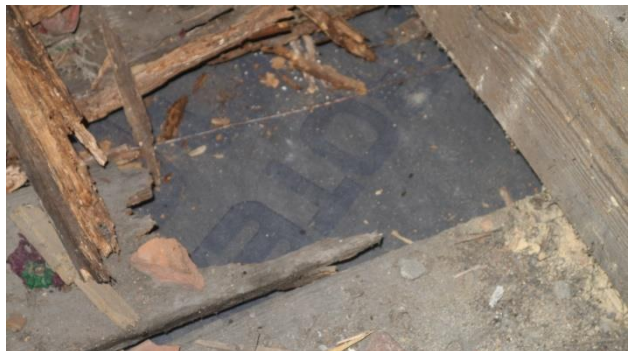
Fot. 33 Uszkodzone deski od strony strychu, zabezpieczone od spodu membrana, Deski zbutwiałe, tzw. próchno, powstałe w wyniku ok. 100% rozkładu drewna
