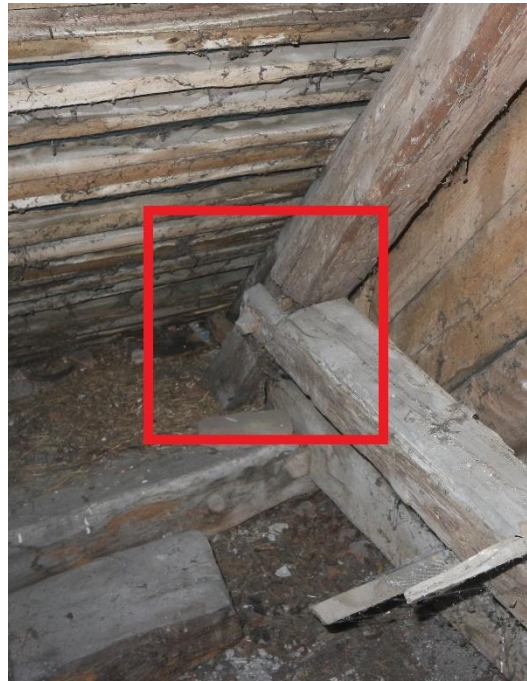
Fot. 57-58 Przykłady luzów połączenia jętek z krokwiami. Całkowite odspojenie elementów. Przy opukiwaniu młotkiem połączenia wszystkich jętek luźne
