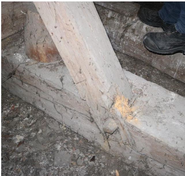
Fot. 53-54 Przykład uszkodzeń połączeń mieczy poprzecznych wiazarów w strefie belki stropowej oraz storczyka. Korozja biologiczna w zależności od wiażara od 20-80%
