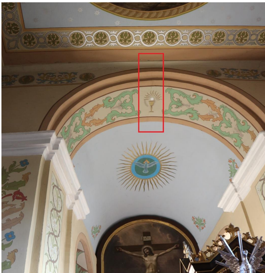
Fot. 27 Sklepienia kolebkowe przestrzeni otwartej nad ołtarzem. Polichromie z motywami ozdobnymi z szablonu. Zarysowanie łuku arkadowego/tęczowego
