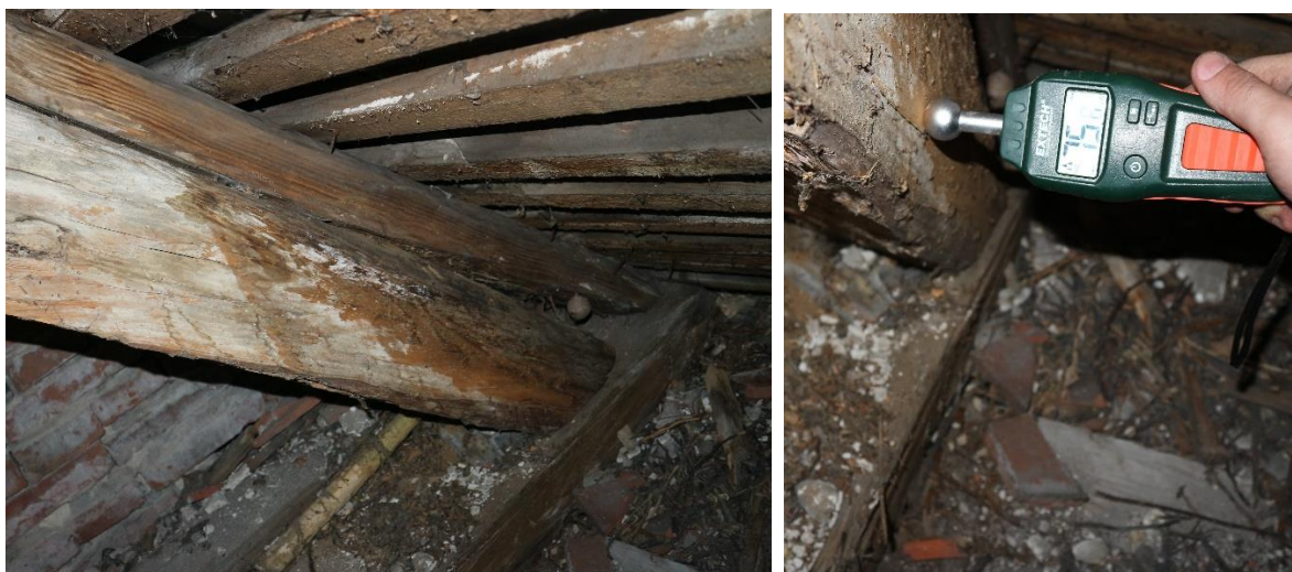
Fot. 45-46 Przypustnice w strefie okapowej silnie zawilgocone, zbutwiałe, zawilgocenie przypustnic 60-100%, korozja biologiczna przypustnic ok. 80%, lokalna korozja biologiczna połączeń krokwi z belką stropową, ok. 40-50%
