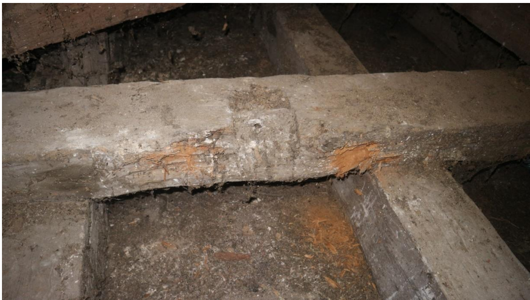
Fot. 50 Korozja biologiczna podwalin pod oparcie podkonstrukcji sygnaturki ok. 40-50%, podwaliny zastosowano jako wtórne, widoczne miejsce po gnieździe na inny element
