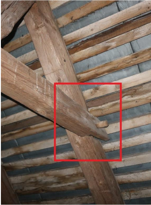
Fot. 57-58 Przykłady luzów połączenia jętek z krokwiami. Całkowite odspojenie elementów. Przy opukiwaniu młotkiem połączenia wszystkich jętek luźne
