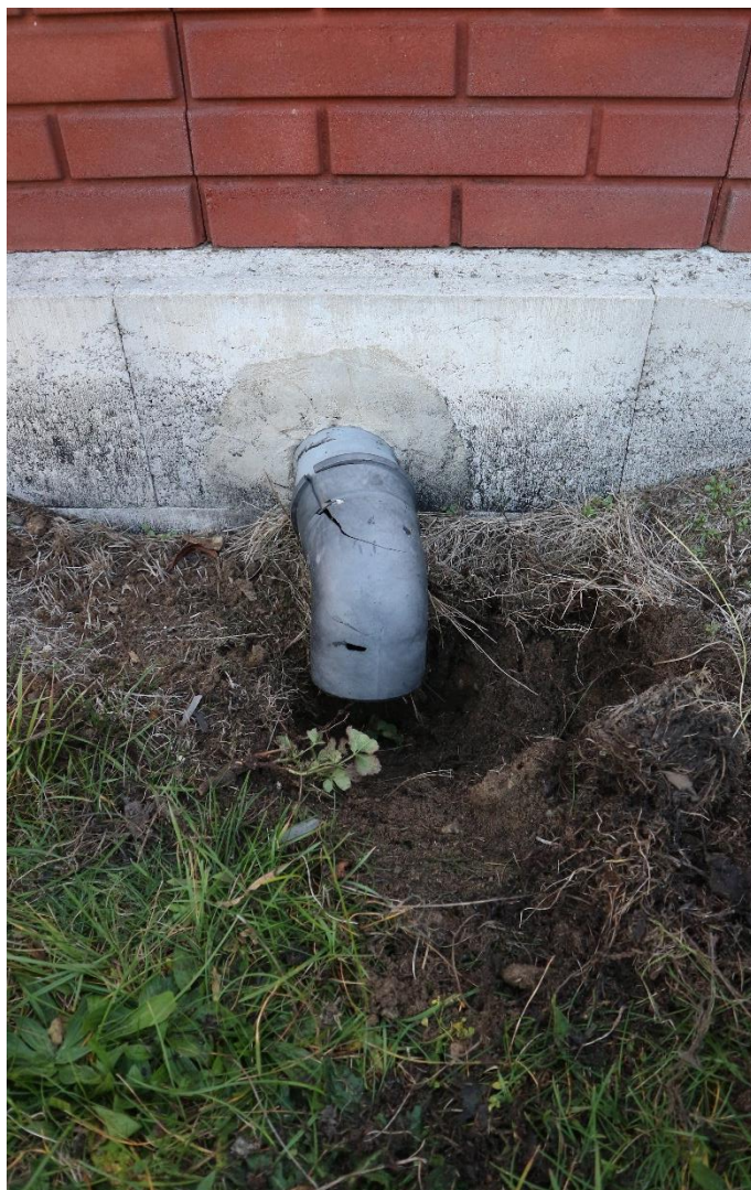
Fot. 70 Sposób oprowadzenia wód opadowych poza mury placu przykościelnego
