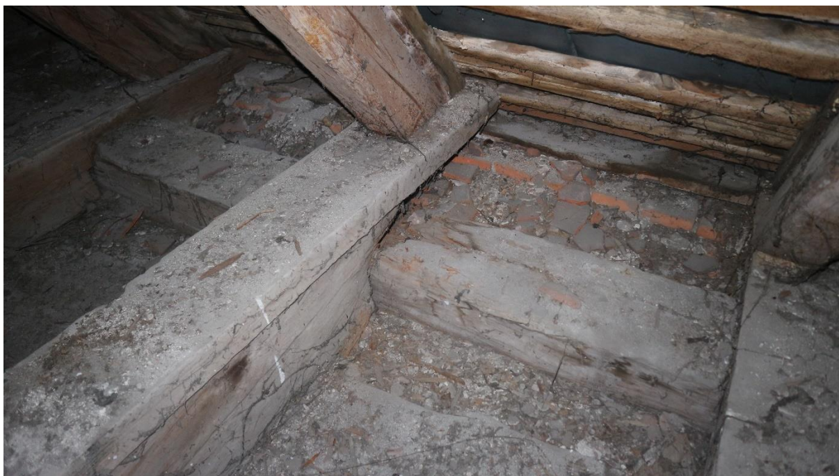
Fot. 48 Degradacja belki stropowej w strefie okapowej ok. 90-100%. Zastosowana podkłada pod oparcie krokwi. Zbutwiała murłata na styku z belką stropową, Korozja biologiczna murłaty ok. 50-60%
