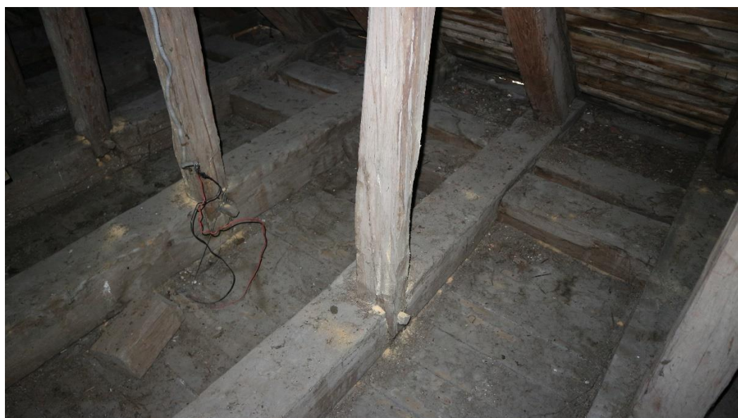
Fot. 41 Aktywne miejsca żerowania szkodników – obecność świeżej mączki drzewnej w pobliżu otworów wylotowych
