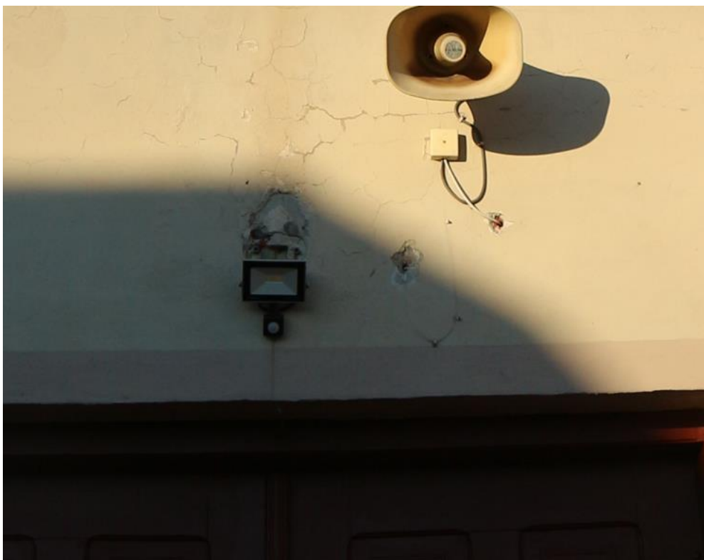
Fot. 23 Kieszenie/bruzdy po starych oprawach oświetleniowych
