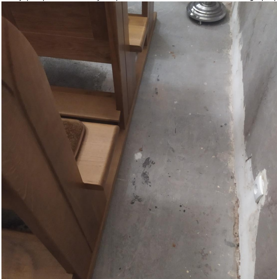
Fot.4 Uzupełnienia wtórne betonem lub wylewką betonową./cementową obwodowo w nawie kościoła
