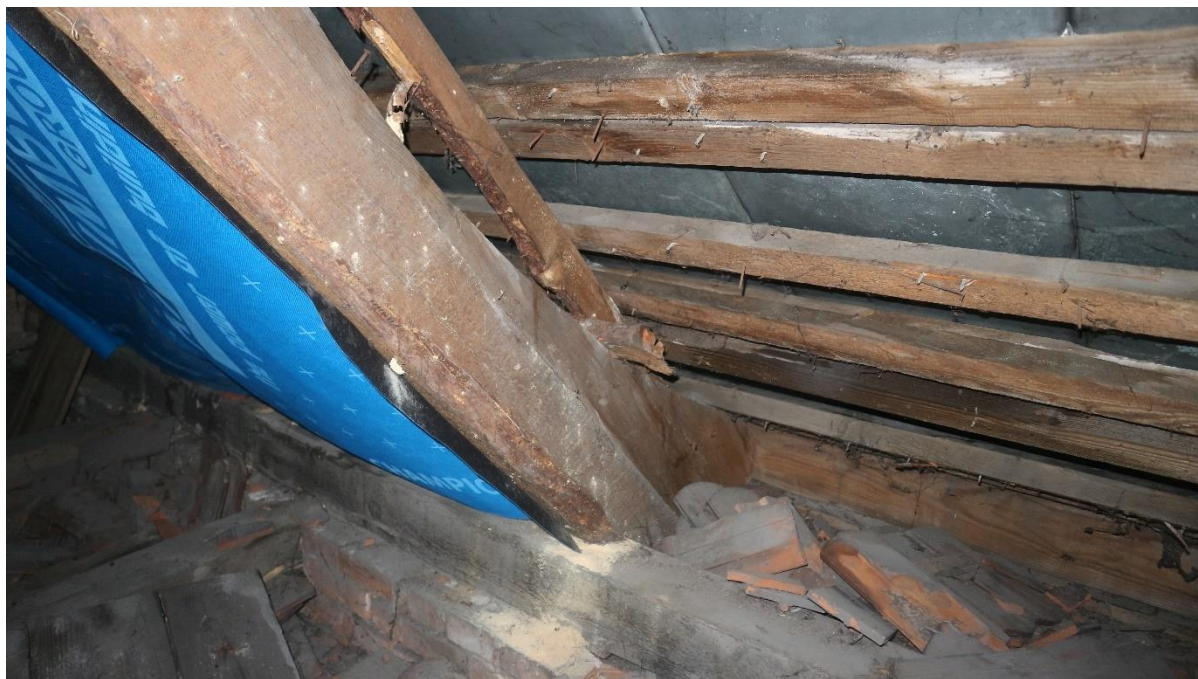
Fot. 64 Wyrównanie potaci północnej w dolnej części za pomocą tań. Widoczne aktywne miejsca żerowania o czym świadczy obecność świeżej mączki drzewnej w pobliżu otworów wylotowych.
