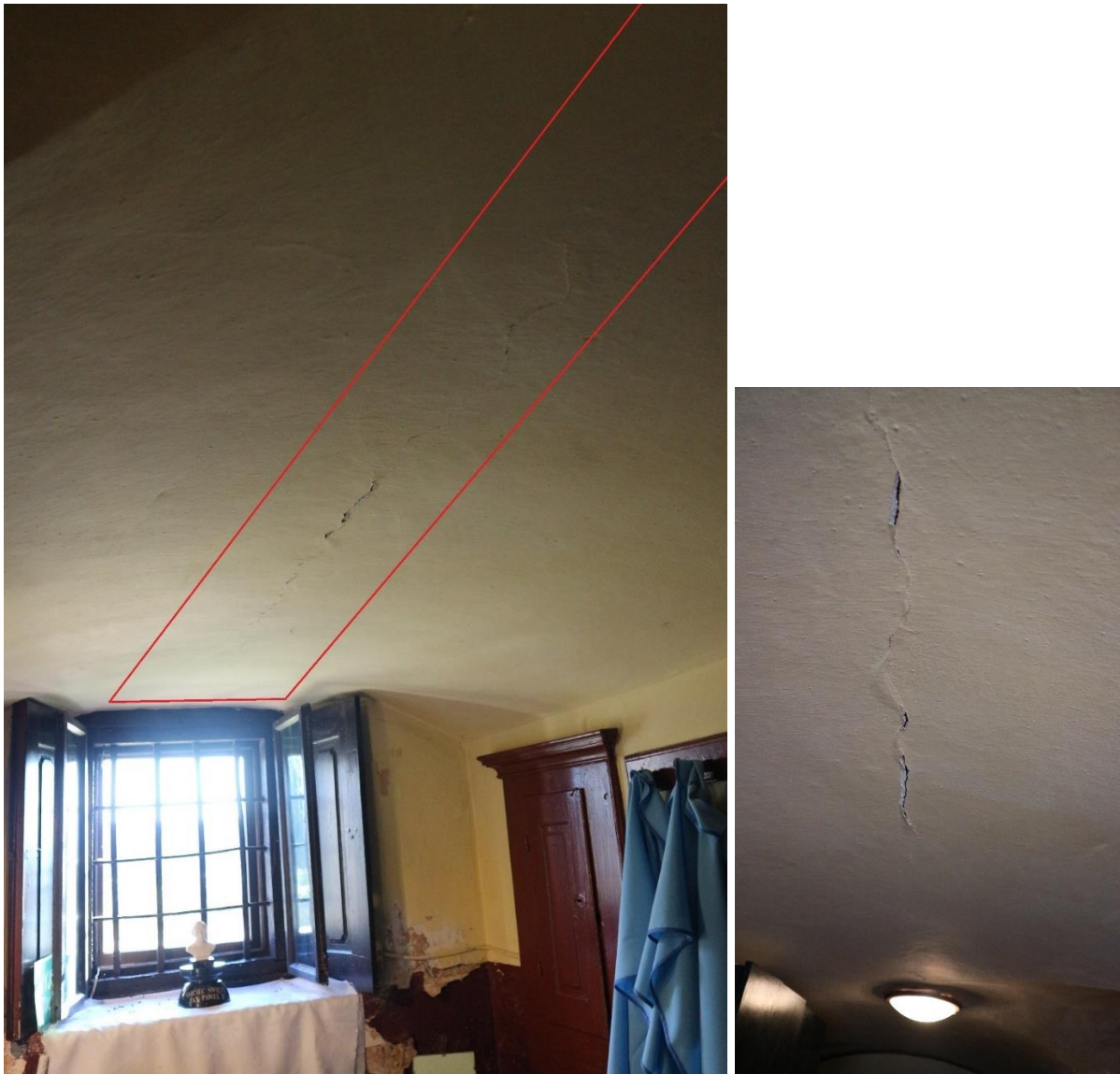
Fot.3 Zarysowanie sklepienia nad zakrystią, na osi północ-południe w miejscu pęknięcia strefy cokołowej elewacji południowej
