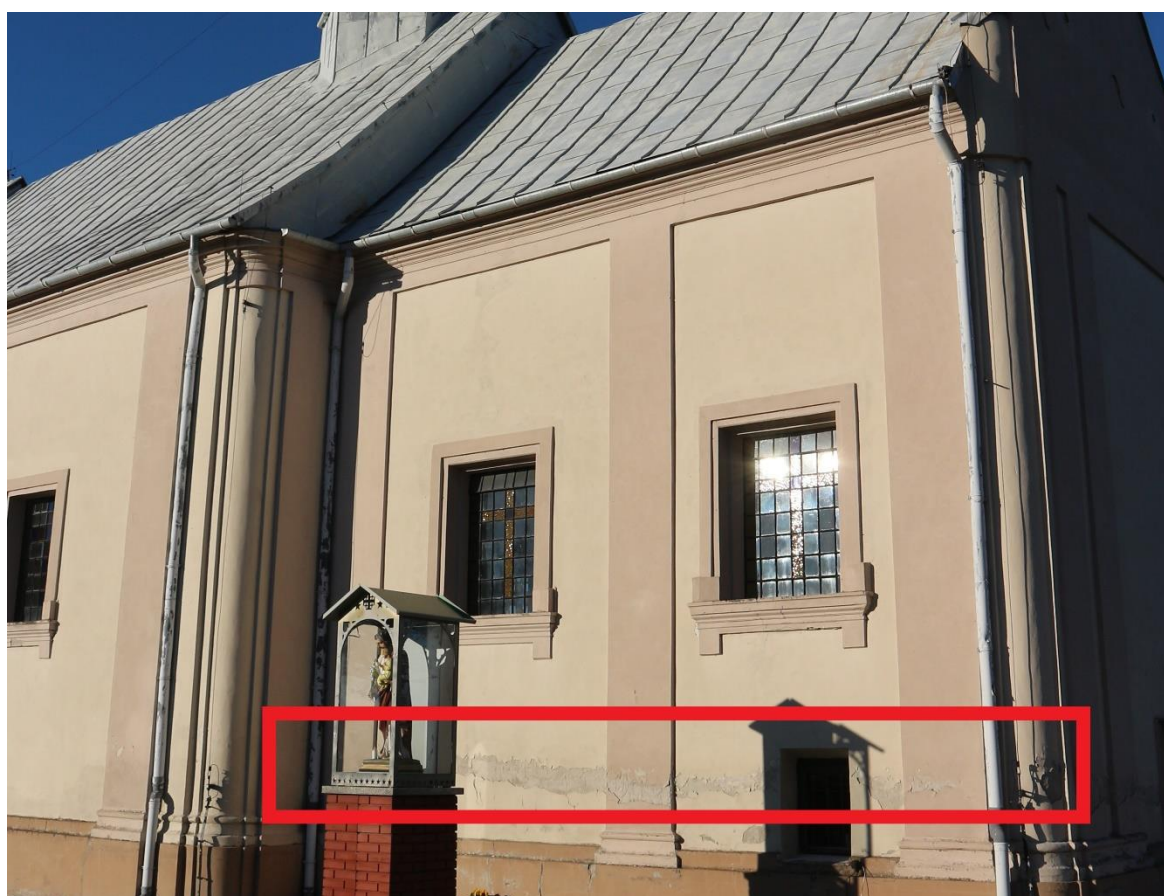
Fot.8 Strefa podciągania kapilarnego wody gruntowej od strony południowej — ok. 2m od poziomu terenu
