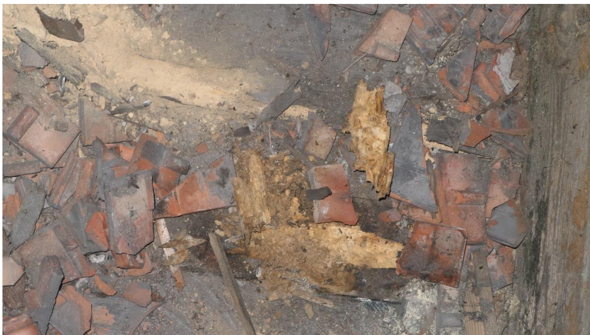
Fot. 34 Uszkodzone deski od strony strychu w miejscu przecieku, pozostałości po dachówce, Deski zbutwiały, zawilgocenie 100%, korozja biologiczna desek ok 80%
