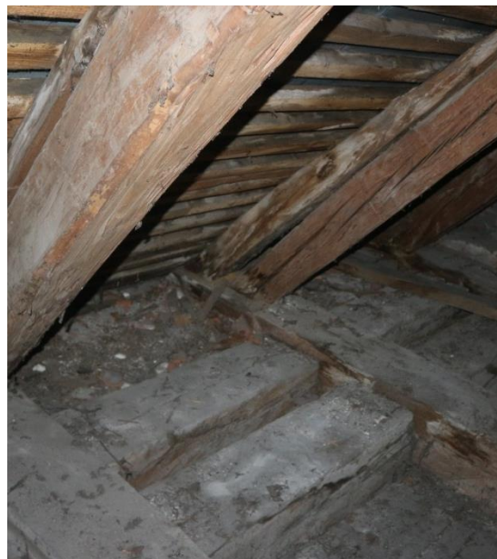
Fot. 43-44 Przypustnice w strefie okapowej silnie zawilgocone, zbutwiałe, zawilgocenie przypustnic 60-100%, korozja biologiczna przypustnic ok 80%
