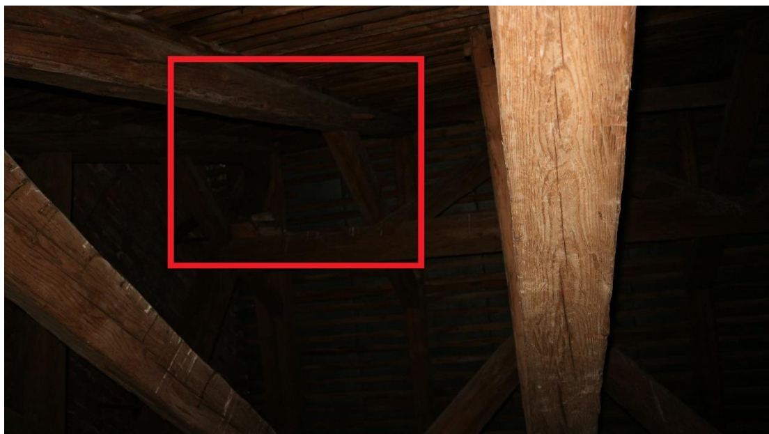
Fot. 60 Brak zastrzału w górnym poziomie jętek przy ścianie szczytowej zachodniej
