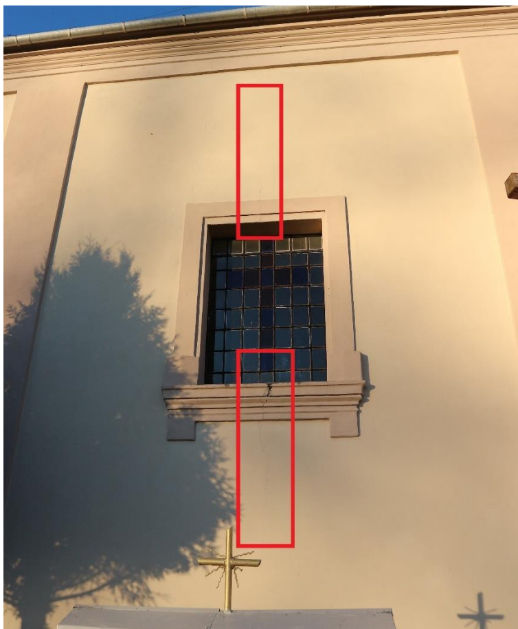
Fot.11 Zarysowanie obustronne muru w strefie nadproży okiennych – elewacja południowa (zdjęcie od zewnątrz)
