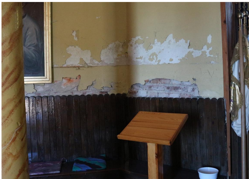
Fot. 18 Mury bez tynku w strefie cokółowej kruchty, który prawdopodobnie odpadł, obecnie ostonięty zapleckami siedzisk zlokalizowanych wokół ścian, liczne złuszczenia farby w kruchcie
