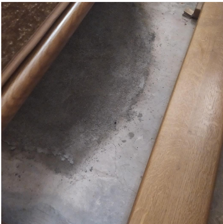
Fot.5 Uzupetnienia posadzki zaprawą cementową w przestrzeni pomiędzy ławkami
