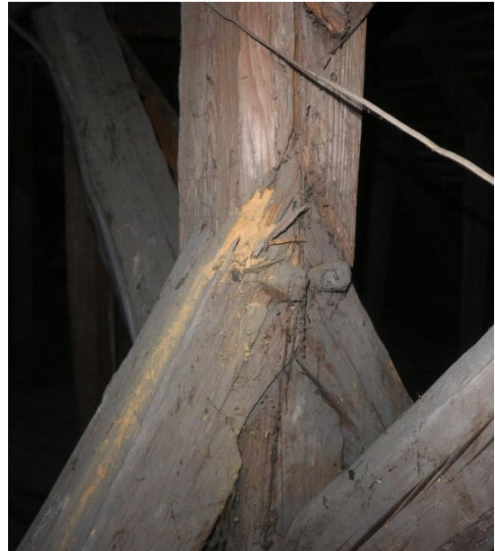
Fot. 53-54 Przykład uszkodzeń połączeń mieczy poprzecznych wiazarów w strefie belki stropowej oraz storczyka. Korozja biologiczna w zależności od wiażara od 20-80%
