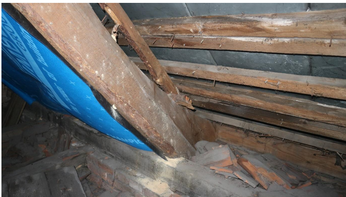
Fot. 68 Mocowanie blachy na zwoje dachowe (rąbek okragły) nad kruchtą na gwoździowanie. Liczne ogwoździowanie łąt niezwiązane z pokryciem(najprawdopodobniej wtórne) . Tymczasowe zabezpieczenia membraną przecieków. Nieprawidłowo zamontowana membrana.
