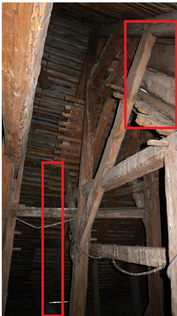
Fot. 61 Na styku prezbiterium i nawy uskok dachu uformowany w postaci ściany z desek. Brak stópki wiązara na uskoku dachów
