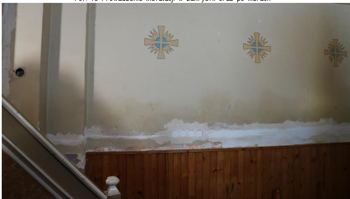
Fot. 74 Wykonanie puszek oraz szpachlowania pod gniazdka
