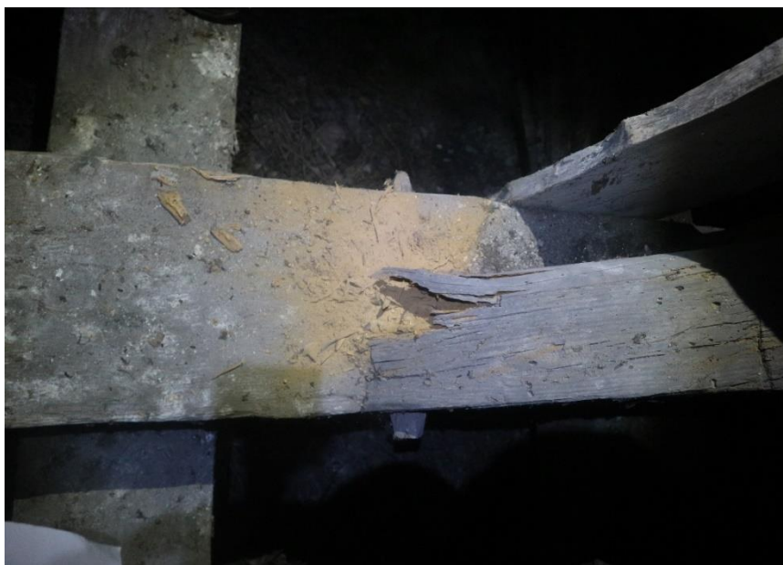
Fot. 55 Przykład uszkodzeń połączeń mieczy w strefie belki stropowej. Korozja biologiczna w zależności od wiażara od 20-80%
