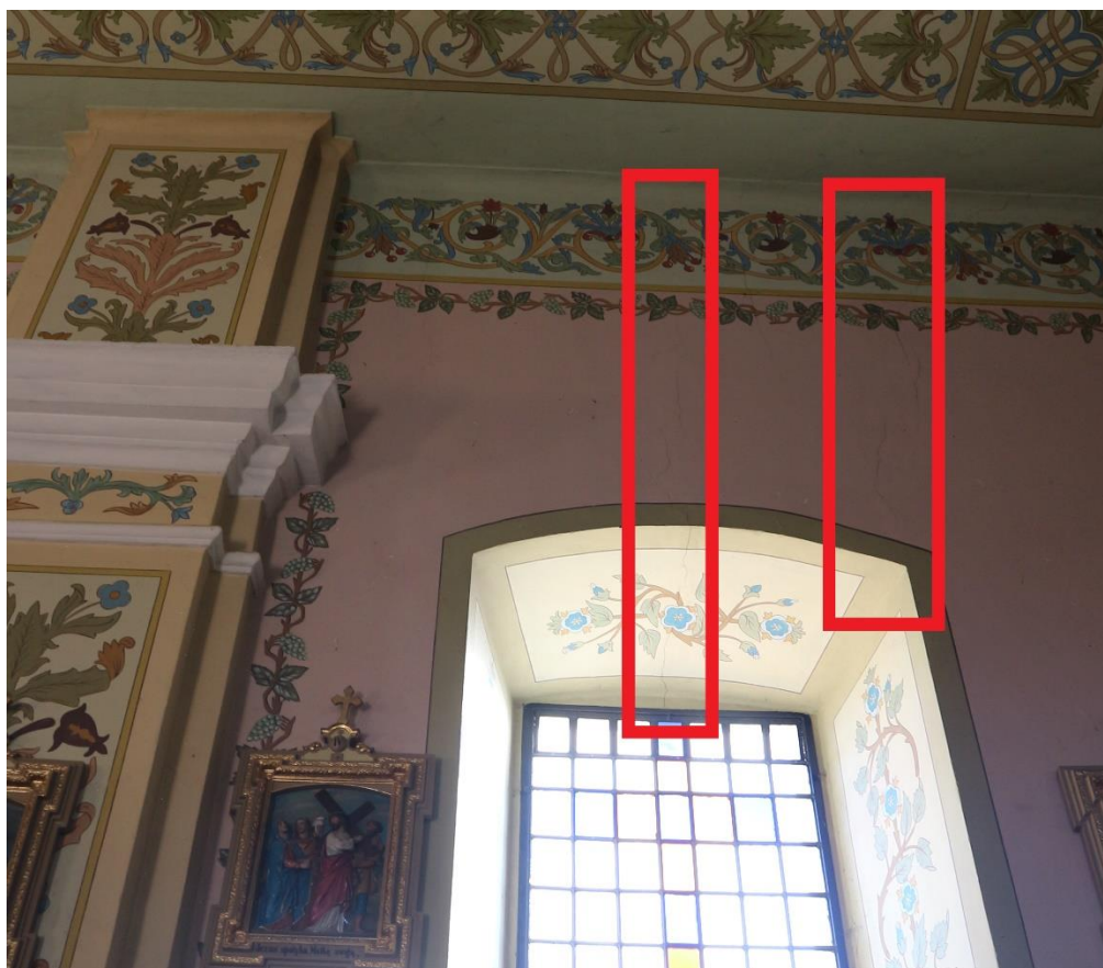
Fot.10 Zarysowanie obustronne muru w strefie nadproży okiennych – elewacja południowa (zdjęcie od wewnątrz)
