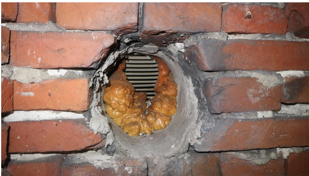
Fot. 62 Przykład montażu kratki wentylacyjnej w ścianie szczytowej na piankę montażową ograniczającą światło otworu
