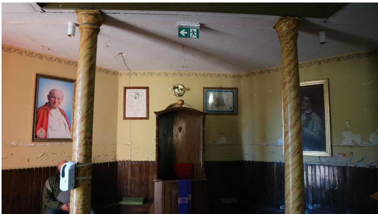
Fot. 28 Chór muzyczny na słupach stalowych (żeliwnych), łuszcząca się farba na suficie chóru oraz ścianach.
