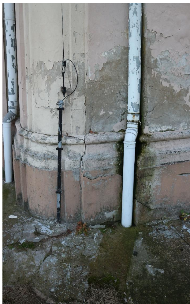
Fot. 22 Porost glonów oraz silne zawilgocenie muru narożnika nawy od strony północnej w wyniku nieszczelności/niedrożności rur spustowych
