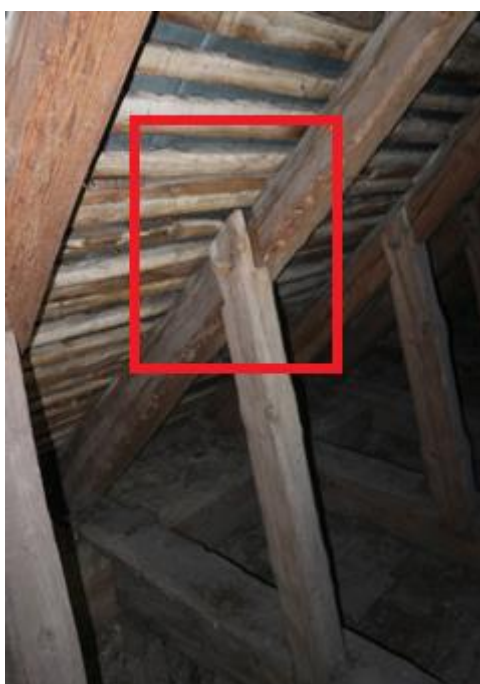
Fot. 56 Przykład luzów połączenia miecza (stolca) stropowego na styku z krokwią. Przy opukiwaniu młotkiem połączenia wszystkich mieczy luźne
