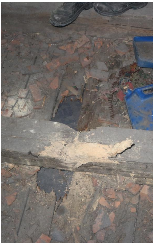
Fot. 33 Uszkodzone deski od strony strychu, zabezpieczone od spodu membrana, Deski zbutwiałe, tzw. próchno, powstałe w wyniku ok. 100% rozkładu drewna
