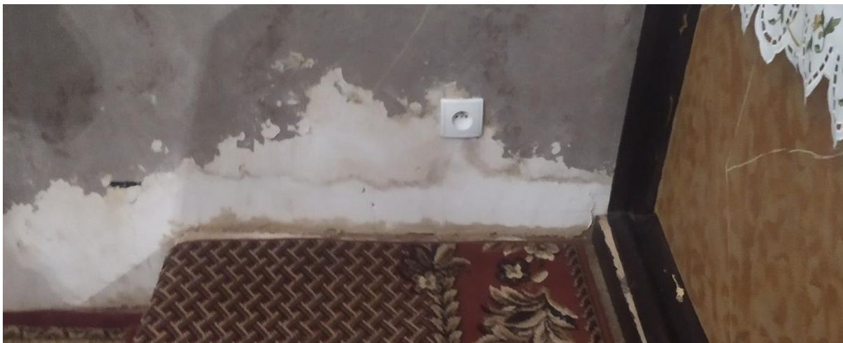
Fot. 19 Widoczne zawilgocenie zaszpachlowanych bruzd pod instalację elektryczną wykonaną w 2021r.
