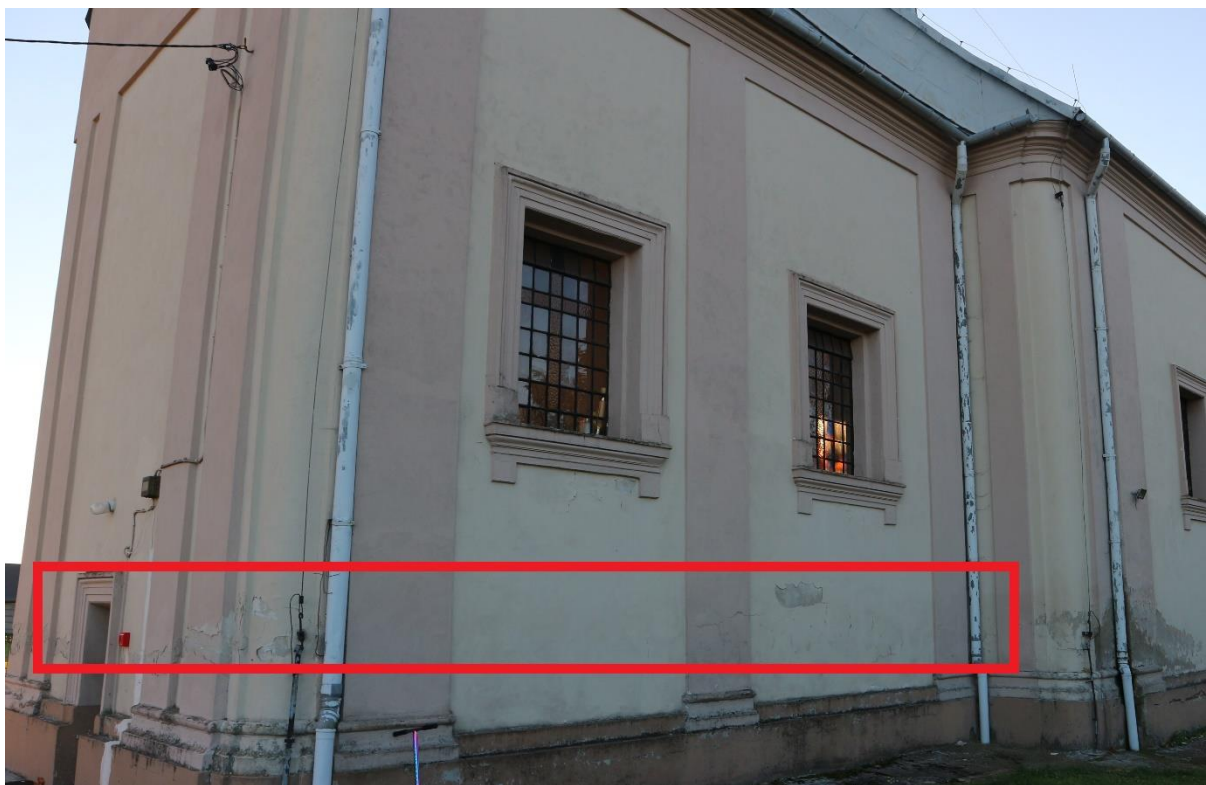
Fot.9 Strefa podciągania kapilarnego wody gruntowej od strony północnej – ok. 2m od poziomu terenu
