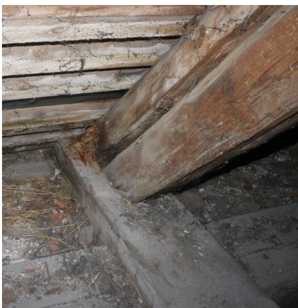
Fot. 43-44 Przypustnice w strefie okapowej silnie zawilgocone, zbutwiałe, zawilgocenie przypustnic 60-100%, korozja biologiczna przypustnic ok 80%
