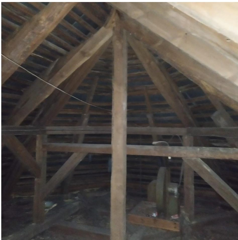
Fot. 63 Wieżba dachowa sferyczna nad kruchtą, płatwiowo-krokwiowa ukształtowana za pomocą krążyn. Stopień degradacji, korozji biologicznej elementów stropu i sufitu powyżej 80%.
