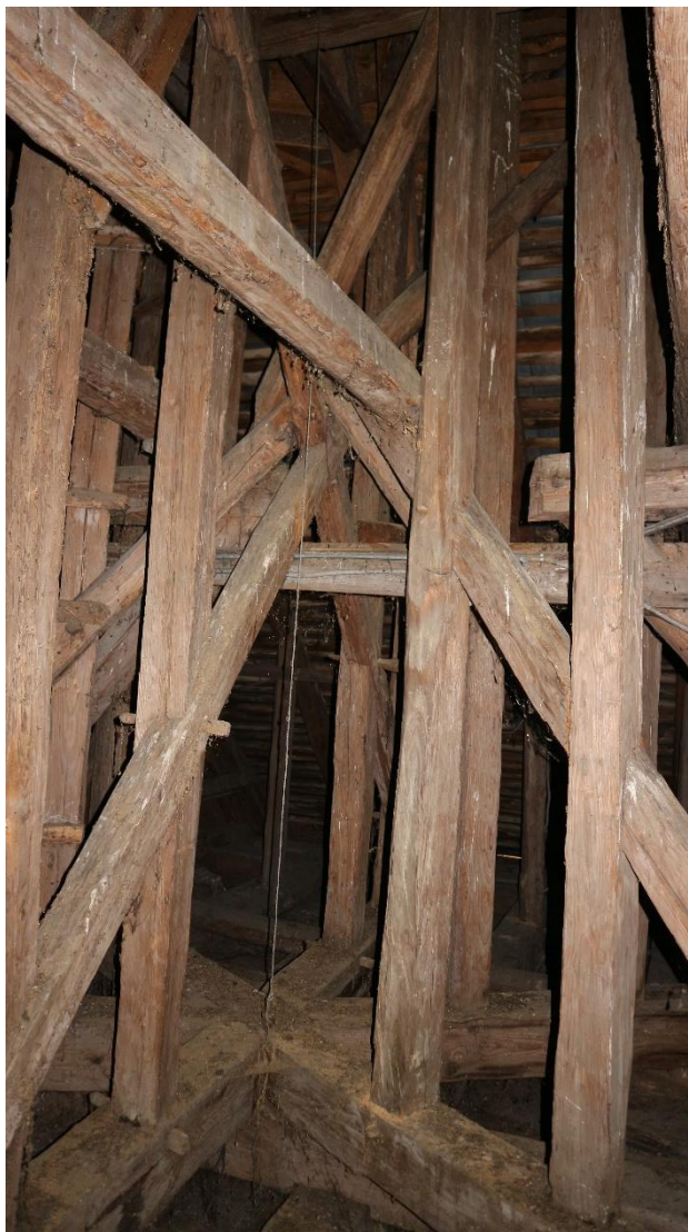
Fot. 38 Podkonstrukcja sygnaturki
