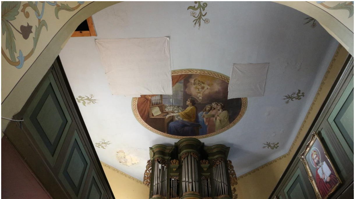
Fot. 32 Ostonięte miejsca uszkodzonych polichromii w kruchcie zachodniej (lokalny stopień uszkodzeń polichromii 100%)
