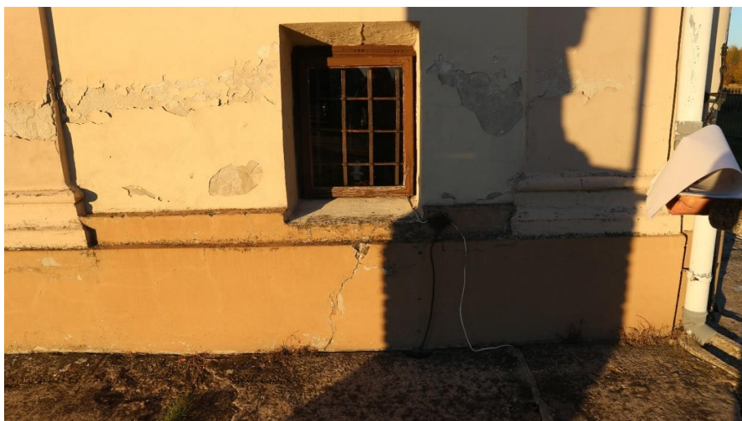
Fot. 71 Przykładowe spekania i uszkodzenia opaski betonowej wokół kościoła
