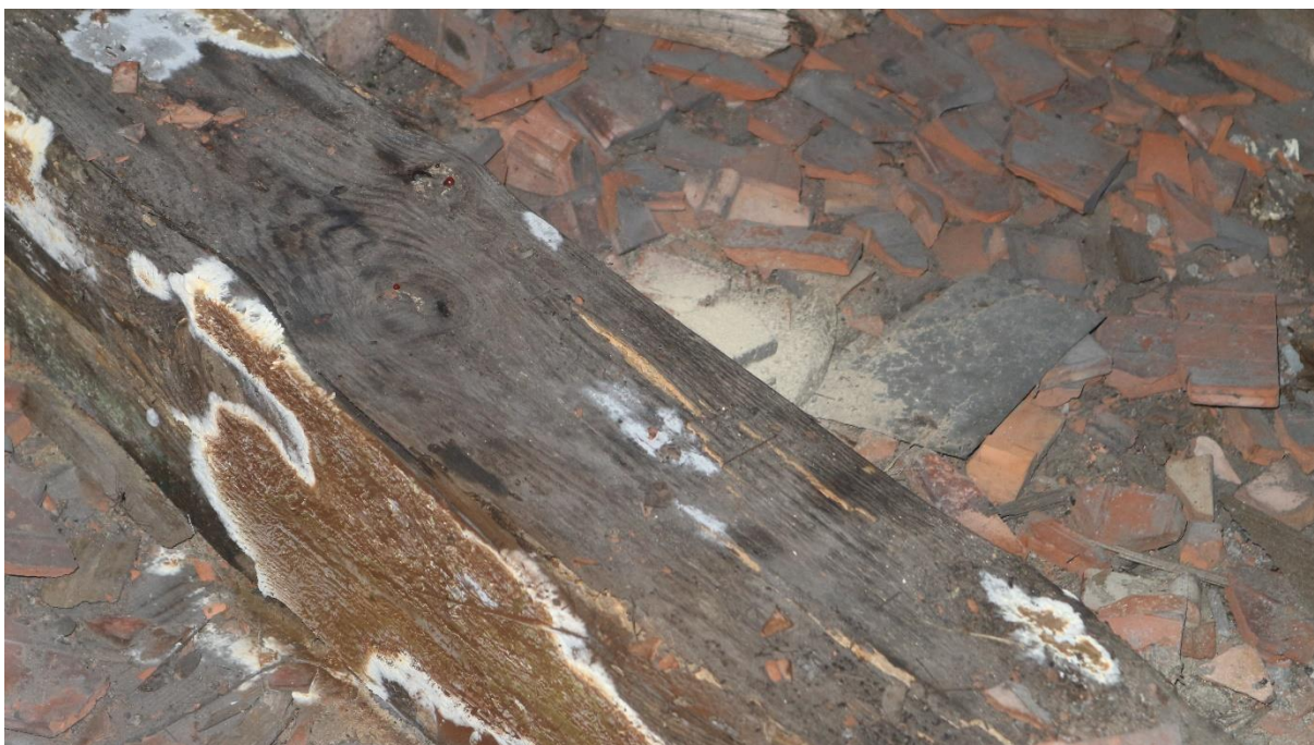
Fot. 66 Porażenie belek grzybem domowym. Stopień zawilgocenia powierzchni belki ok. 99%.
