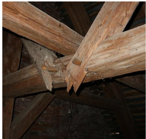
Fot. 59 Ucięte/wyłamane zastrzały w formie krzyża św. Andrzeja. Widoczne miejsca w storczyku po zastrzale. Widok z obu stron
