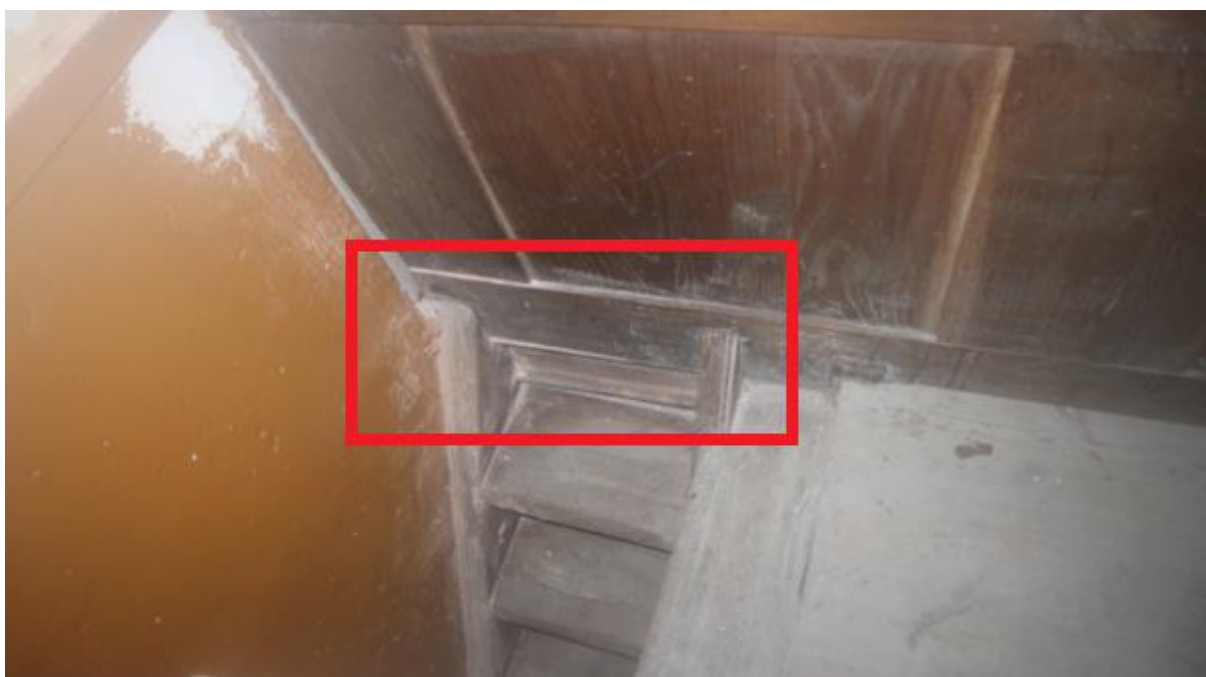
Fot. 29 Schody na chór, widoczna belka stalowa/żeliwana pod oparcie chóru i balustrady, porażenie technicznymi szkodnikami drewna
