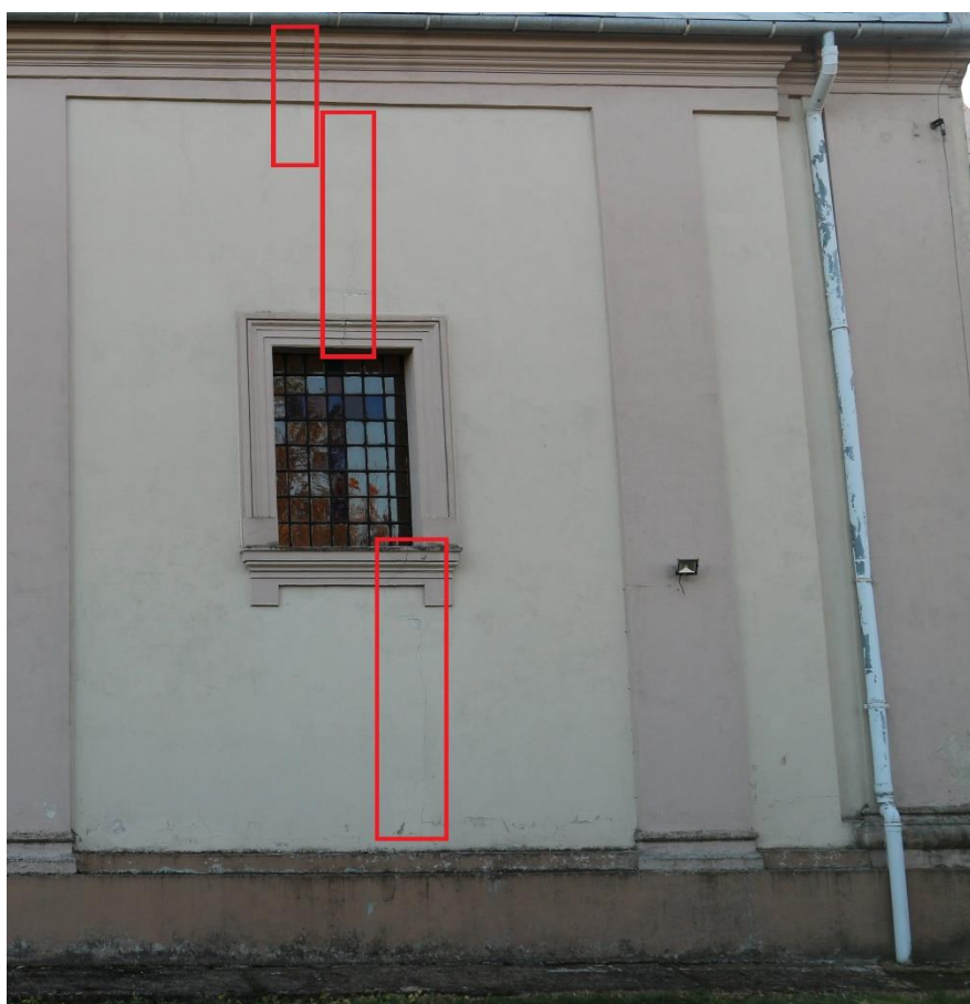
Fot.13 Zarysowanie obustronne muru w strefie nadproży okiennych — elewacja północna (zdjęcie od zewnątrz)
