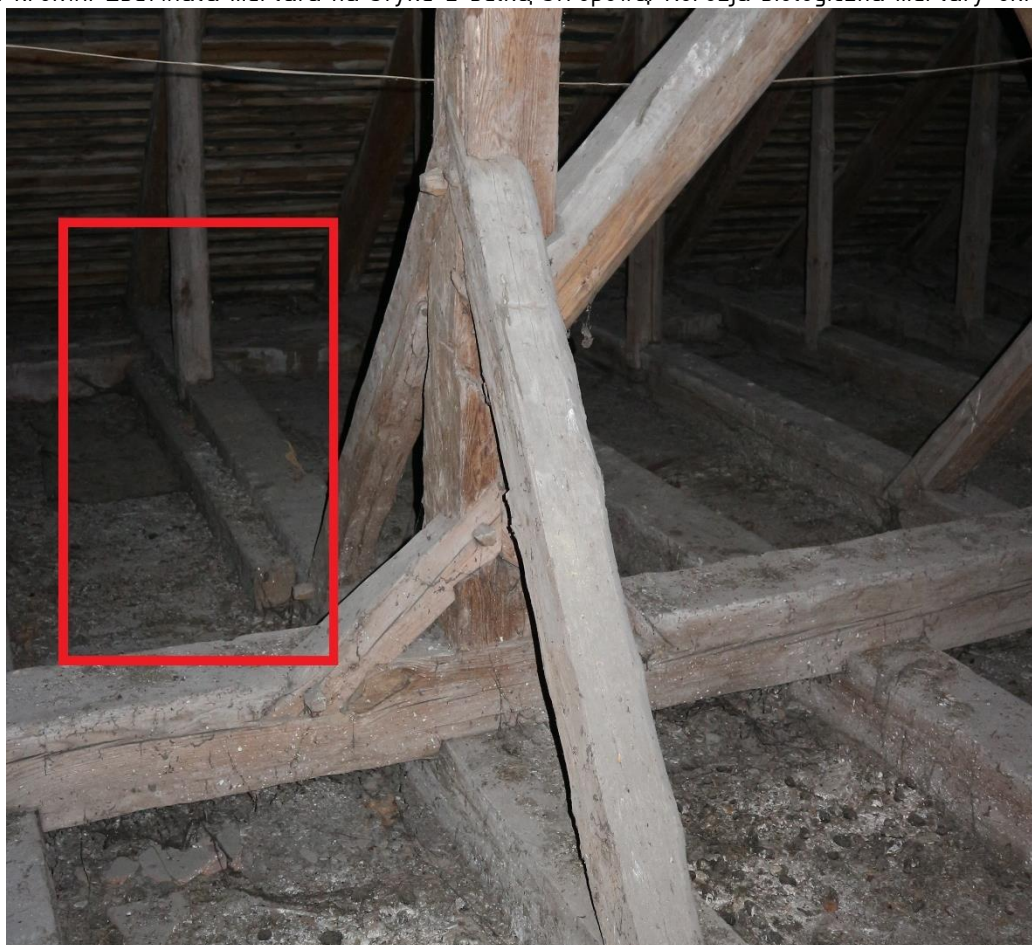
Fot. 49 Wzmocnienie belki stropowej poprzez poszerzenie jednostronne (nakładka)
