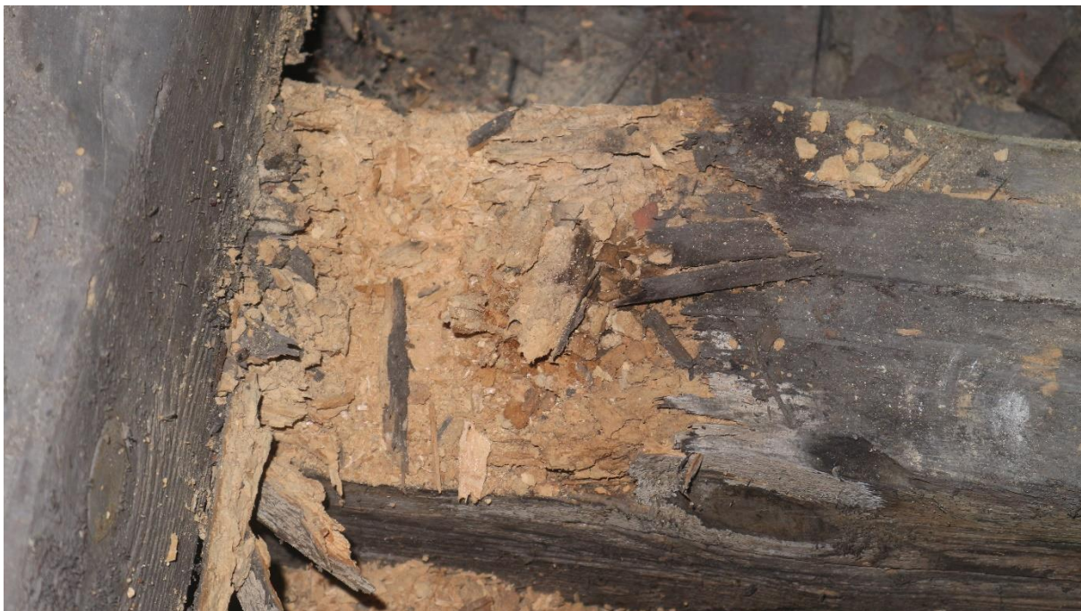
Fot. 65 Korozja biologiczna belek rusztu stropu wielkości powyżej 80%. Połączenia belek podłużnych i poprzecznych za pomocą śrub. Widoczne aktywne miejsca żerowania o czym świadczy obecność świeżej mączki drzewnej w pobliżu otworów wylotowych.
