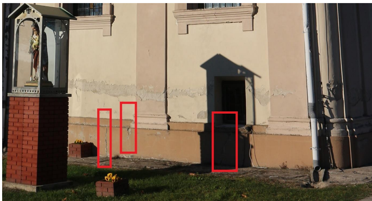
Fot.14 Pęknięcia muru przechodzące przez strefę cokotową w kierunku fundamentów — elewacja południowa
