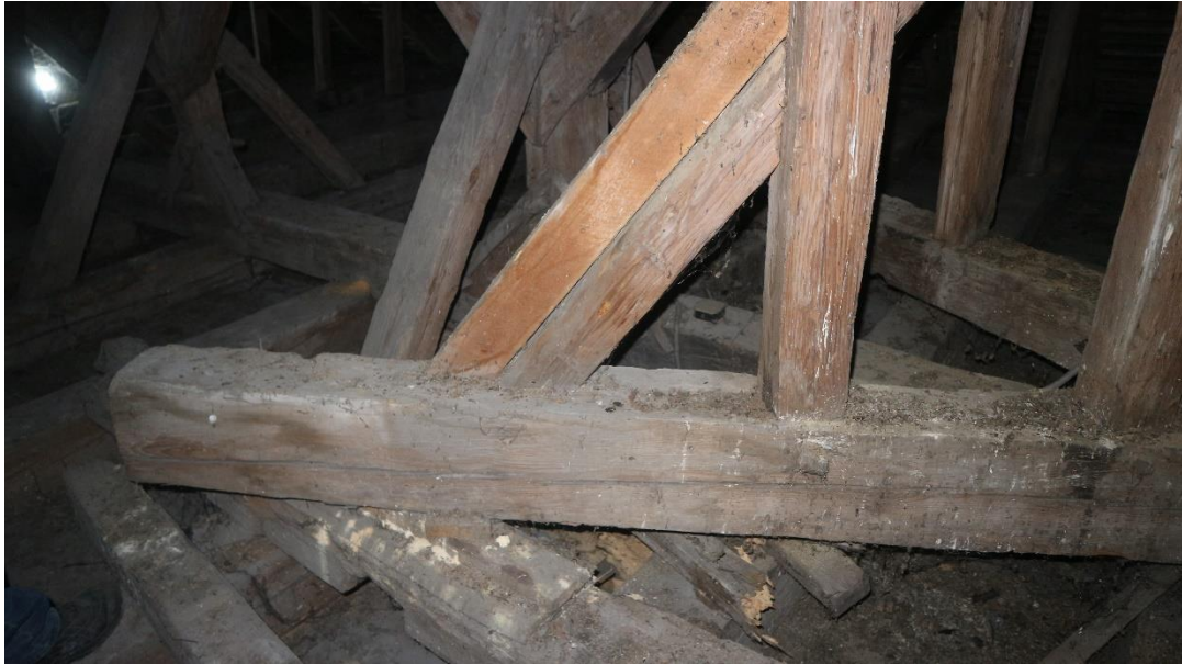
Fot. 52 Dodatkowe, wtórne (nowe) zastrzały podkonstrukcji sygnaturki, Wyrównywanie poziomów pod podkonstrukcję za pomocą licznych podkładek, Aktywne miejsca żerowania szkodników – obecność świeżej maczki drzewnej
