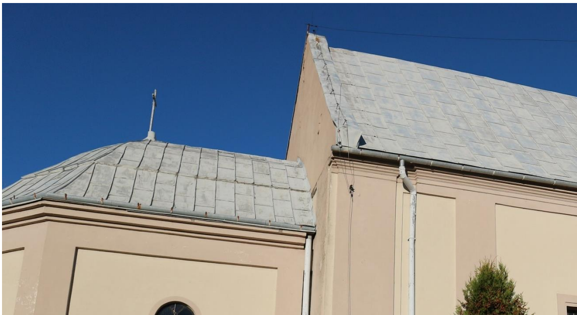
Fot. 67 Pokrycia obiektu – nad prezbiterium i nawą blacha na rąbek stojący, nad kruchtą zachodnią, blacha na zwoje dachowe (rąbek okragły)
