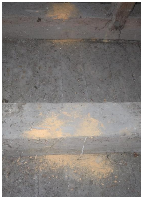
Fot. 39-40 Korozja biologiczna belek stropowych wynosi ok. 20-30%.
