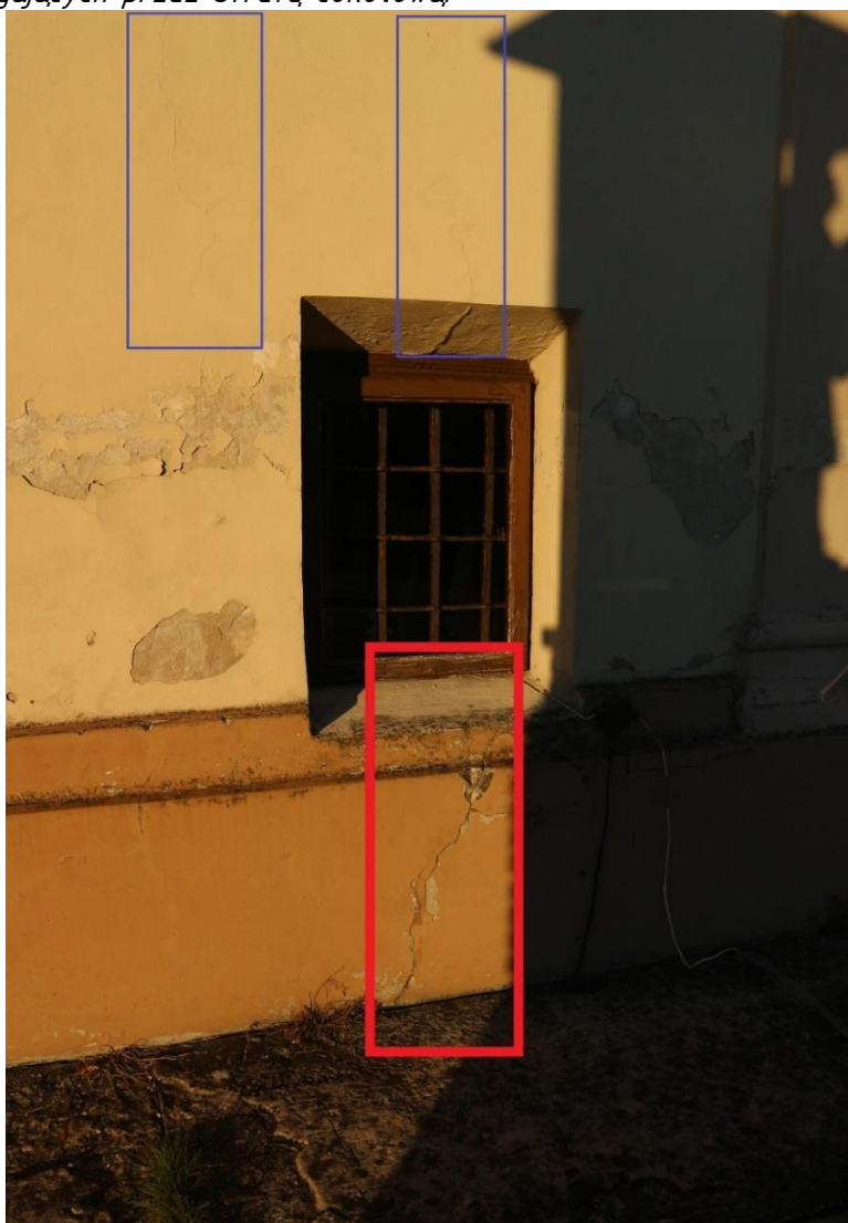
Fot.2 Pęknięcie strefy cokotowej (ramka koloru czerwonego) od okna w kierunku fundamentu, rysy w strefie między okiennej (ramki koloru niebieskiego)
