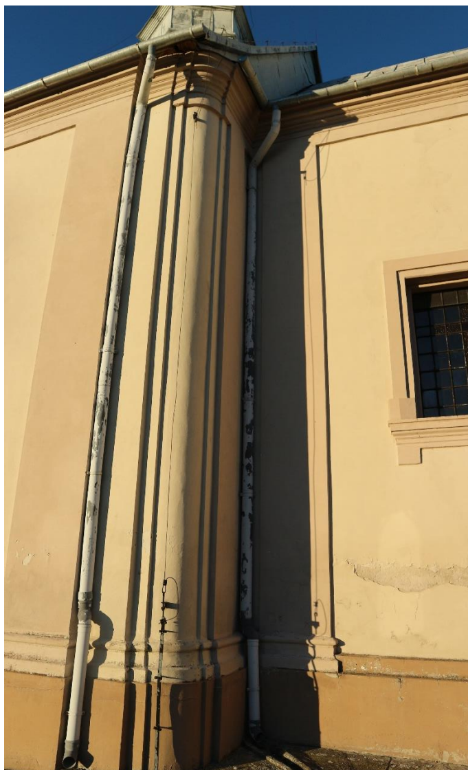
Fot. 68 Rynny i rury spustowe łączone na wysokości.
