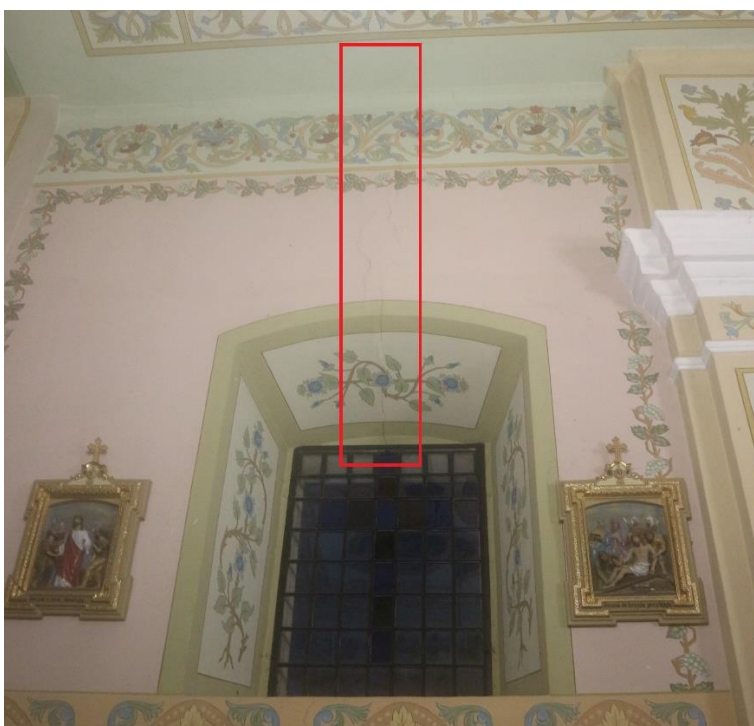
Fot.12 Zarysowanie obustronne muru w strefie nadproży okiennych – elewacja północna (zdjęcie od wewnątrz)
