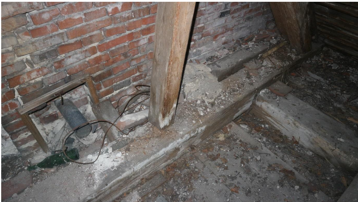
Fot. 42 Porażenie belek i mieczy stropowych przy ścianie szczytowej zachodniej grzybem domowym
