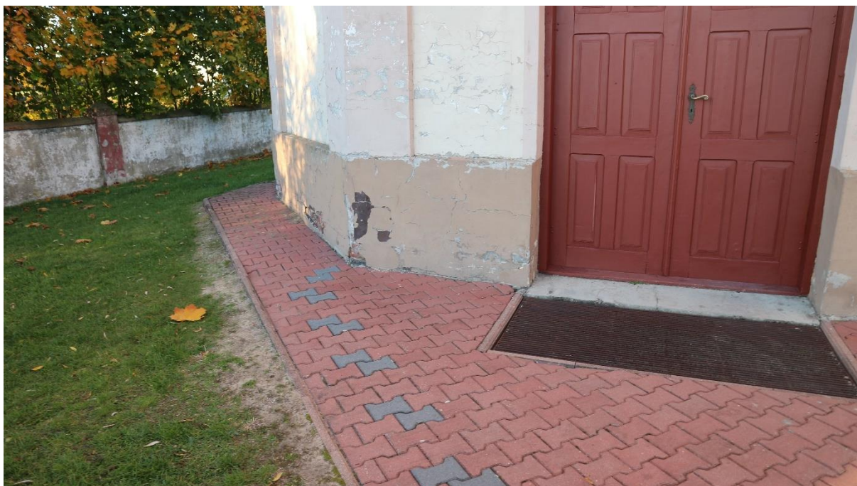
Fot.7 Zarysowania, odparzenia tynków, złuszczenie farby elewacyjnej, porost glonów w strefie cokołowej, uszkodzenia warstwy przypowierzchniowej cegły kruchty od strony zachodniej
