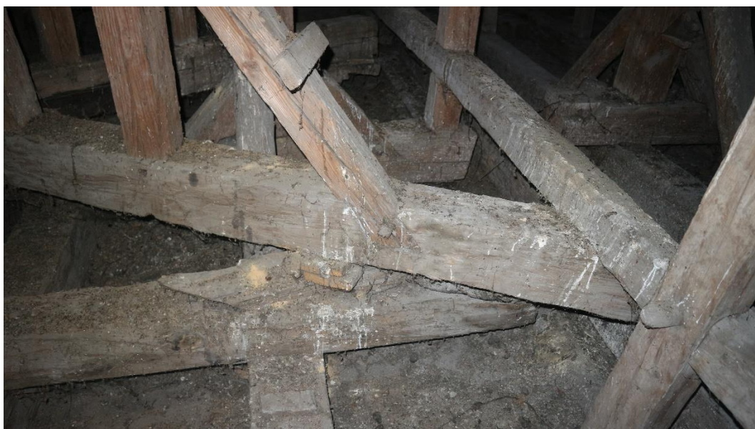
Fot. 51 Wyrównywanie poziomów pod podkonstrukcję sygnaturki za pomocą licznych podkładek, Aktywne miejsca żerowania szkodników – obecność świeżej mączki drzewnej
