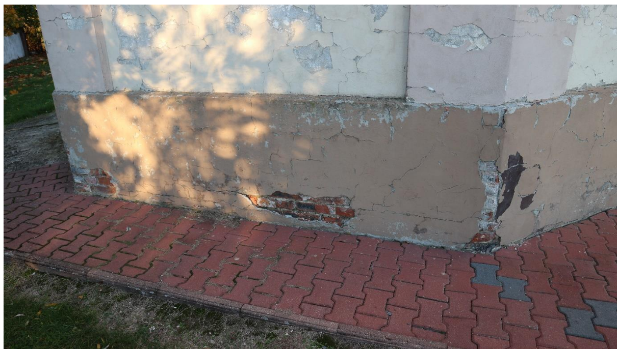
Fot.6 Zarysowania, odparzenia tynków, złuszczenie farby elewacyjnej, porost glonów w strefie cokołowej, uszkodzenia warstwy przypowierzchniowej cegły kruchty od strony zachodniej
