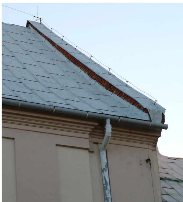
Fot. 20 Brak otynkowania ścian szczytowych ponad potacją dachu od strony pokrycia (po lewej ściana szczytowa wschodnia, po prawej ściana szczytowa zachodnia)
