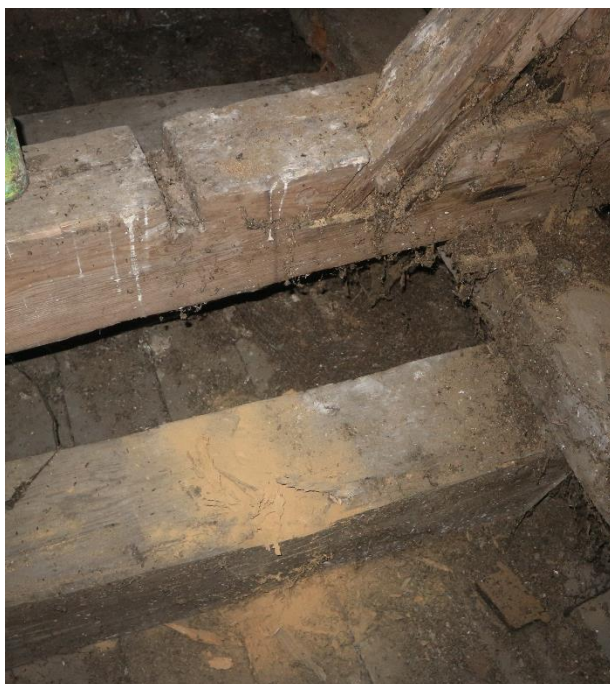
Fot. 39-40 Korozja biologiczna belek stropowych wynosi ok. 20-30%.
