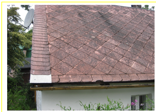
Fot. 2 Płyty azbestowo-cementowe płaskie
