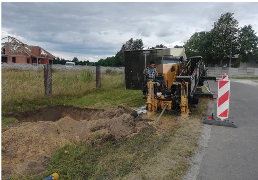
Wykonywanie wodociągu metodą „przewiertu sterowanego”
