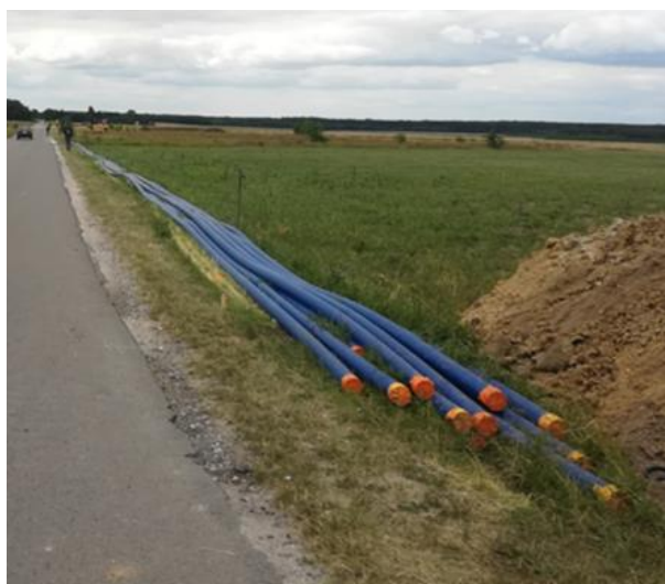
Wykonywanie wodociągu metodą „przewiertu sterowanego”
