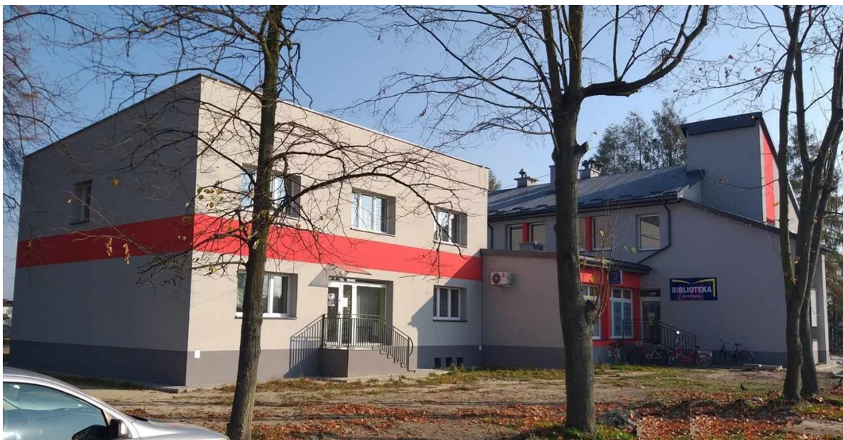
Budynek „starego” Ośrodka Zdrowia po termomodernizacji.
