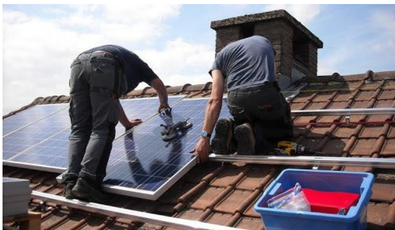
Montaż paneli fotowoltaicznych
