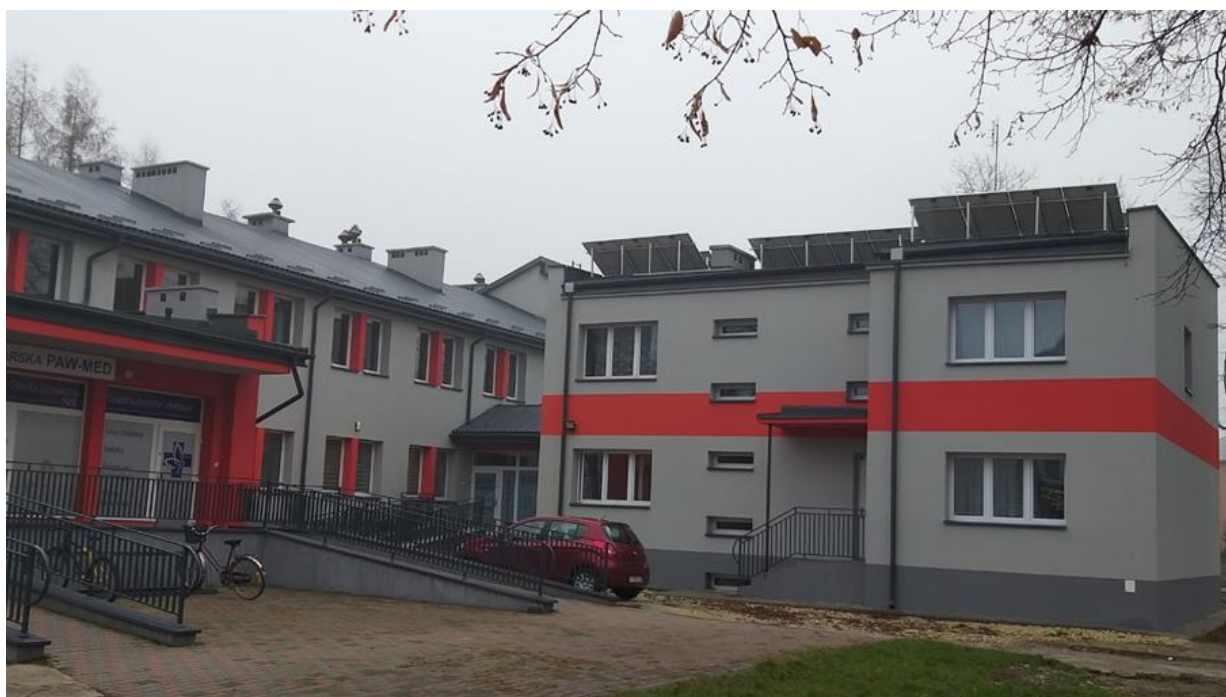
Budynek Ośrodka Zdrowia, Gminnej Biblioteki Publicznej i Gminnego Ośrodka Pomocy Społecznej po termomodernizacji
