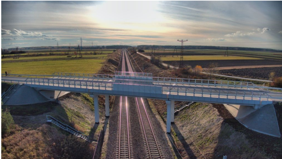
Wyremontowany wiadukt kolejowy w kierunku Bichniowa
