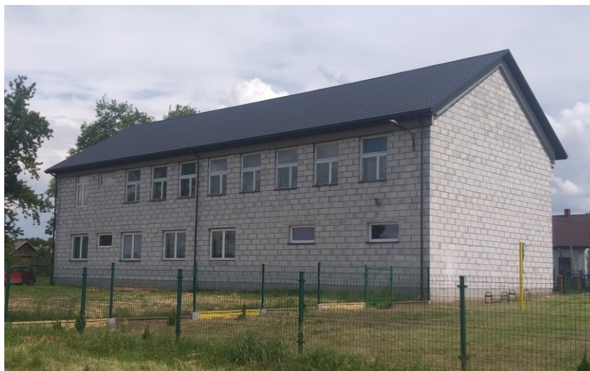
Nowy dach na budynku remizo-świetlicy w Bichniowie
