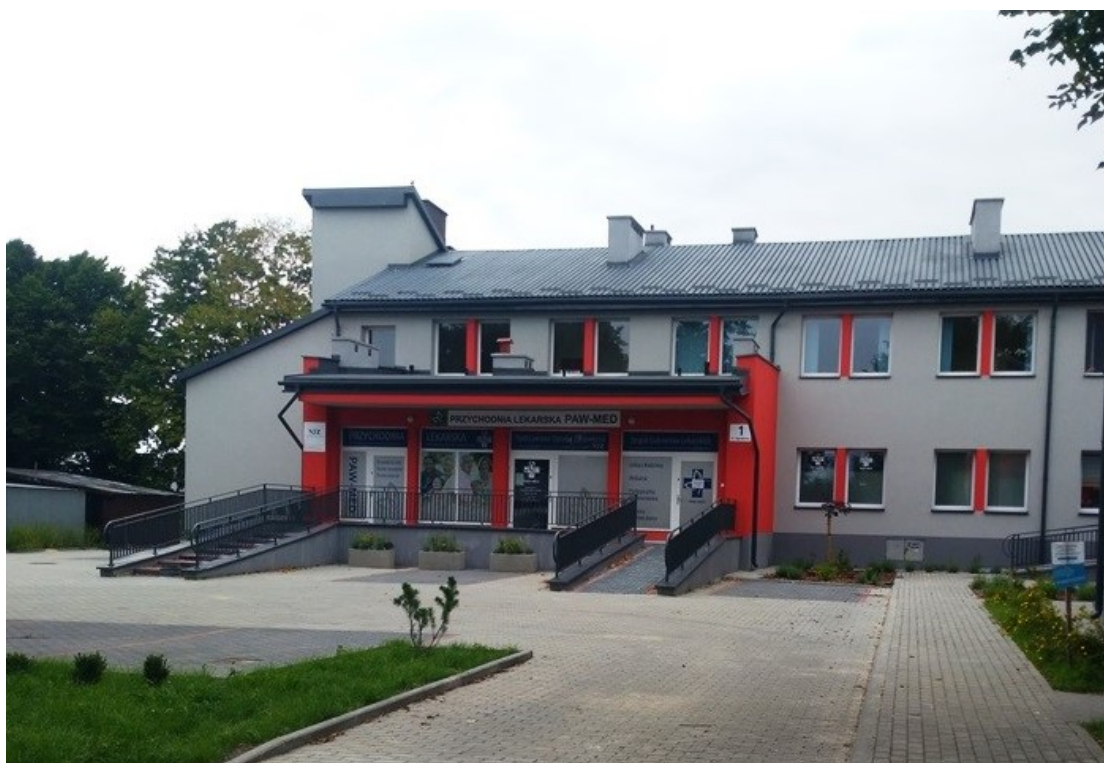
Budynek Przychodni Zdrowia w Seceminie
