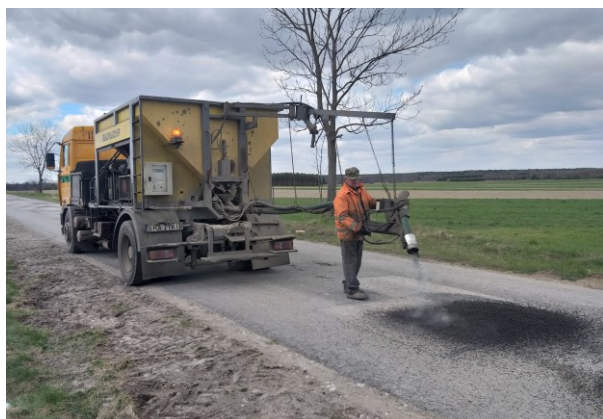
Naprawa remonterem drogi gminnej na odcinku Secemin - Kluczyce
