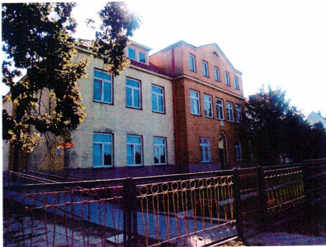
Fot. 2. Budynek Zespołu Szkół w Seceminie
