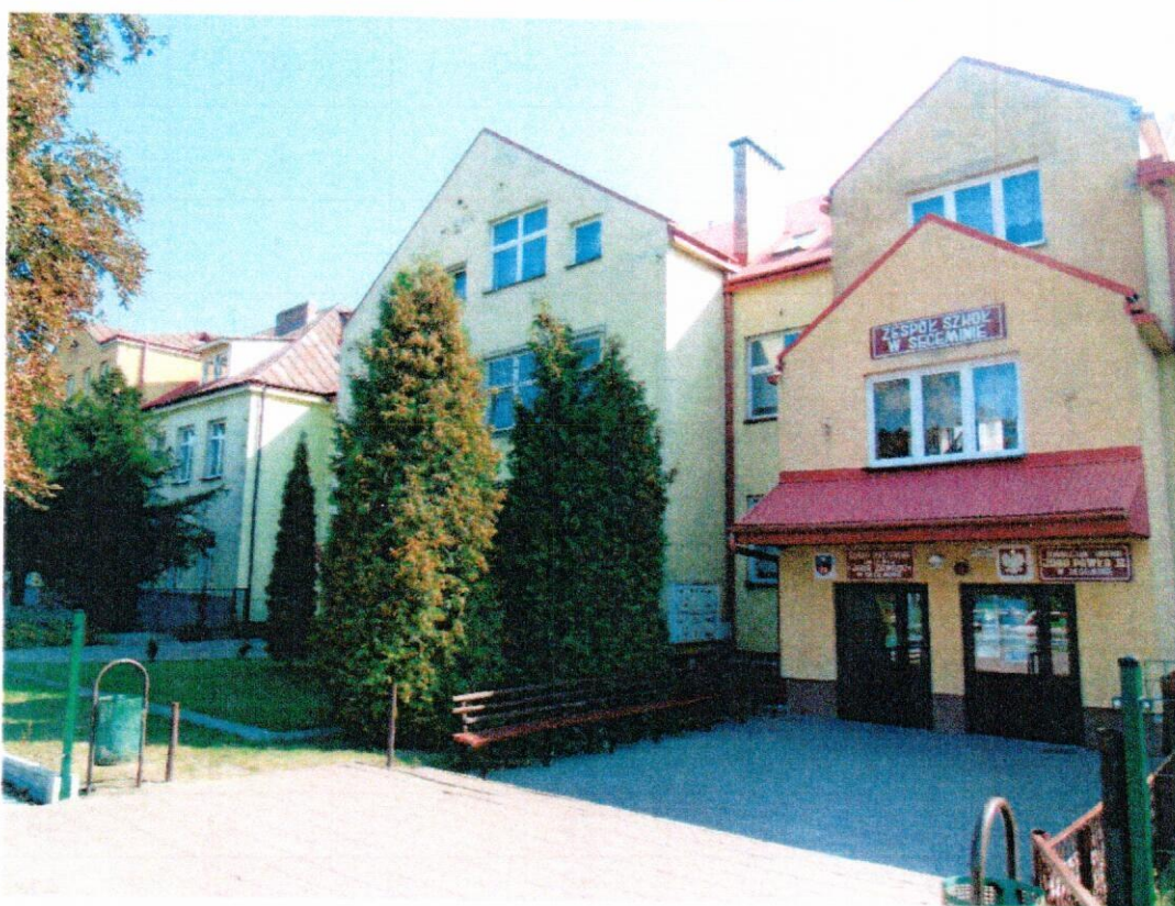
Fot. 1. Budynek Zespołu Szkół w Seceminie
