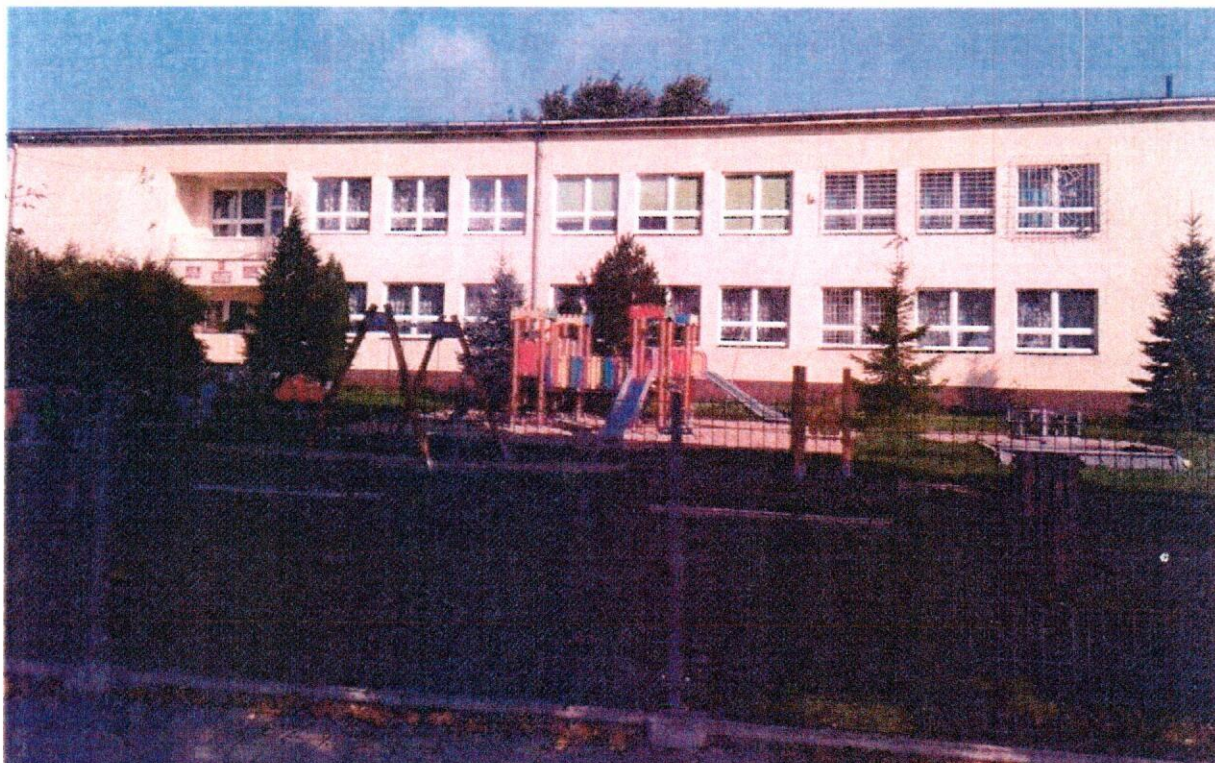
Fot. 3. Budynek Zespołu Szkolno-Przedszkolnego w Żeliszawicach
