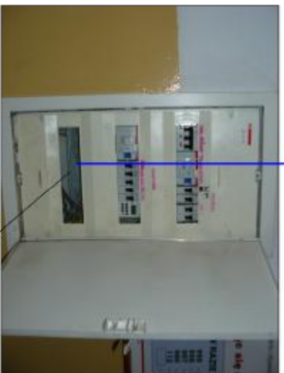
Montaż zabezpieczenia oświetlenia zewnątrznego, projektowanego -FR103-20A
