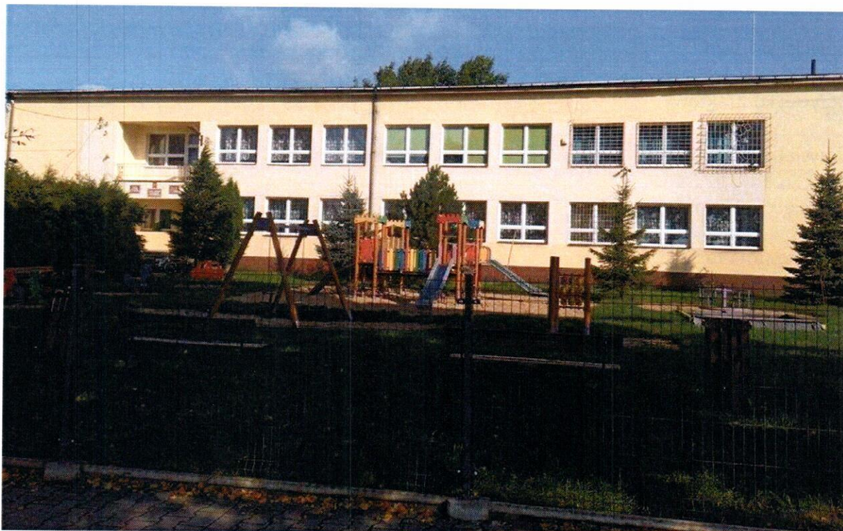
Fot. 3. Budynek Zespołu Szkolno-Przedszkolnego w Żeliszawicach
