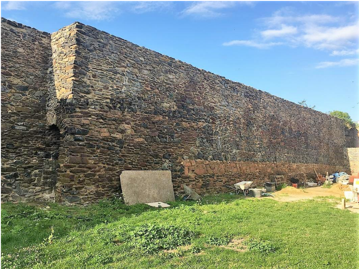
Fragment murów obronnych od strony Plebanii.
