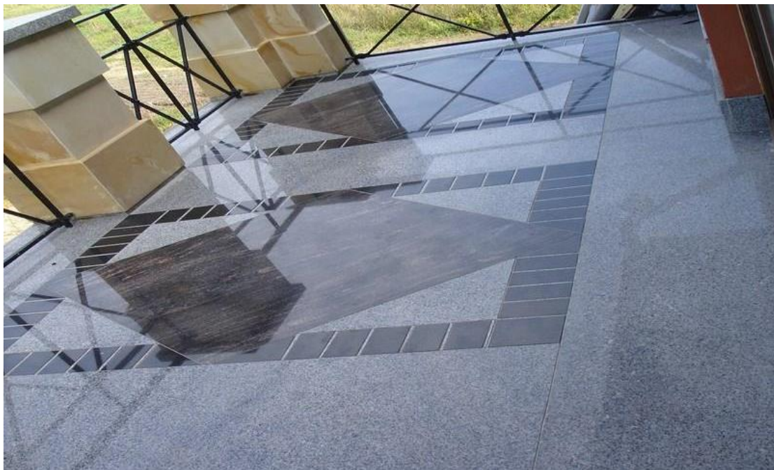
Posadzki granitowe - LITOS SP. Z O.O. STRZEGOM
