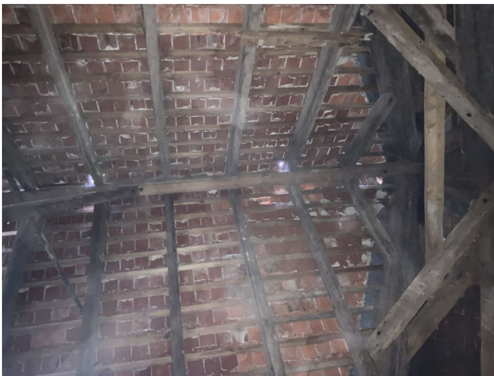
Widok od wnętrza na kalenice- zdjęcie własne
