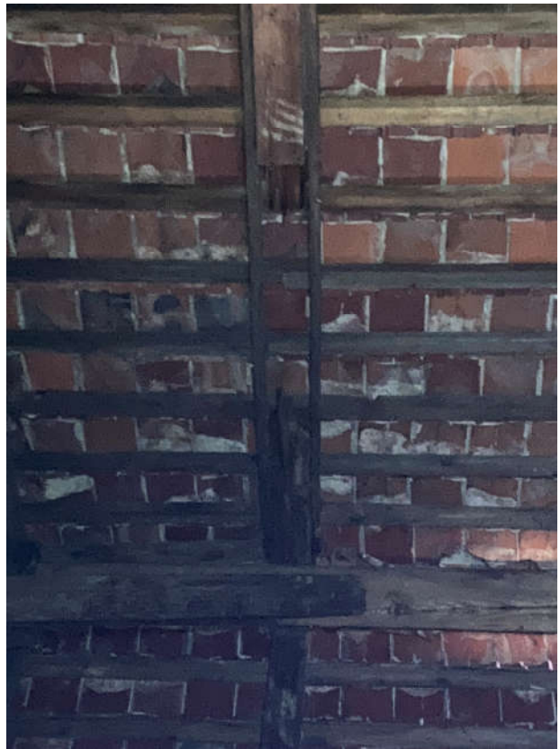
Uszkodzone krokwie dachowe- zdjęcie własne
