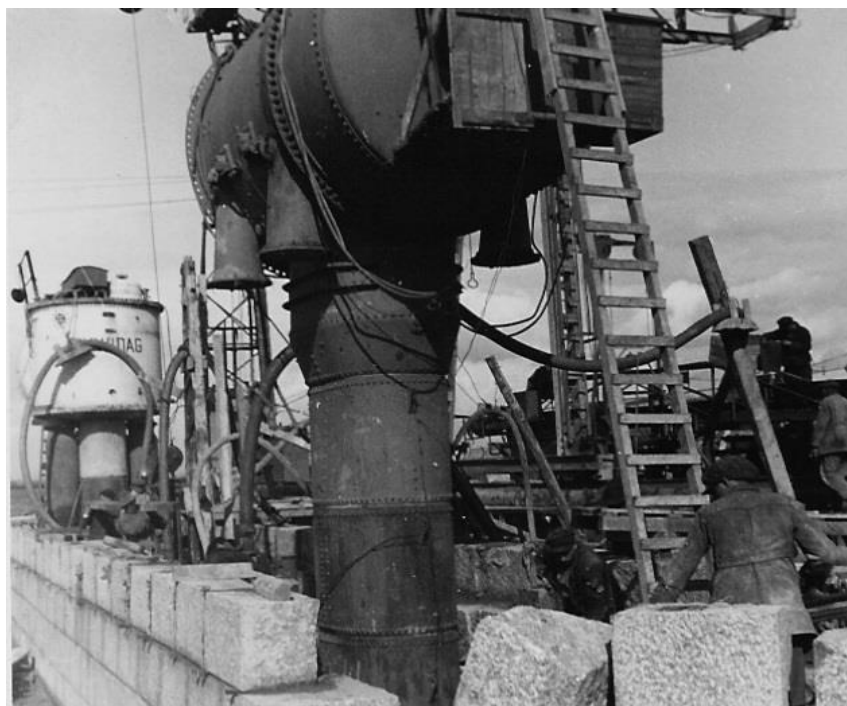
Budowa mostu z licówki granitowej na Odrze.
