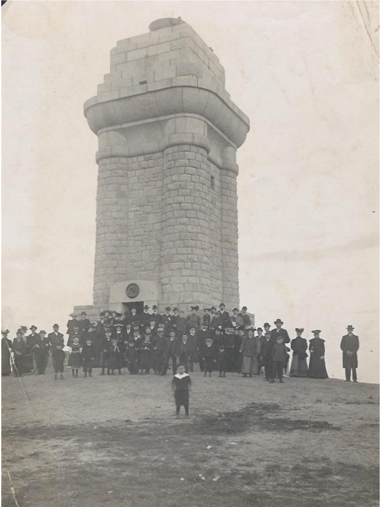
Zastosowanie licówki do budowy wieży.
