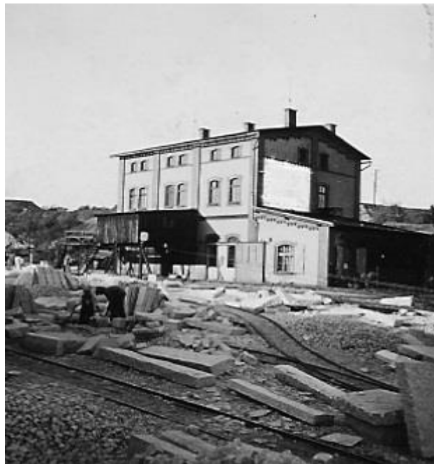
Granit w Strzegomiu – Graby Kamieniołom Nr 25 Budynek techniczno – gospodarczy.
