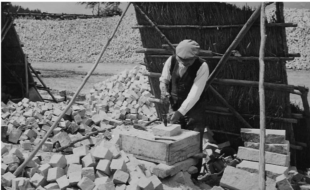
Podział półformaka kostkowego na 2 ćwierćformaki za pomocą nacinania siekaczem pobijanego młotkiem. Łom w Rogoźnicy.
