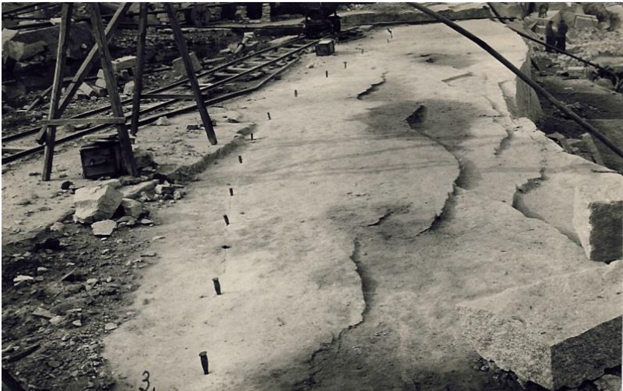
Pęknięcie ławy granitu, zaznaczone klinami po odstrzale pojedynczego otworu strzelniczego, załadowanego prochem lub saletrą.
