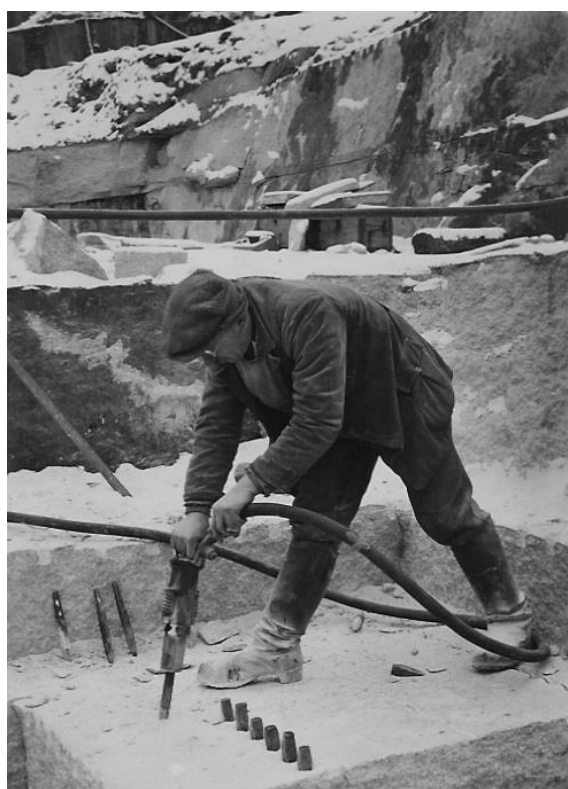
Wykuwanie gniazd na otwory klinowane za pomocą młotka pneumatycznego.
