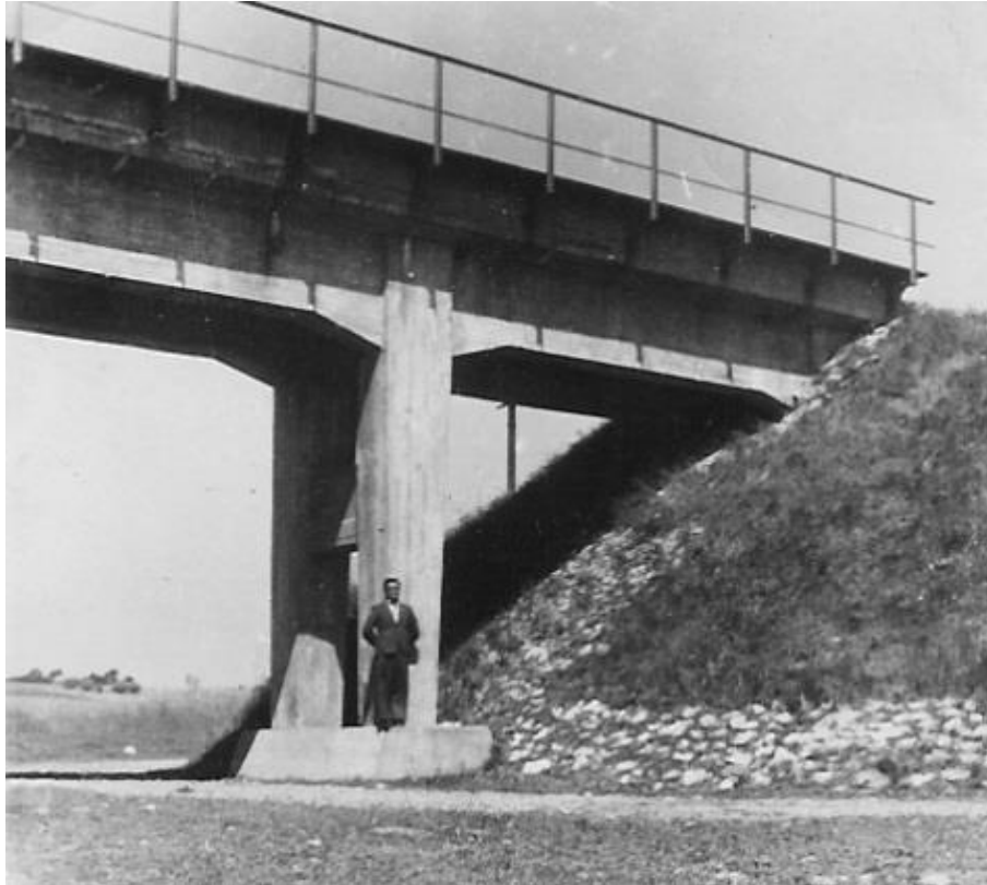
Zastosowanie licówki granitu do budowy mostu.
