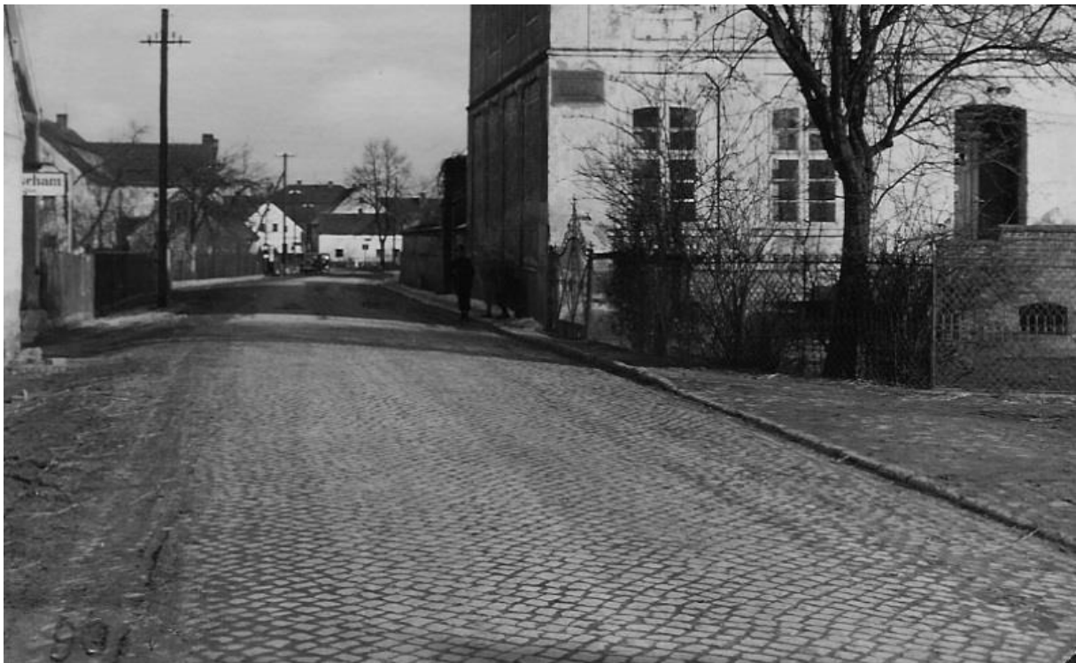
Bruk kostki granitowej.
