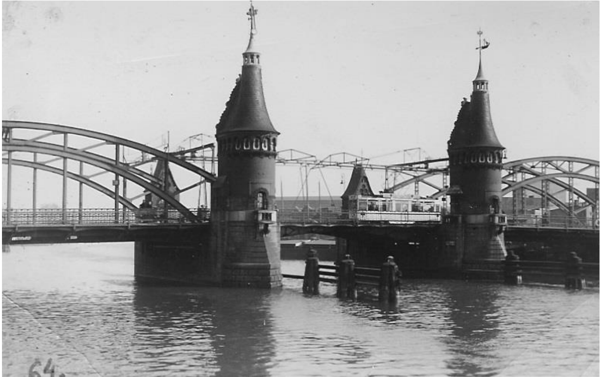
Zastosowanie licówki z granitu do budowy mostu.
