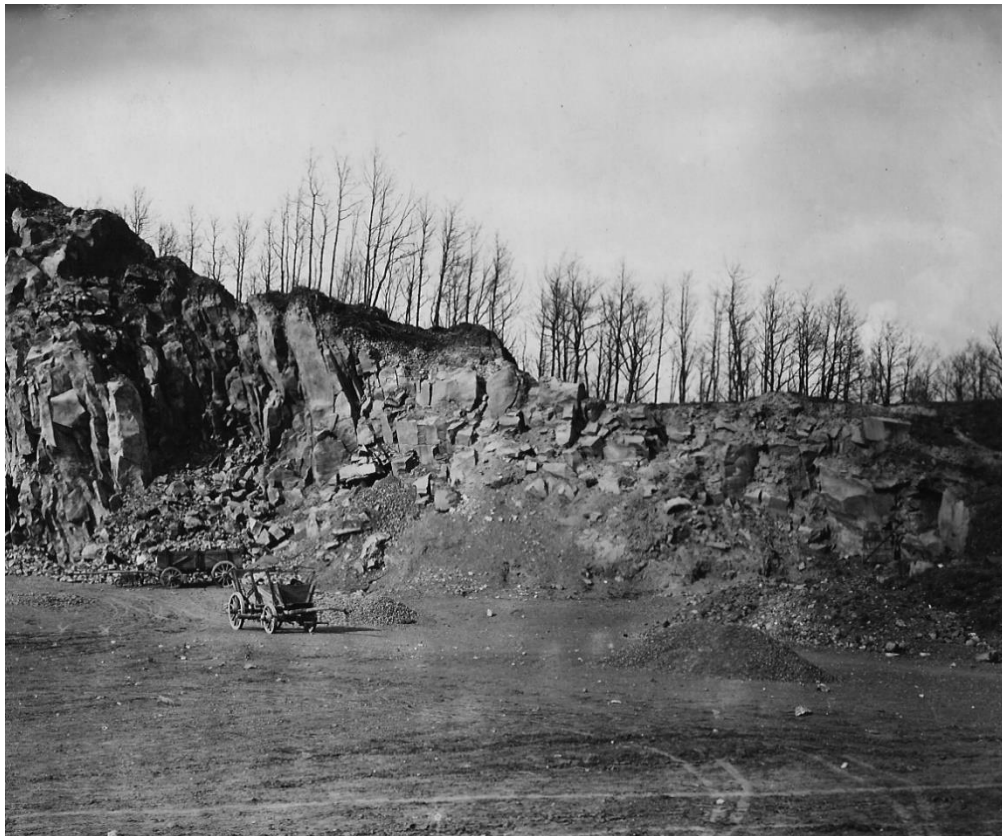
Przedłużenie ściany bazaltowej na I poziomie kamieniołomu przy Szerokiej Górze w Strzegomiu.
