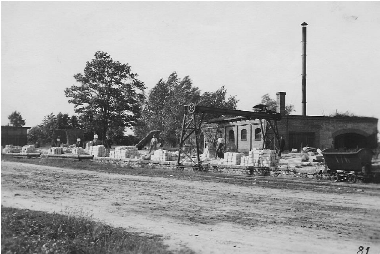
Rampa załadownicza z suwnicą do ładowania wyrobów granitowych na wagony normalnotorowe.
