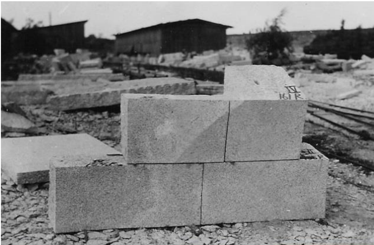
Elementy licówki budowlanej z granitu.
