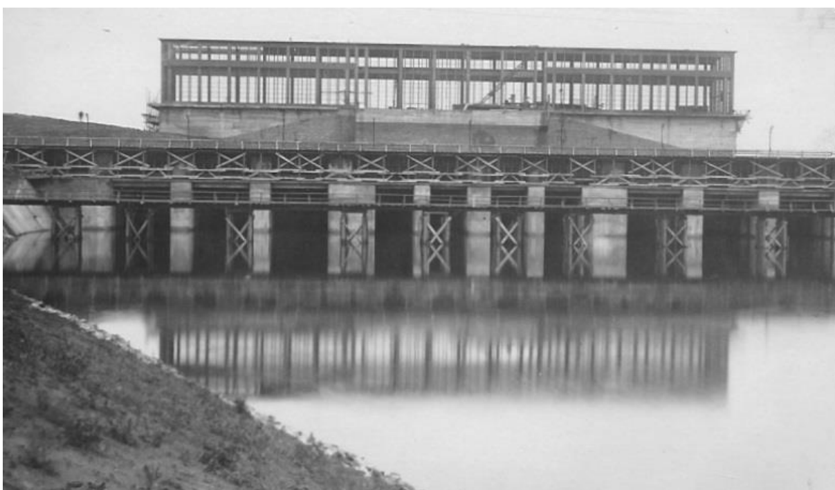
Zastosowanie licówki z granitu przy budowlach wodnych.
