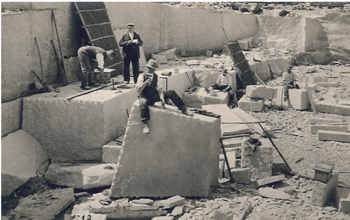
Podział bloków i wyrównywanie nierówności krawędzi dużego bloku.
