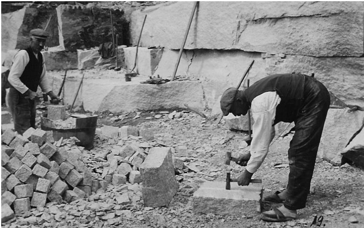
Podział płyty granitu do wyrobu formaków na kostkę na mniejsze elementy do wyrobu formaków kostkowych.
