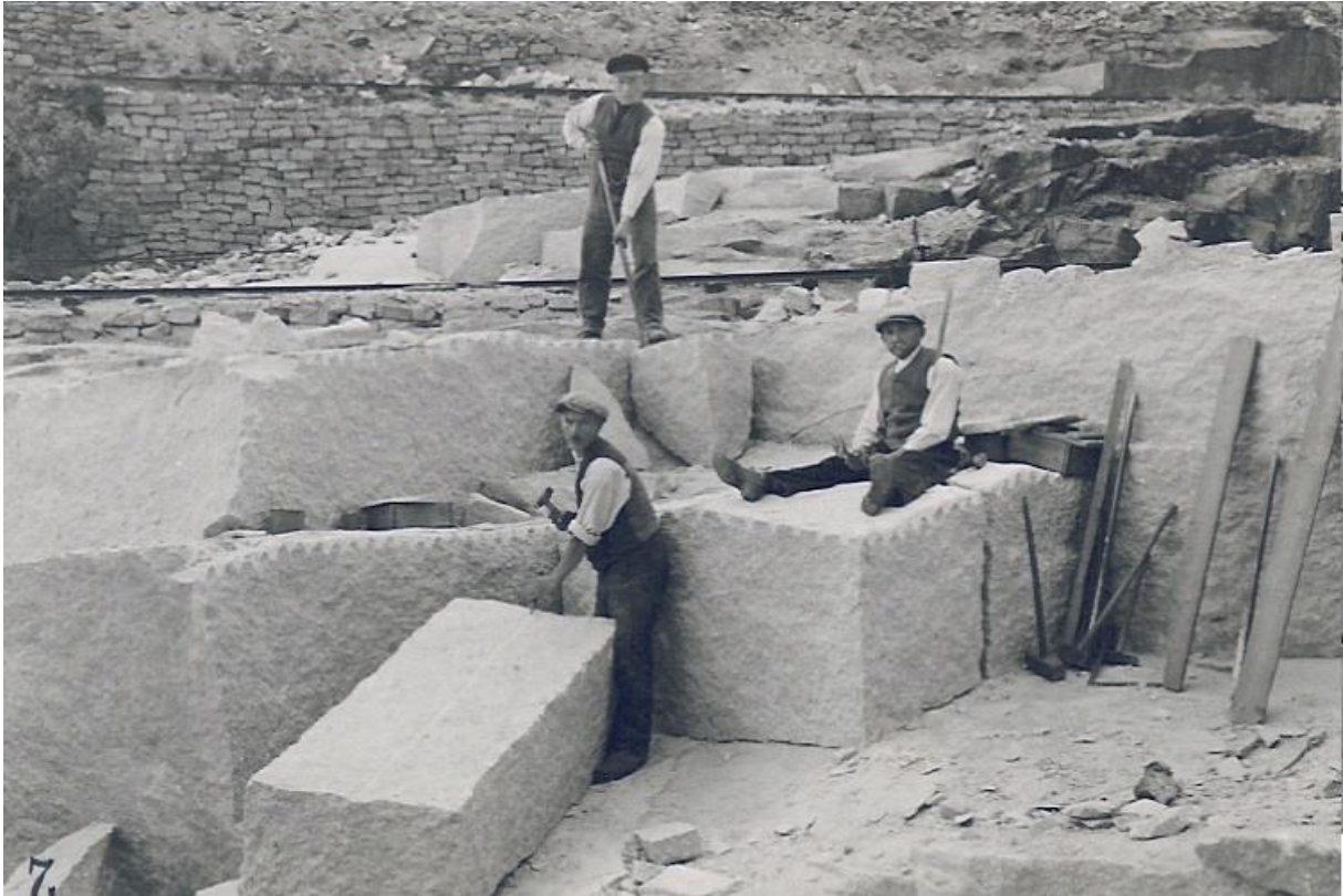
Rozpoczęcie drążenia gniazd klinowych wzdłuż bruzdy podziału bloku granitu, za pomocą szpicaka i młotka ręcznego..
