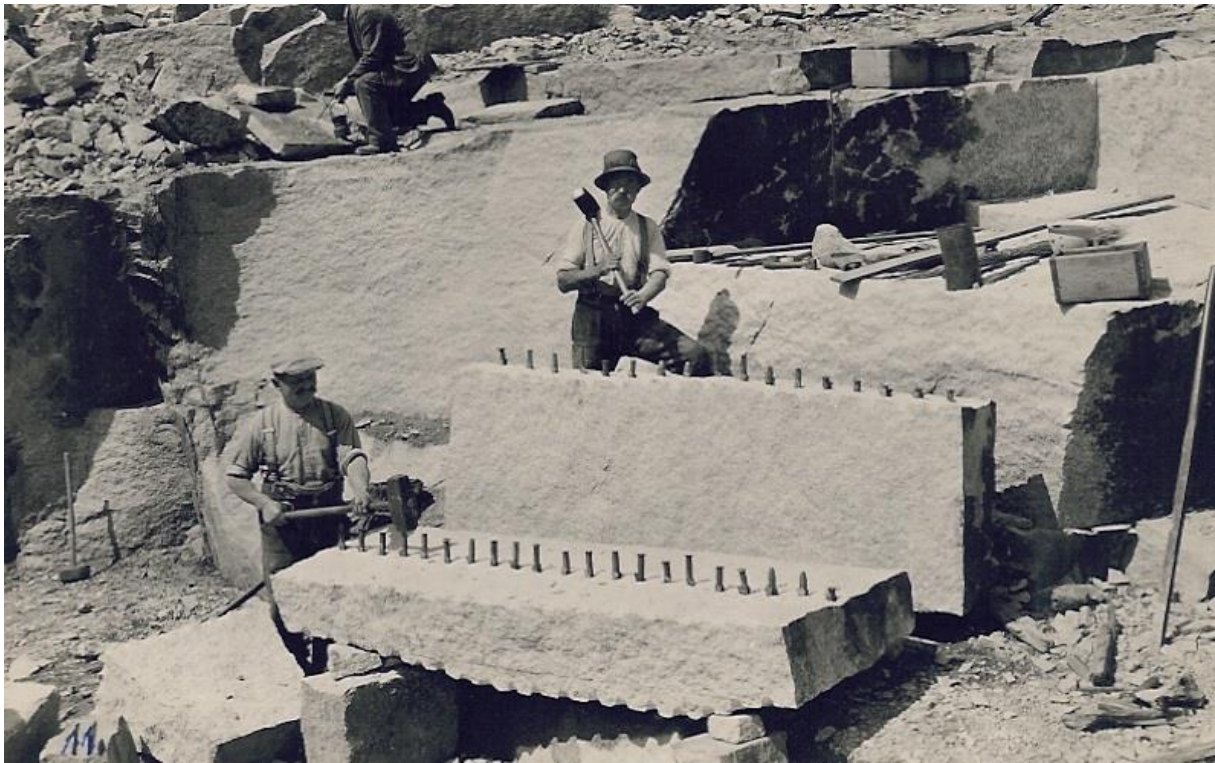
Podział płyt granitu na mniejsze elementy metodą klinową
