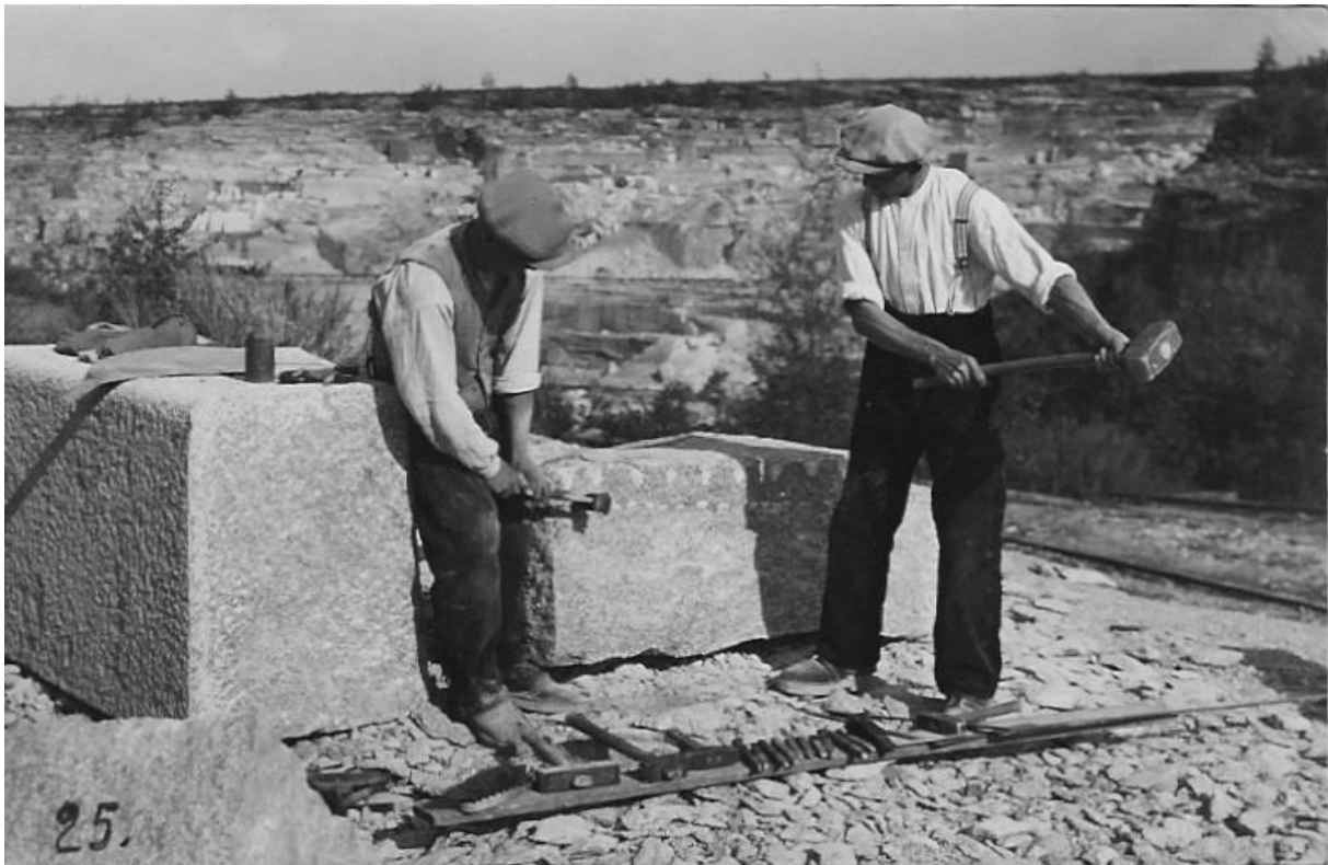
Kamieniarze nacinają rysę (bruzdę) by oddzielić nadmiar bloku granitu.
