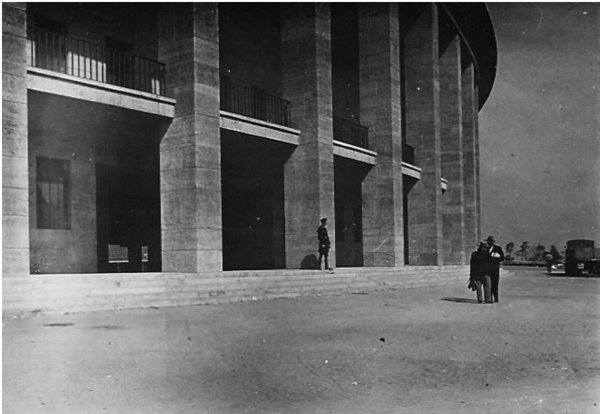
Zastosowanie licówki granitowej przy budowie gmachu.
