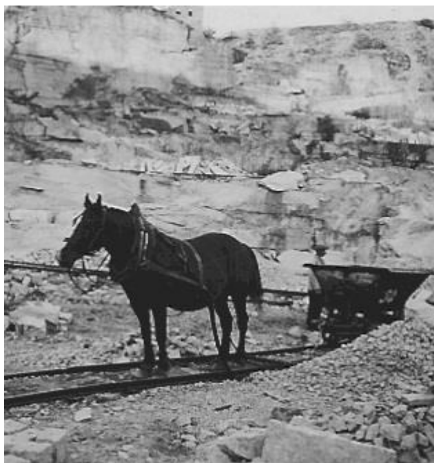
Przewóz konny wywrotki po wzniosie w kamieniołomie granitu.
