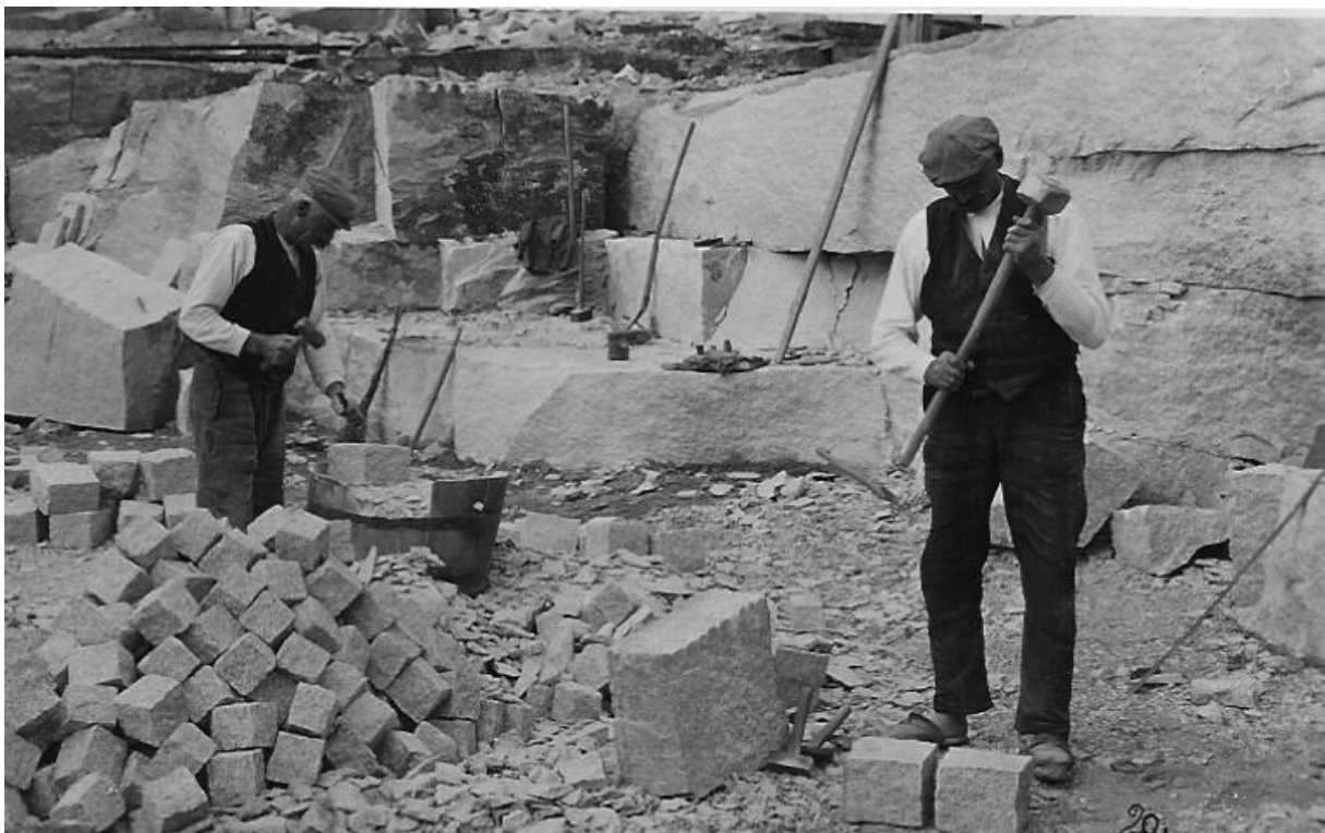
Dalszy podział mniejszych płyt do wyrobu formaków kostkowych na formaki kostkowe i wyrób z nich kostki.
