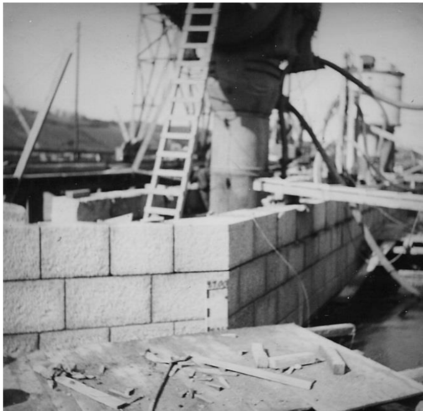
Budowa mostu z licówki granitowej na Odrze.
