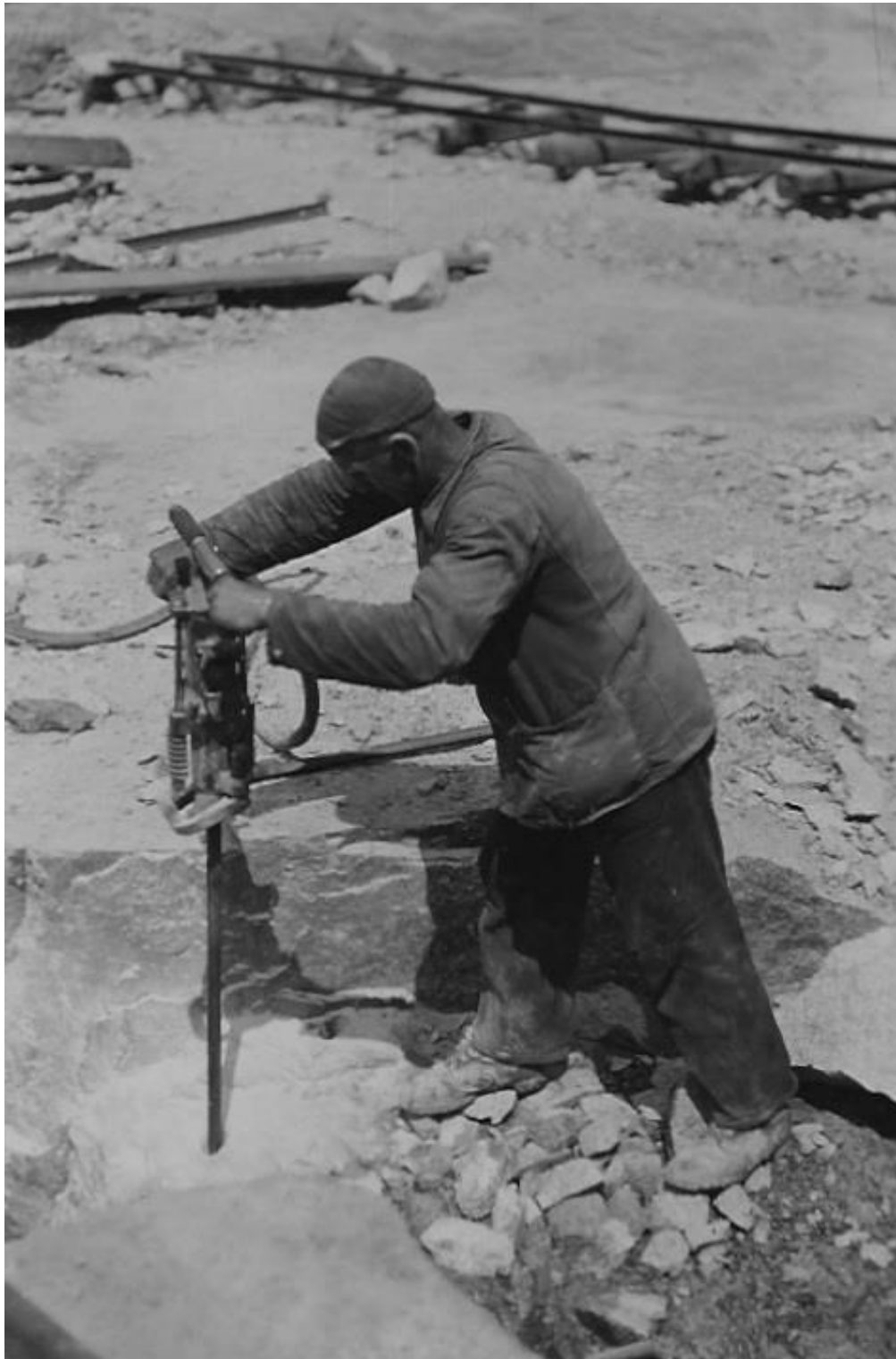
Wiercenie otworów strzałowych lub piły wiertniczej za pomocą wiertarki udarowej, napędzanej sprężynym powietrzem w granicie
