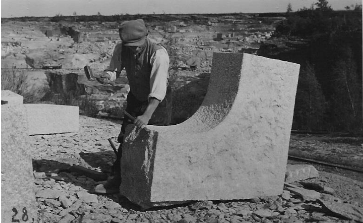
Grotowanie powierzchni elementu granitu.
