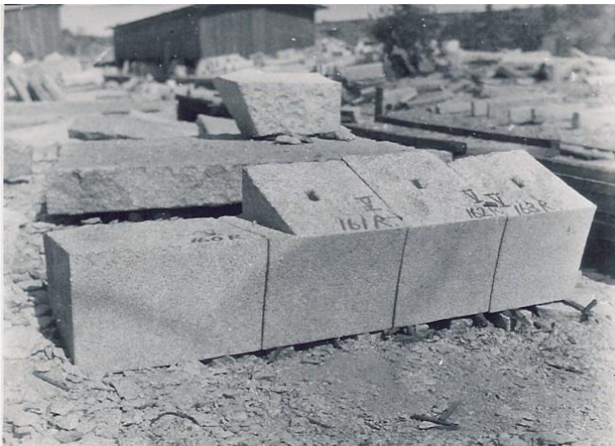
Elementy licówki budowlanej z granitu.
