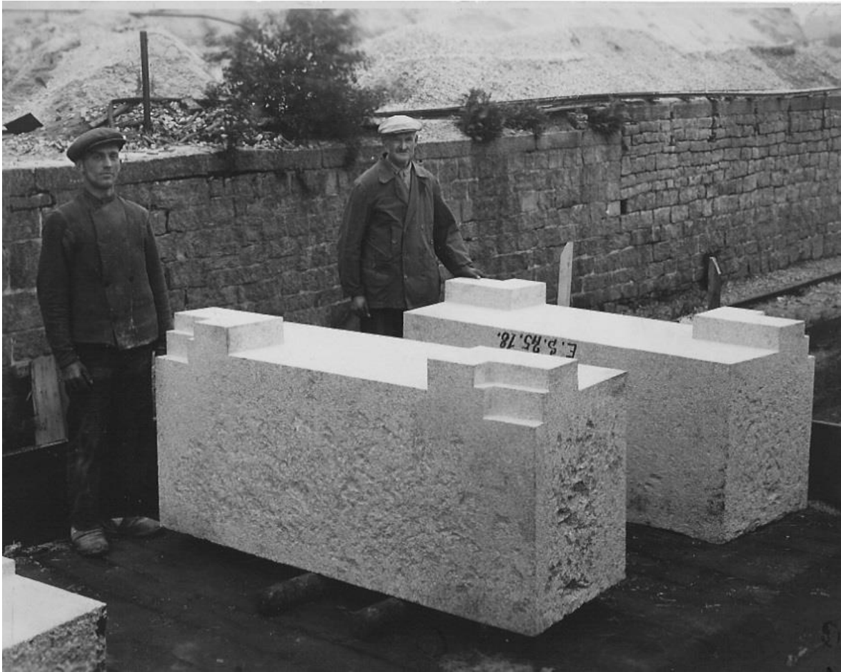
Elementy licówki budowlanej z granitu.
