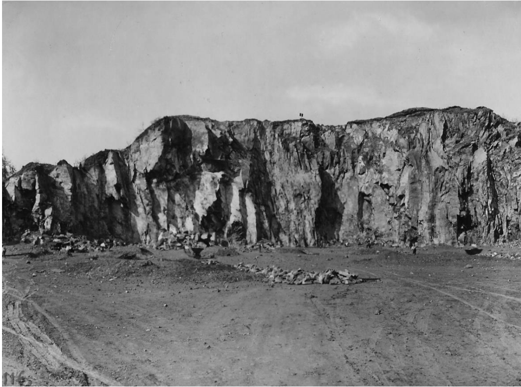
Ściana bazaltowa przy Górze Szerokiej w kamieniołomie w Strzegomiu. Poziom I
