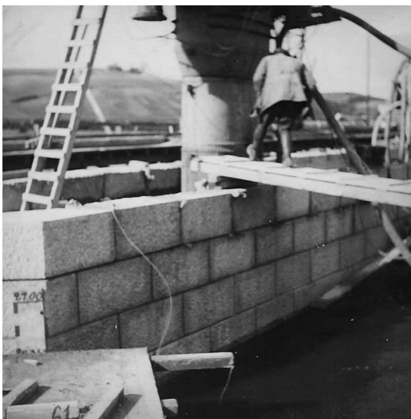
Budowa mostu z licówki granitowej na Odrze.
