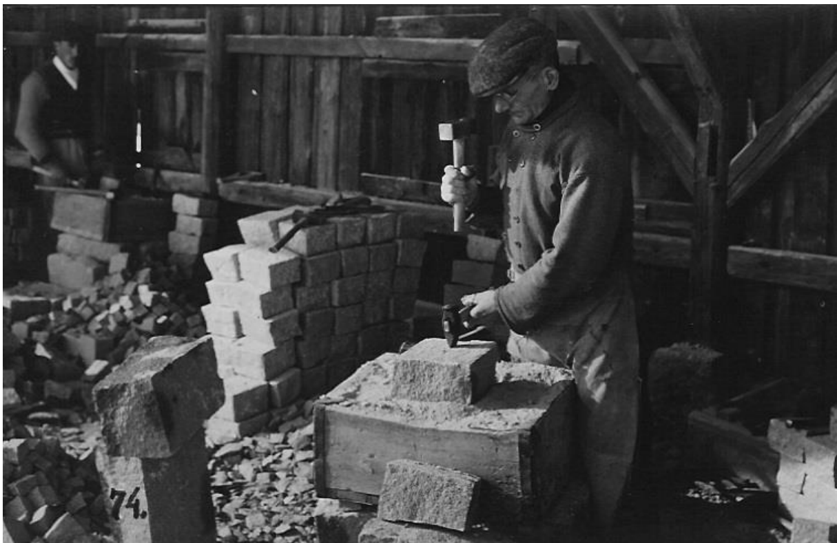
Podział półformaka (prostokątnego) granitu na 2 ćwierćformaki za pomocą nacinania rysy siekaczem pobijanym młotkiem na kostkę.
