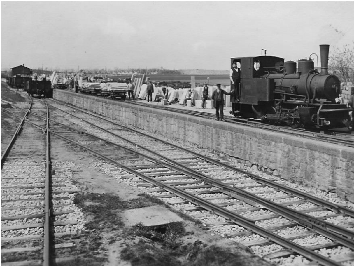
Rampa załadowcza kamieniołomu granitu Nr 18. na Grabach w Strzegomiu.
