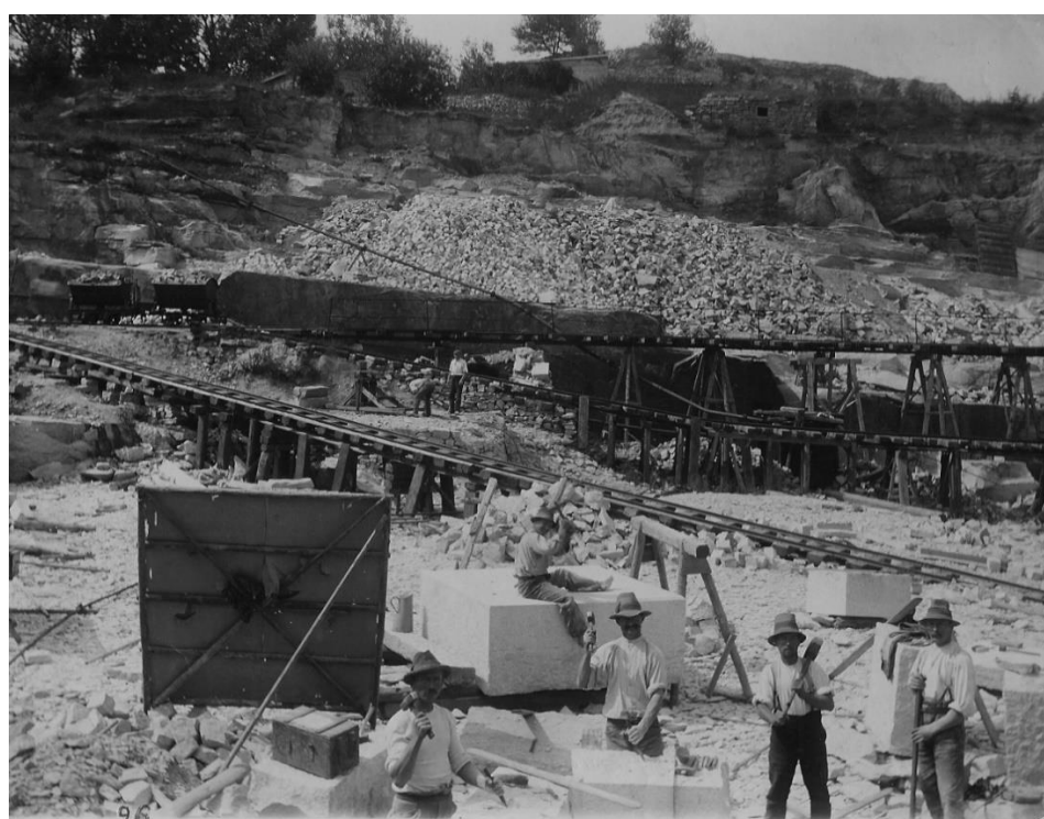
Paserowanie (szpicowanie) i groszkowanie bloków granitu.
