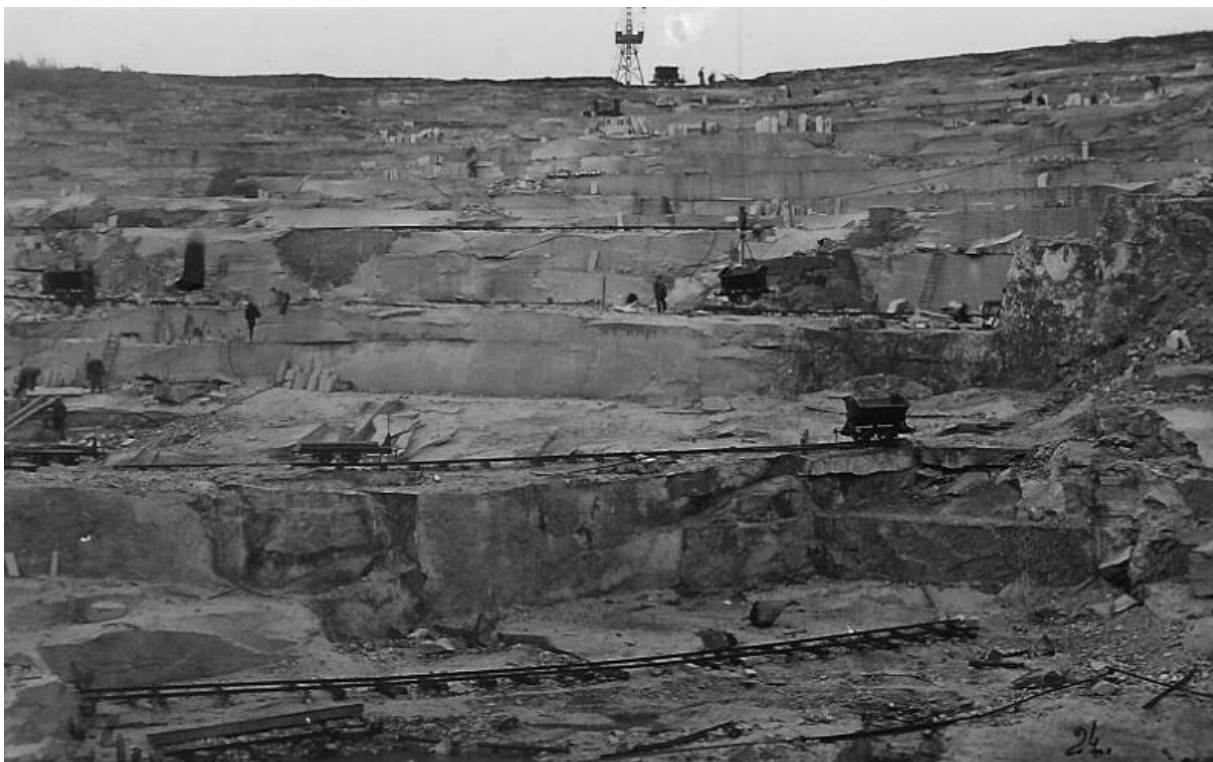
Transport wywrotek ładownych podnośnikami linowymi.
