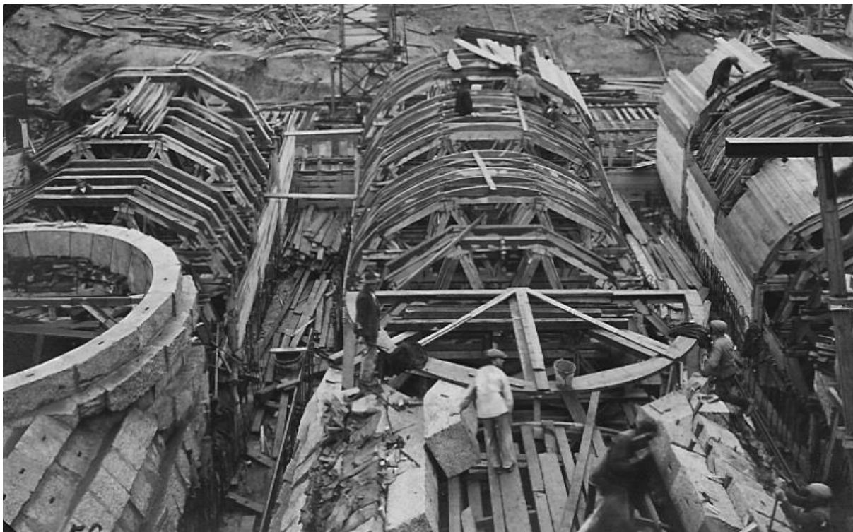
Zdjęcie z trzech spustów sztolniowych przy budowie spiętrzenia wody w Zbiorniku (Jeziorze Otmuchowskim). Jasne części spustów wykonane z kopulaków (licówki) granitowej.
