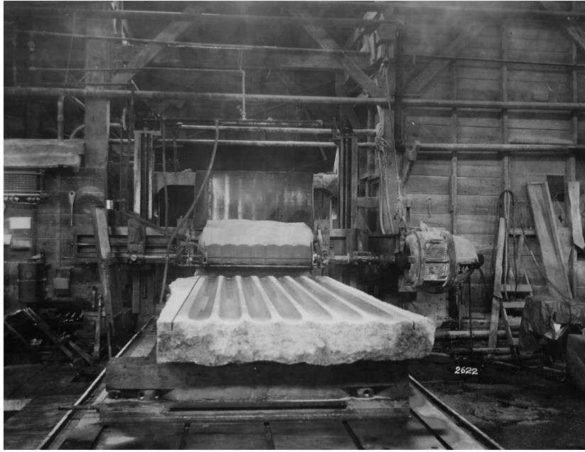
Obróbka mechaniczna elementów kamiennych.
