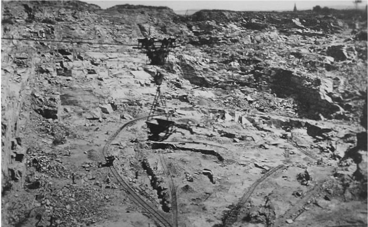
Transport granitu za pomocą podnośników linowych.
