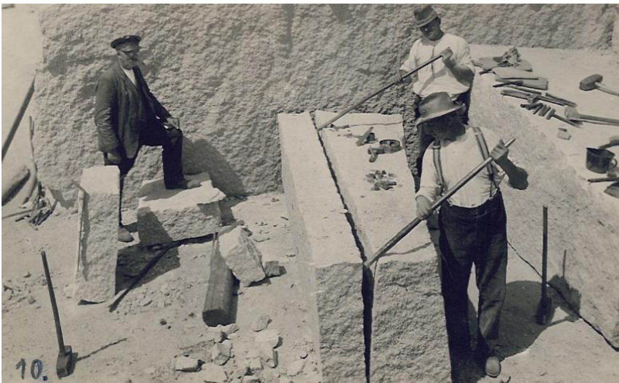
Przewrócenie za pomocą łomów płyty granitu, uzyskanej z podziału bloku granitowego.
