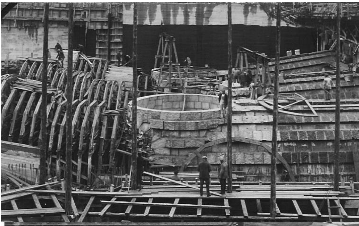
Zdjęcie z 3 spustów sztolniowych przy budowie nakrytego spiętrzenia wody w Zbiorniku Jeziora Otmuchowskiego. Spusty sztolniowe są wykonane z okrągłej (łukowej) licówki granitu
