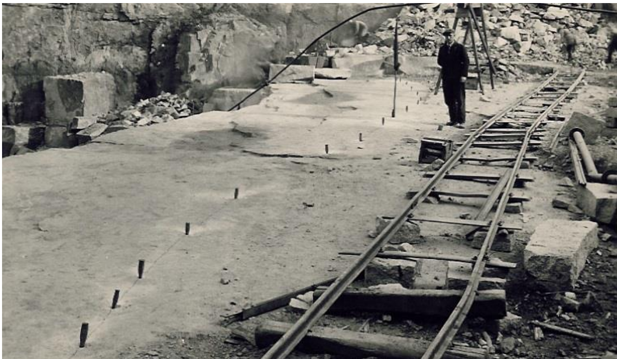
Pęknięcie ławy granitu, zaznaczone klinami po odstrzale pojedynczego otworu strzelniczego, załadowanego prochem lub saletrą.
