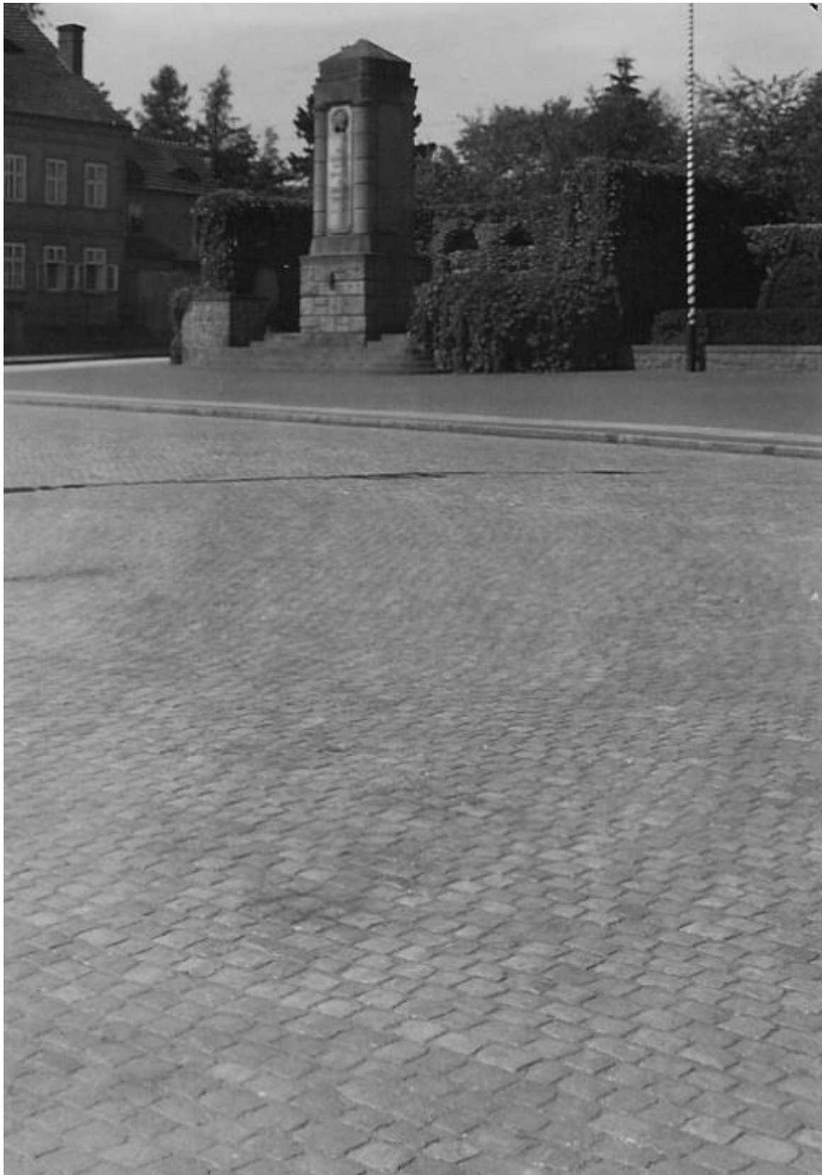
Zastosowanie granitu do budowy ulicy (kostka) i pomnika (licówka).
