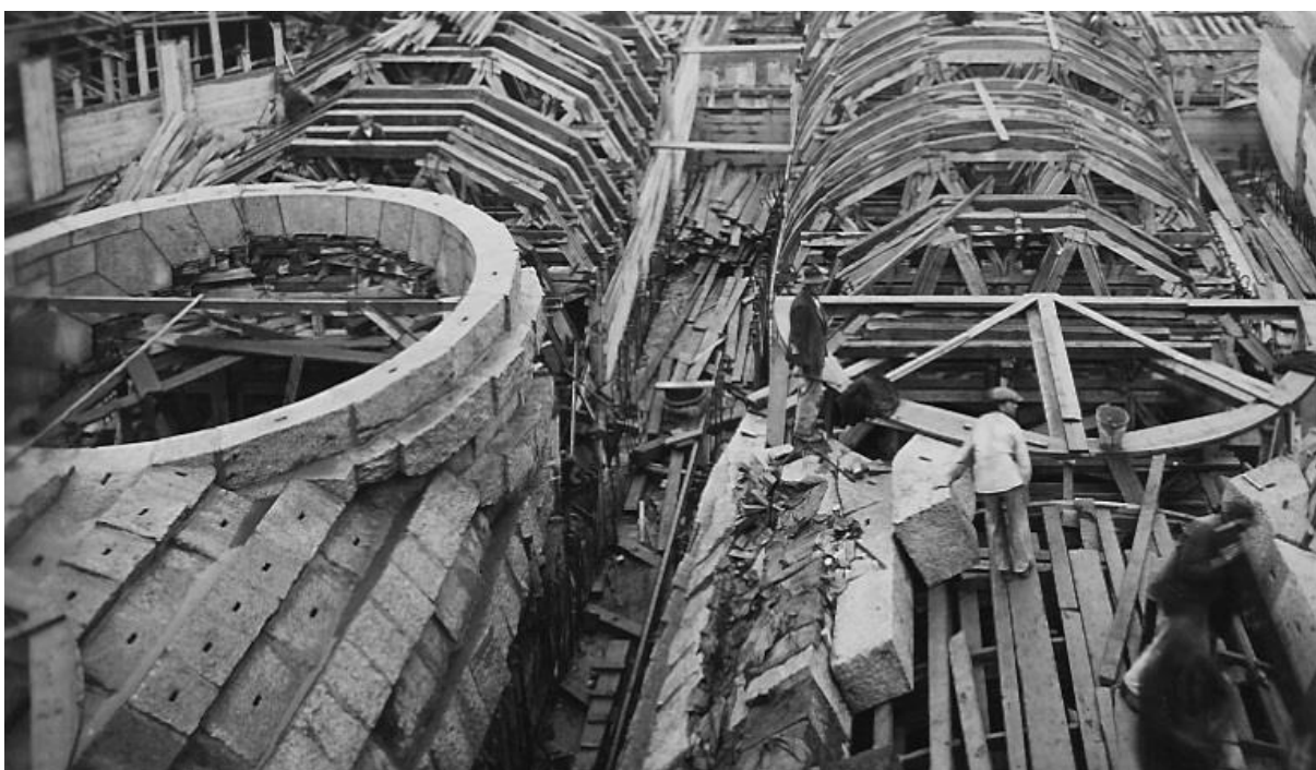
Zdjęcie ze spustów sztolniowych przy budowie spiętrzenia wody w Zbiorniku Otmuchowskim (Jeziorze Otmuchowskim). Jasne części spustów sztolniowych są wykonywane z granitu.
