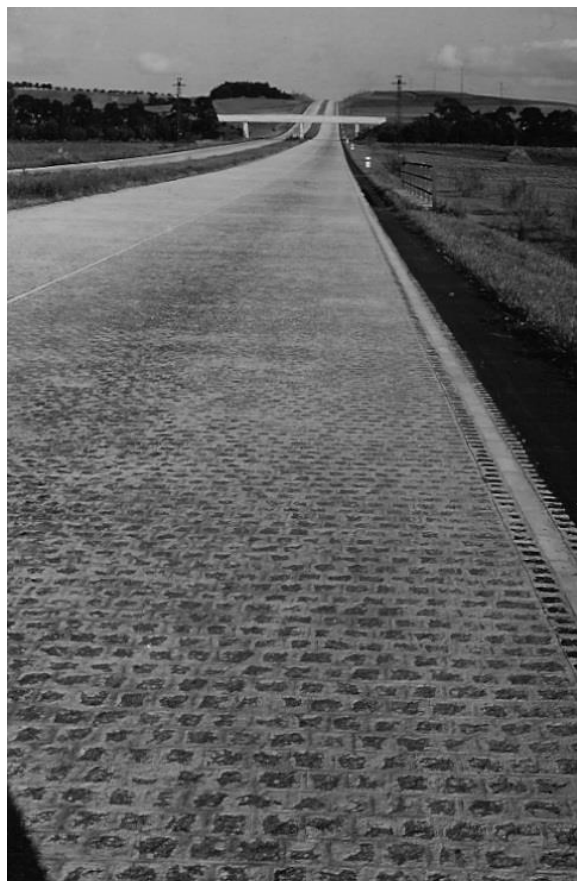
Zastosowanie kostki granitowej do budowy dróg – autostrada.
