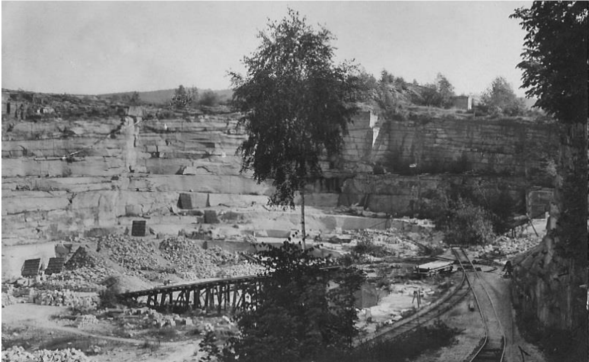
Widok na kamieniołom granitu blocznego.
