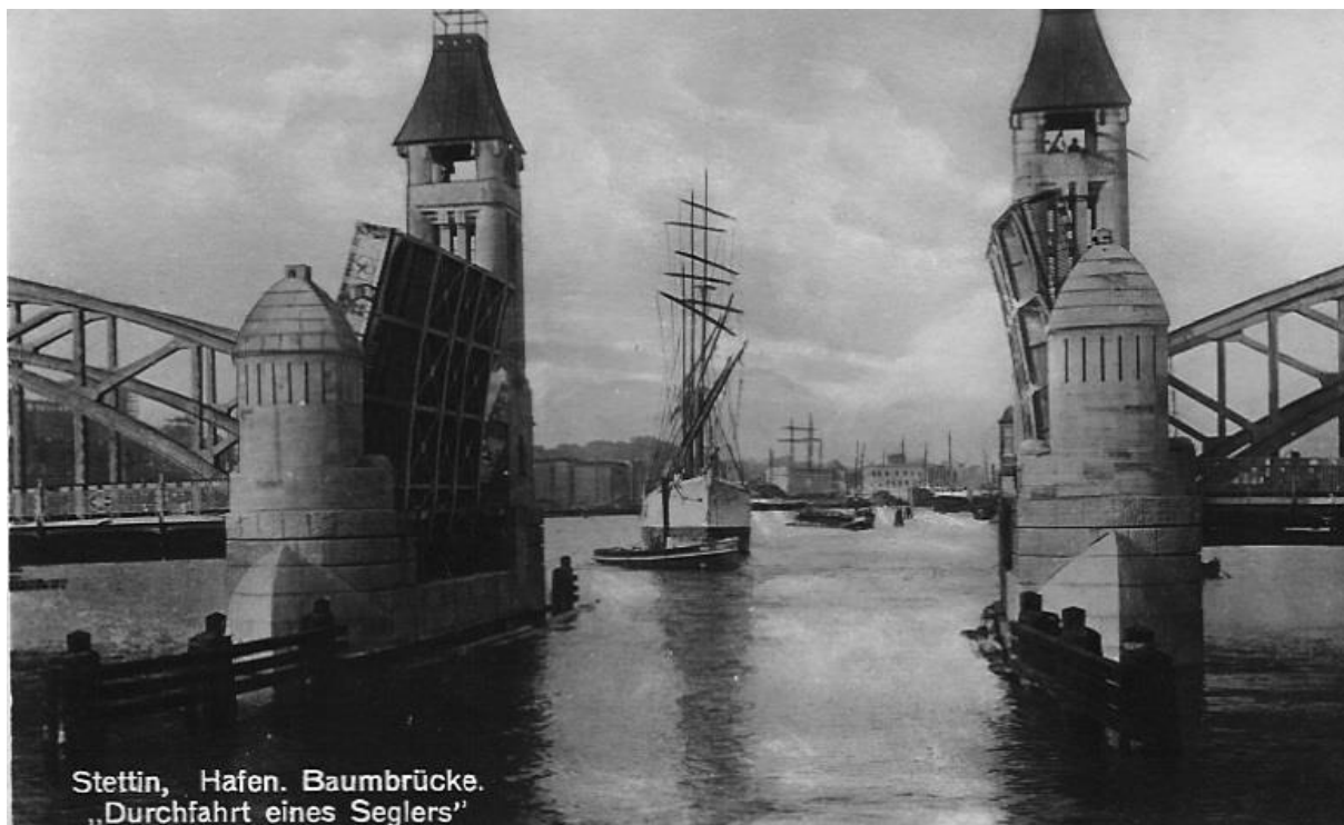
Zastosowanie licówki z granitu do budowy mostu.
