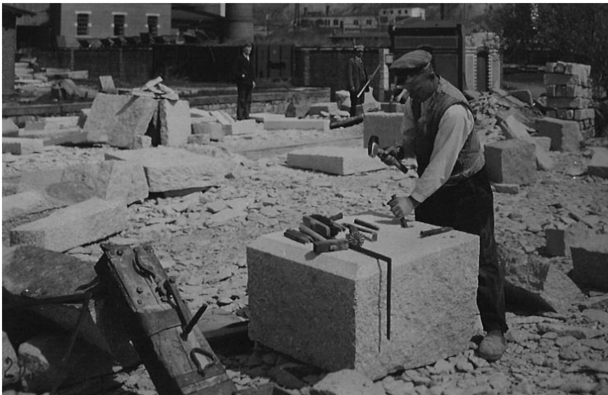
Ręczne kucie otworu w obrobionym elemencie granitu.
