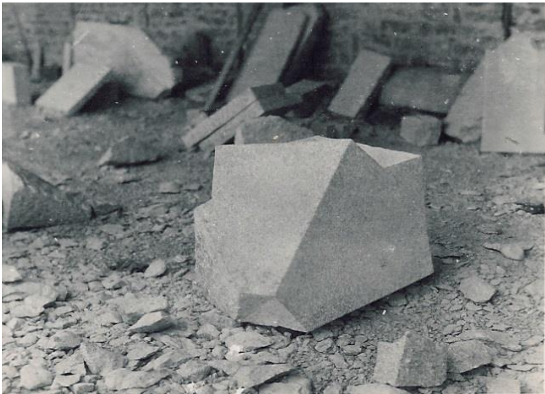
Elementy licówki budowlanej z granitu.
