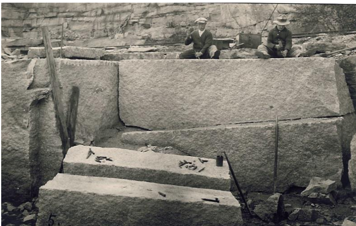
Wykuwanie ręczne dwóch równoległych szeregów gniazd (otworów) klinowanych za pomocą szpicaków (grotów), celem podziału dużego bloku granitu na mniejsze bloki
