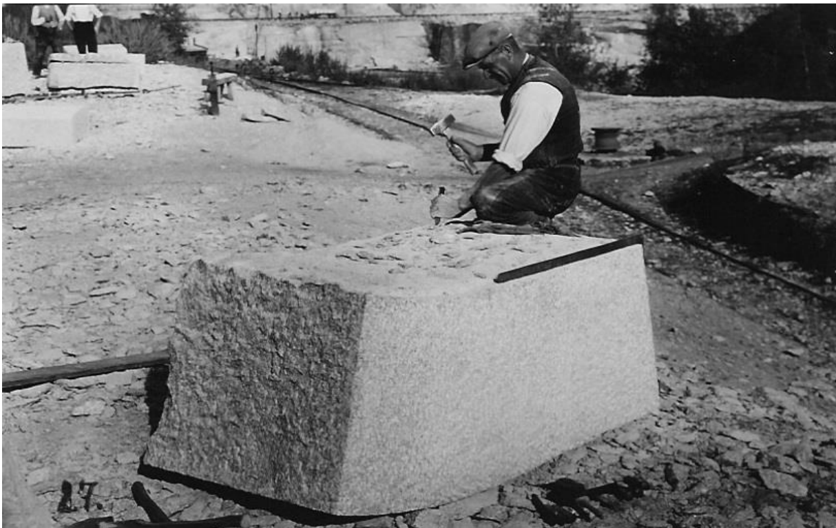
Szpicowanie powierzchni elementu granitu.
