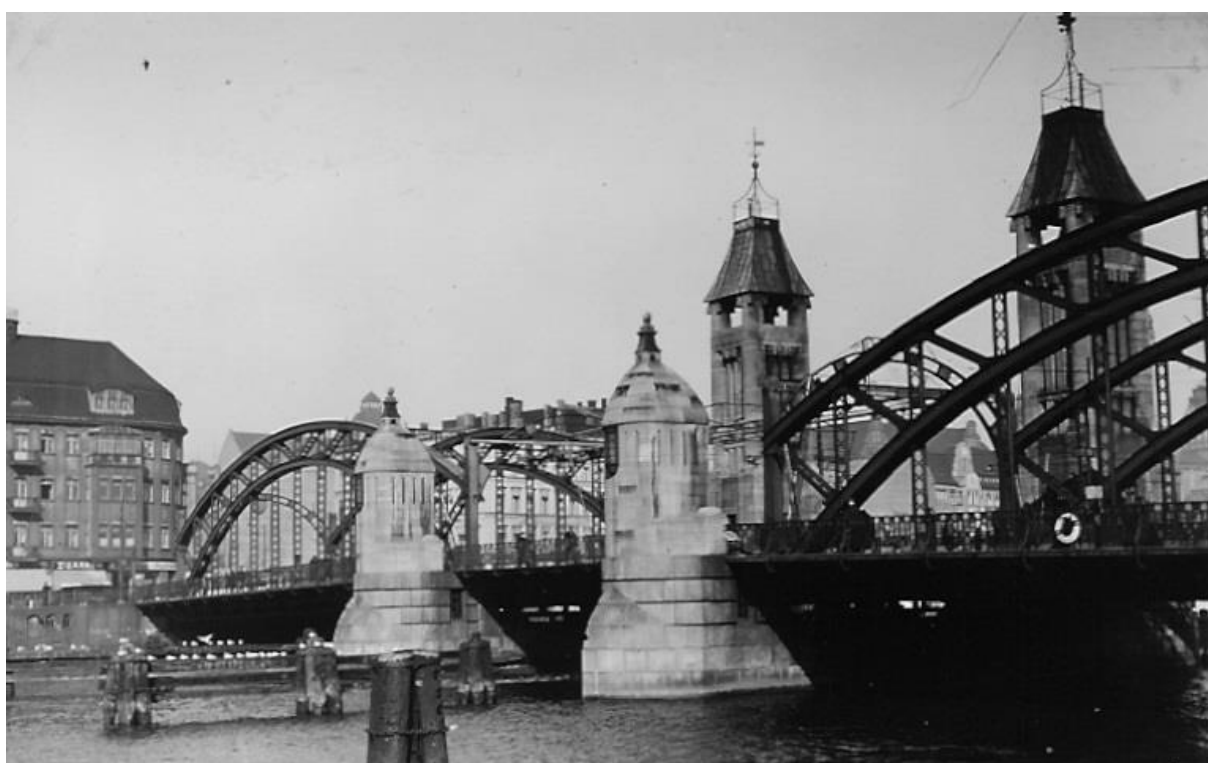
Zastosowanie licówki z granitu do budowy mostu.
