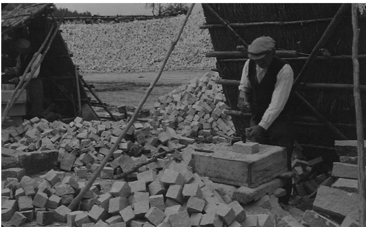
Podział ćwierćformaka granitu na 2 kostki nieregularne średnie 8-11 cm za pomocą nacinania siekaczem, pobijanym młotkiem na 1-2 ściankach.
