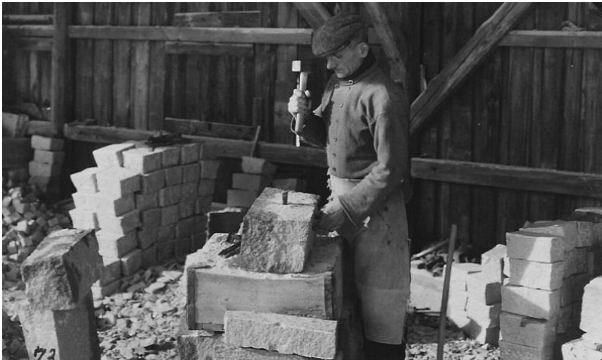
Podział sześciennego formaka granitu na 2 półformaki na kostkę nieregularną za pomocą nacięcia bruzdy i klina w otworze i młotka.
