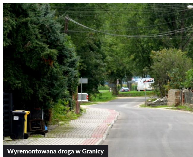
Wybudowana droga przy ul. Piekarniczej w Strzegomiu
