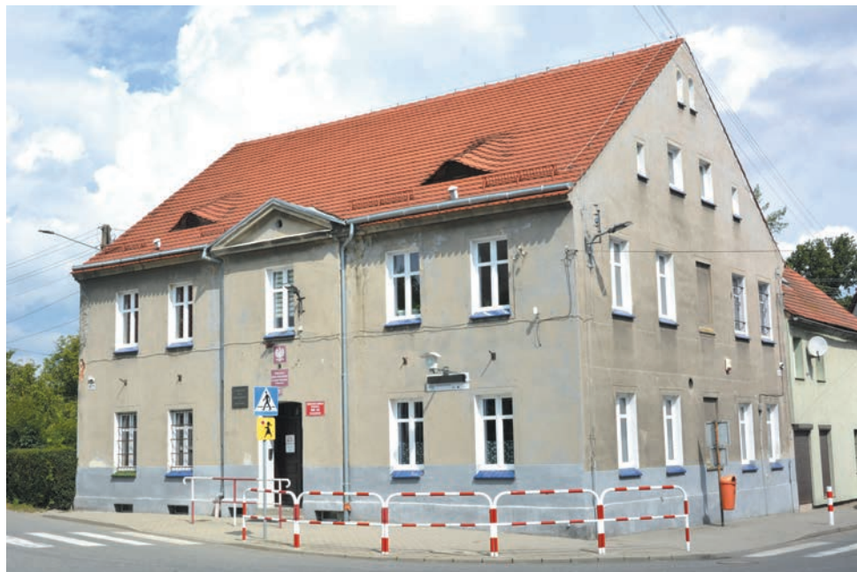
Budynek Publicznej Szkoły Podstawowej w Olszanach
