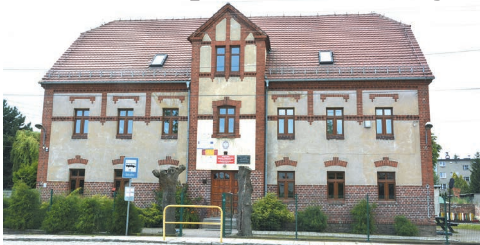
Budynek Publicznej Szkoły Podstawowej w Goczałkowie
