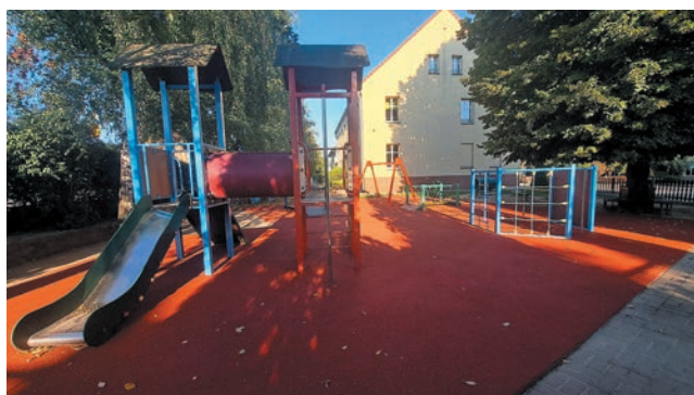
Wymiana nawierzchni placu przy Zespole Szkolno-Przedszkolnym w Jarosławie
