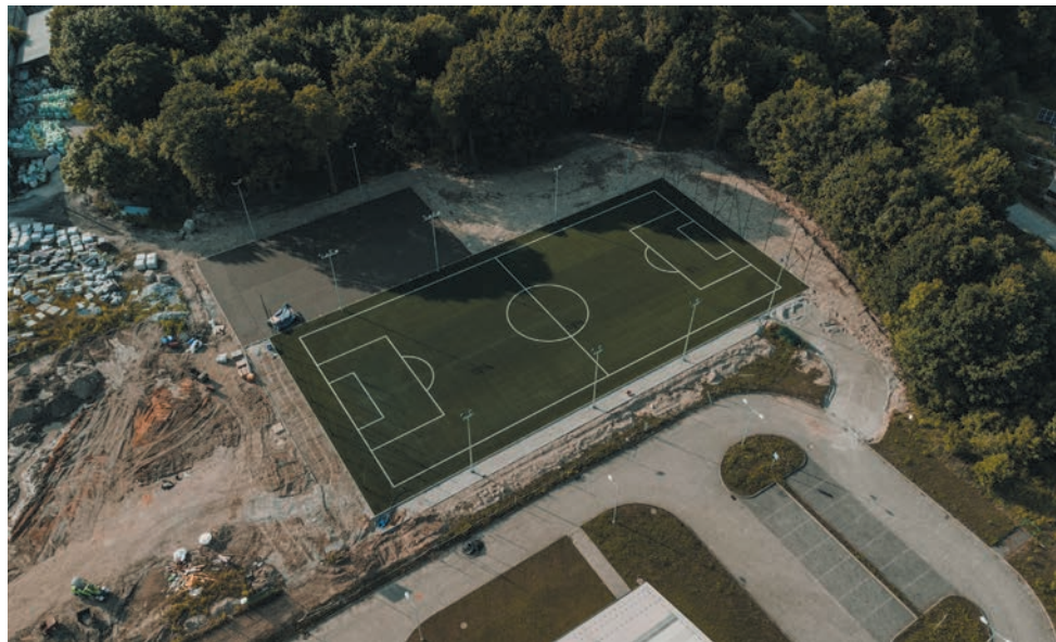
Budowa boiska Orlik w Goczałkówie
