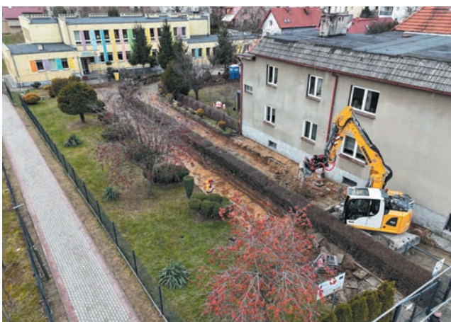
Modernizacja drogi dojazdowej i chodnika prowadzących do Przedszkola Miś Uszatek w Strzegomiu
