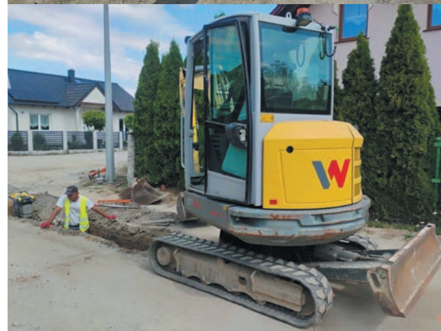
Przebudowa drogi wraz z budową kanalizacji deszczowej na osiedlu w Goczałkowie
