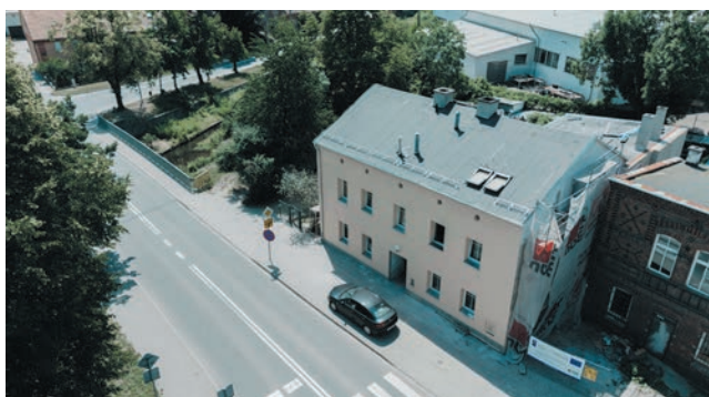
Termomodernizacja budynku przy ul. Wałbrzyskiej 2 w Strzegomiu
