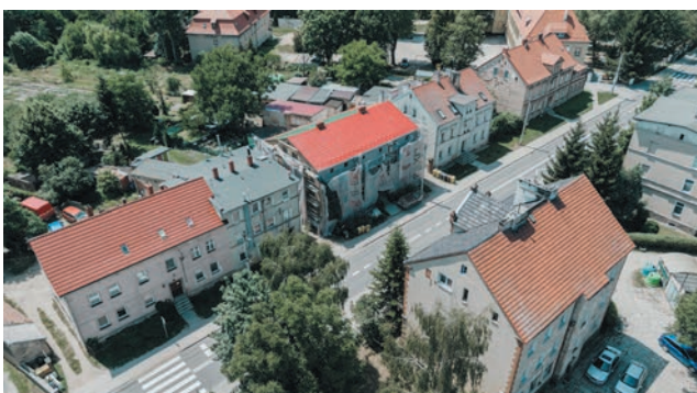
Termomodernizacja budynku przy ul. Jeleniogórskiej 13 w Strzegomiu
