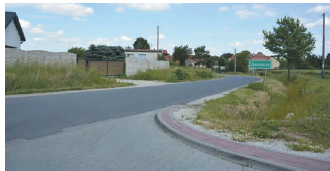
Budowa chodnika w Stanowicach
