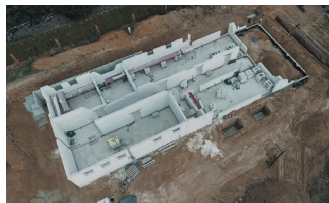
Budowa zaplecza szatniowo-sanitarnego na terenie OSiR w Strzegomiu
