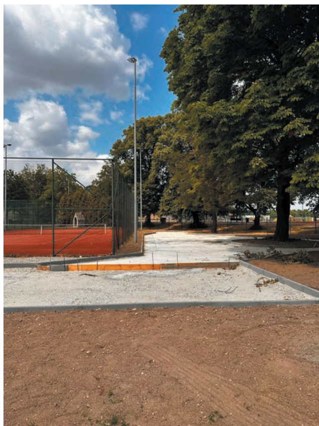
Budowa skateparku na terenie OSiR w Strzegomiu
