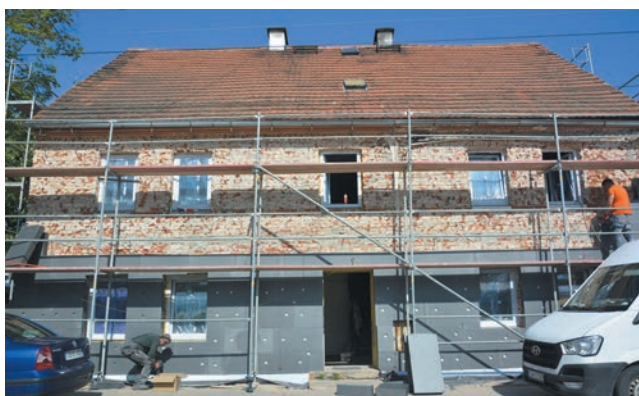
Termomodernizacja budynku w Goczałkowie przy ul. Szkolnej 5
