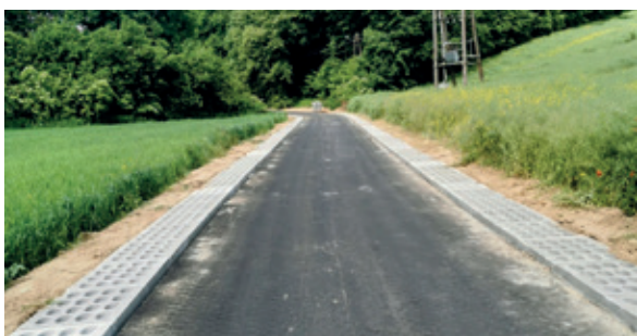
Przebudowa drogi nr 108583 Olbiewicz – Parama Górna. Odcinek około 630 metrów. Wartość inwestycji 874 tys. zł.
