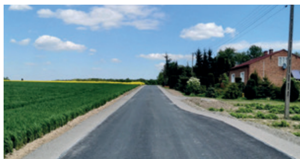
Przebudowa drogi nr 108598 Trzydnik Mały – Baranów. Odcinek około 1550 metrów. Wartość inwestycji 1 mln 544 tys. zł.
