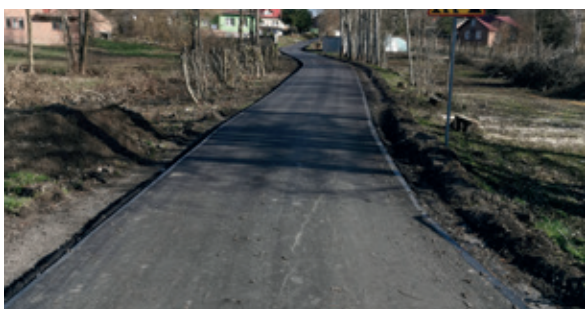
Remont drogi nr 108607 Rzeczyca Księża droga do kościoła. Odcinek około 500 metrów. Wartość inwestycji 343 tys. zł.
