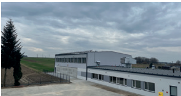
Budowa Hali Sportowej wraz z infrastrukturą towarzyszącą przy Zespole Szkolno - Przedszkolnym w Olbicieniu. Wartość zadania 7 mln 700 tys. zł.
