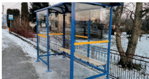
W latach 2019 – 2024 na terenie Gminy Trzydnik Duży zostało zamontowanych kilkanaście nowych wiat przystankowych.
