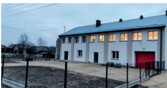
Rozbudowa i przebudowa budynku Ochotniczej Straży Pożarnej w Węglinie. Wartość inwestycji 999 tys. zł.
