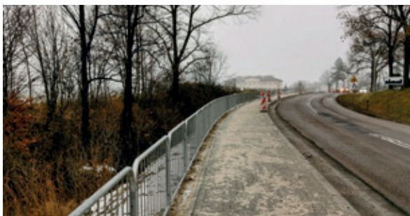
Budowa chodników przy drodze wojewódzkiej nr 855 w Węglinku i Woli Trzydnickiej. Wybudowano ok 1200 metrów. Wartość inwestycji 1 mln 325 tys. zł.
