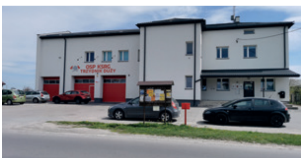
Rozbudowa Gminnego Ośrodka Kultury w Trzydniku Dużym. Wartość inwestycji 1 mln 205 tys. zł.
