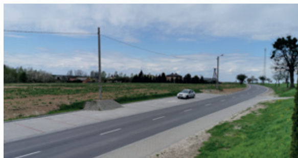
Przebudowa drogi powiatowej nr 2718L Trzydnik – Potoczek, odcinek 7 km 500 m. Wartość inwestycji 2 mln 949 tys. zł.
