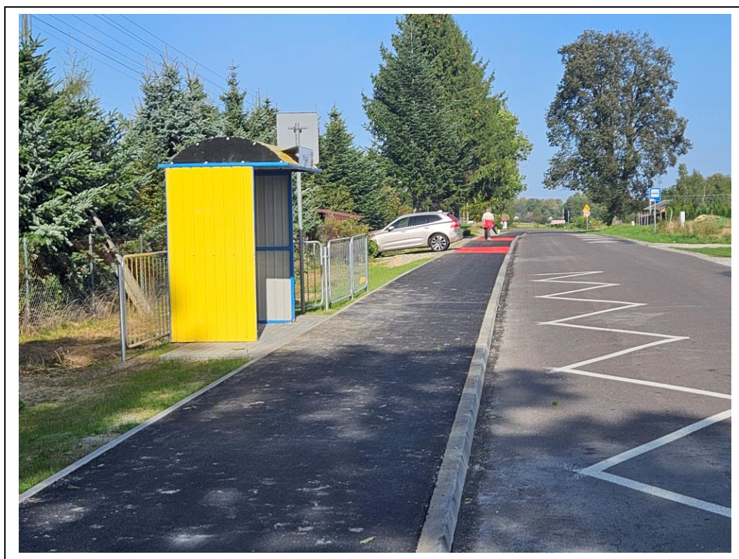
Fot. 15. Chodnik w miejscowości Miłocin przy drodze powiatowej 2233L.
