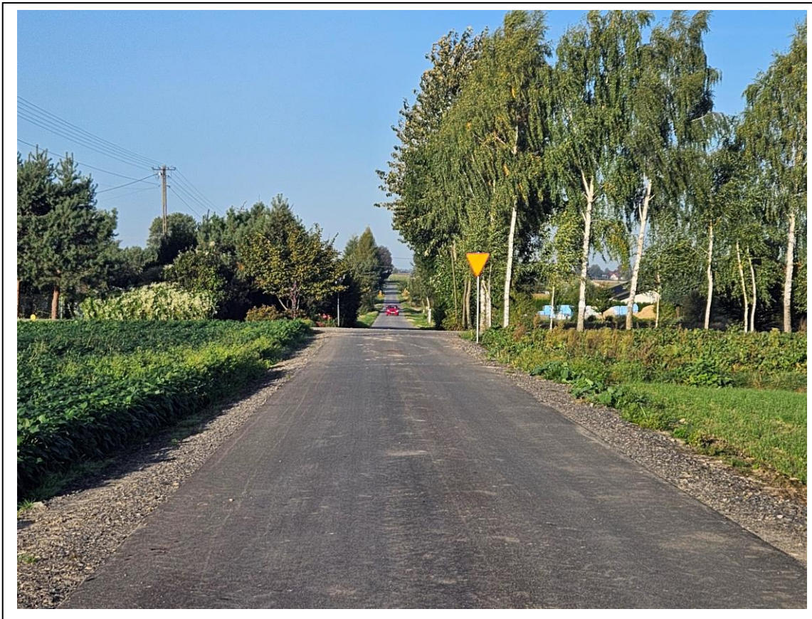
Fot. 12. Przebudowana droga wewnętrzna w miejscowości Palikije Pierwsze (dz. nr ewid. 771/2).
