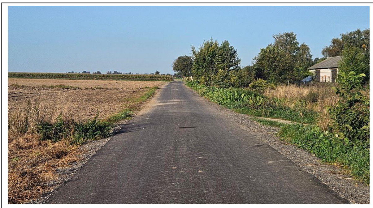
Fot. 11. Przebudowana droga wewnętrzna w miejscowości Palikije Pierwsze (dz. nr ewid. 771/1).
