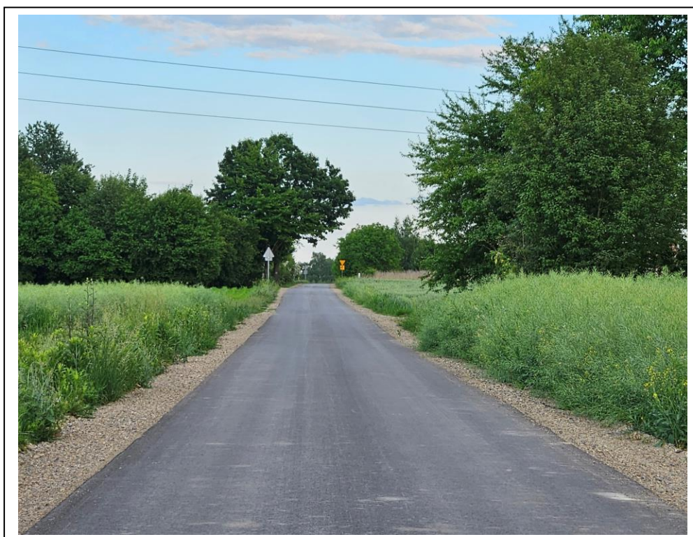
Fot. 6. Przebudowany odcinek drogi wewnętrznej w miejscowości Maszki na długości 450 m, działka nr ewid. 437.
