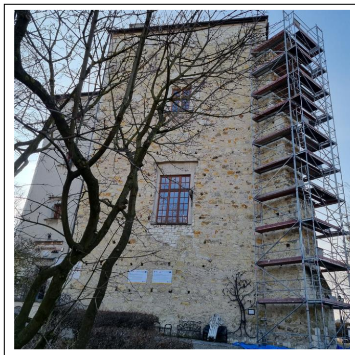
Fot. 71. Remont elewacji wschodniej i zachodniej Wieży Ariańskiej.
