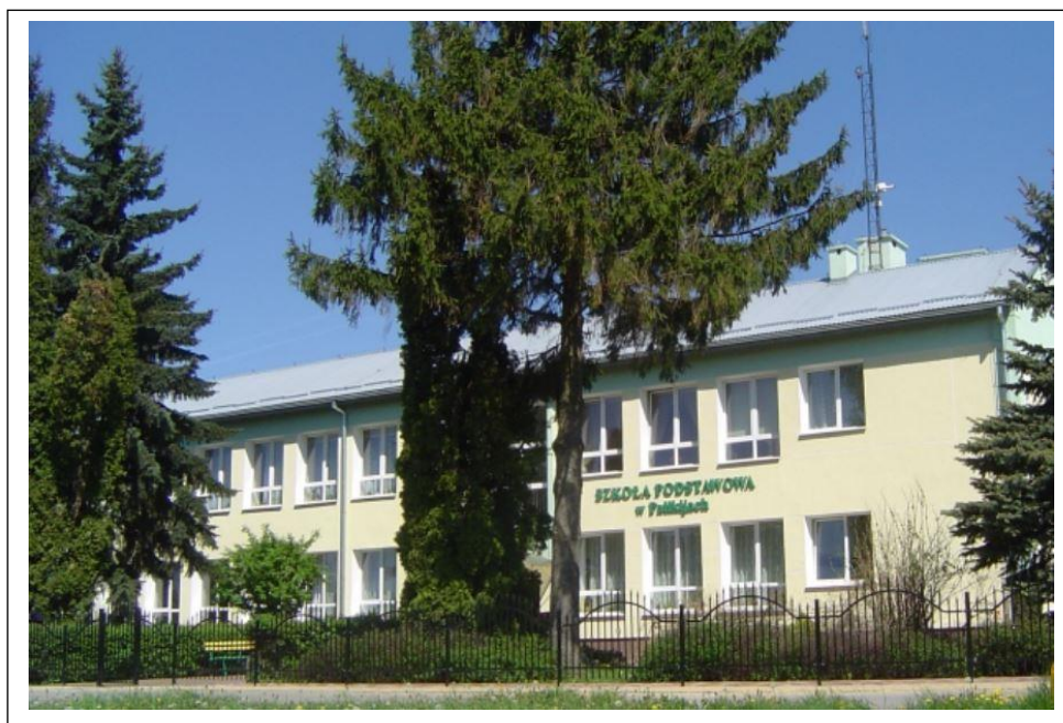
Fot. 36. Budynek Szkoły Podstawowej w Palikijach.
