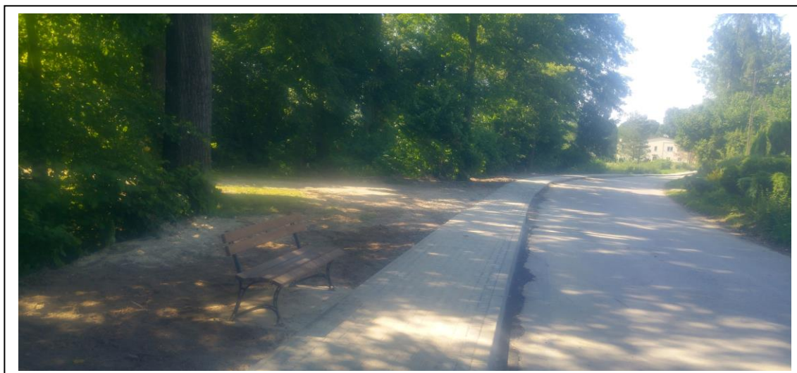
Fot. 24. Chodnik przy drodze gminnej w Wojciechowie.
