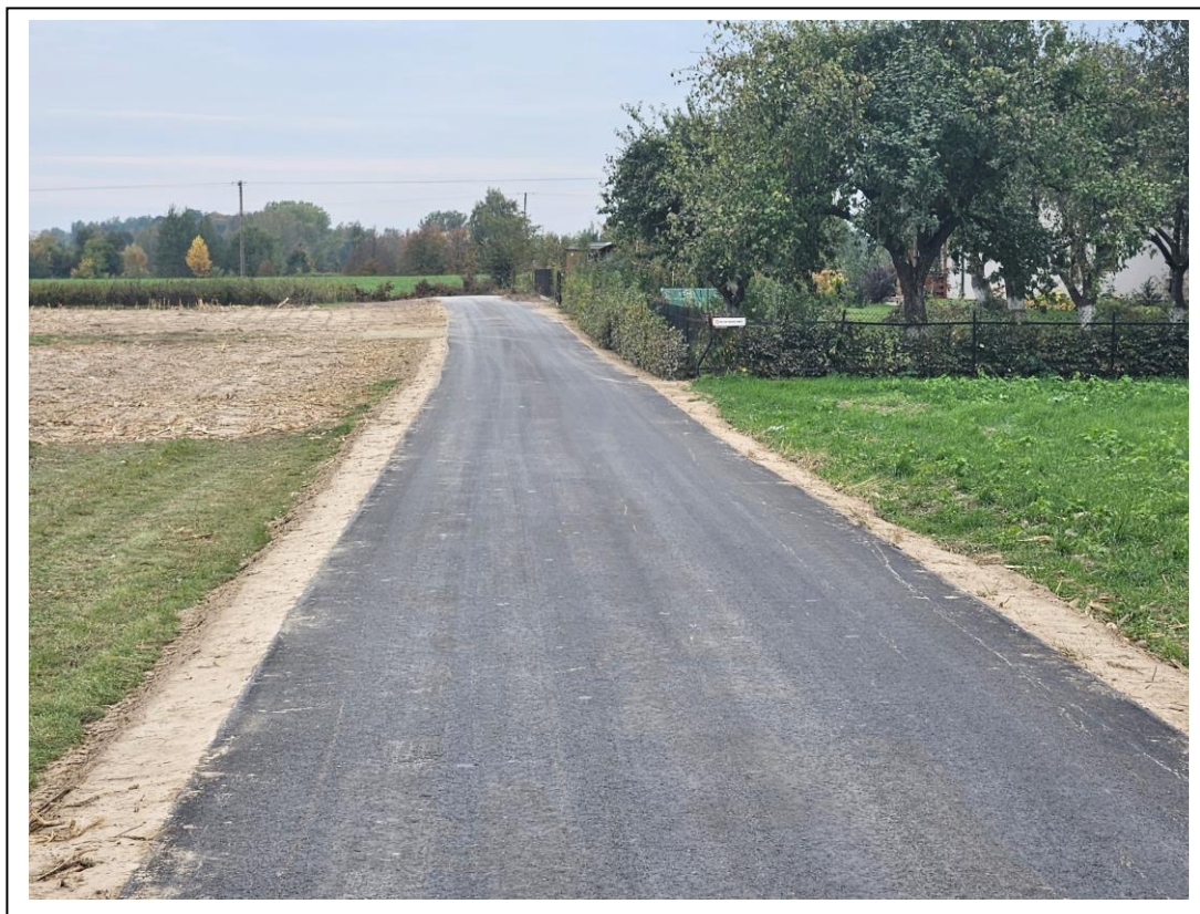
Fot. 7. Przebudowany odcinek drogi gminnej nr 106910L w miejscowości Stary Gaj na długości 500 m.
