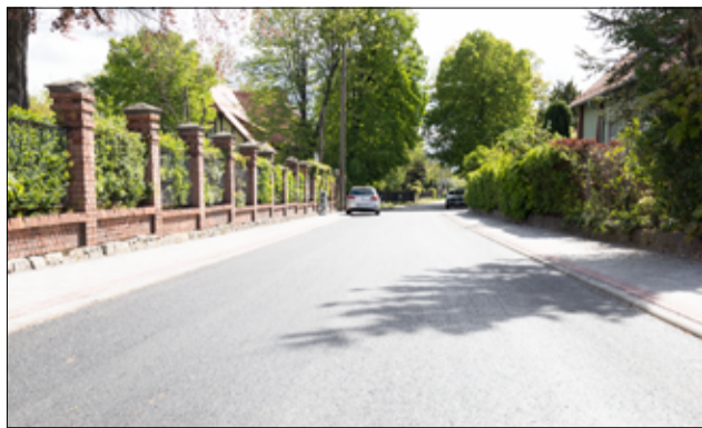
Droga przy ul. Hutniczej w Żarowie po zakończonym remoncie.
