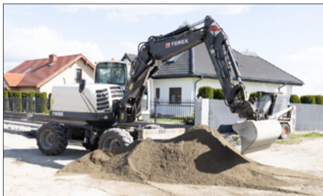
Intensywne prace drogowe prowadzimy teraz na Osiedlu Piastowskim przy ul. Ks. Jadwigi w Żarowie.
