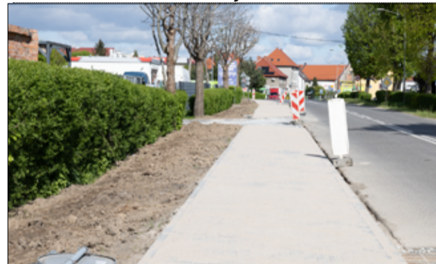
Nowe przejście dla pieszych oraz chodnik zlokalizowane będą również przy ul. Armii Krajowej, od stacji paliw w kierunku Bożanowa.
